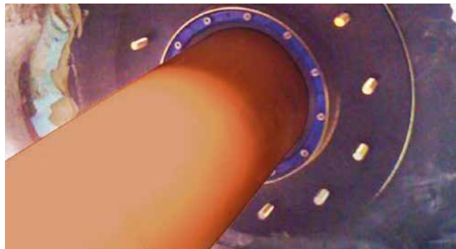
HSD-C 200/159w ocynkowanym kołnierzu uszczelniająco-mocującym
