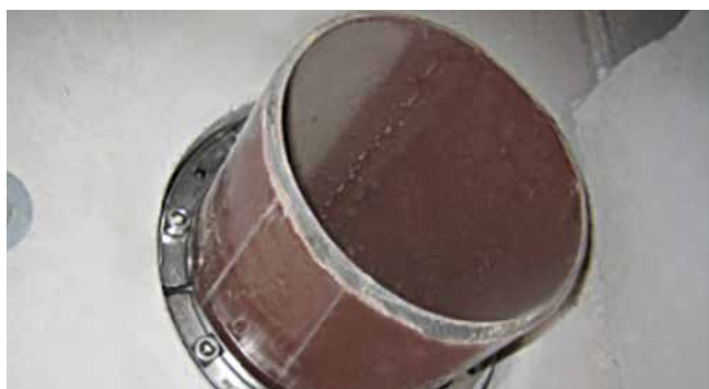
HSD200 1x160 b40 A2/EPDM55 instalacja odwodnienia deszczowego
