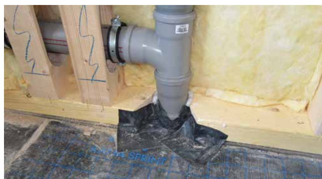
trudności z wykonaniem skutecznej izolacji
