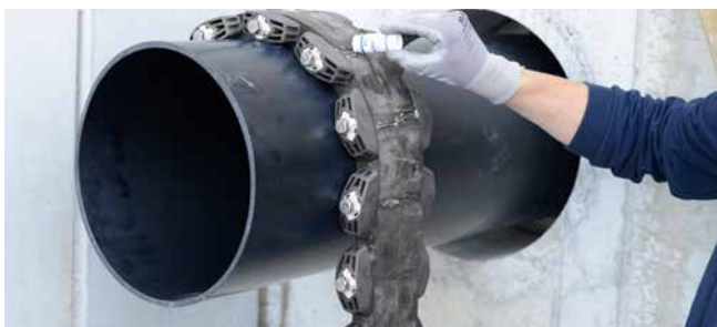
GKD400 – aplikacja środka poślizgowego GM – przygotowanie do montażu
