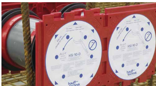
pakiet dwustronnych przepustów HSI90 zamocowany w szalunku
