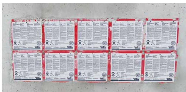
pakiet zabetonowanych przepustów HSI150 po rozszalowaniu
