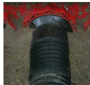
uszczelnienie rur karbowanych pokrywą systemową z opaskami zimnokurczliwymi HSI150 D1x110 KS WR
