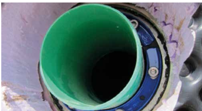
HSD-C 150/110 w ocynkowanym kołnierzu uszczelniająco-mocującym
