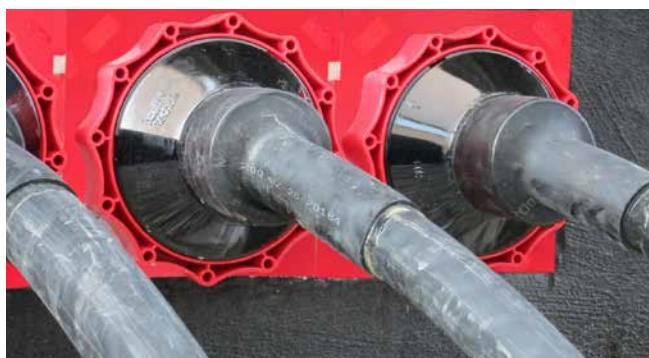
stacja kontenerowa: kable niskiego napięcia uszczelnione za pomocą HSI150 D1x80 WS
