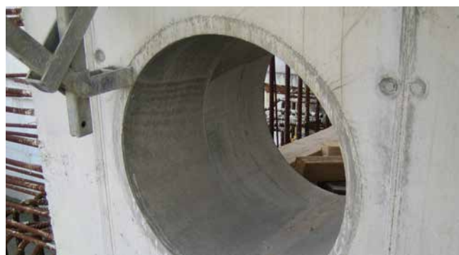
FZR400/300 zabetonowana w zbiorniku oczyszczalni ścieków
