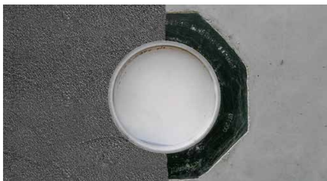
zabetonowany UFR z naniesioną powłoką hydroizolacyjną
