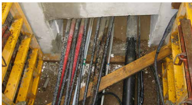
ukośne ułożenie rur i przewodów w otworze
