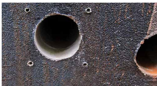
przewiert i otwory kołków rozporowych
