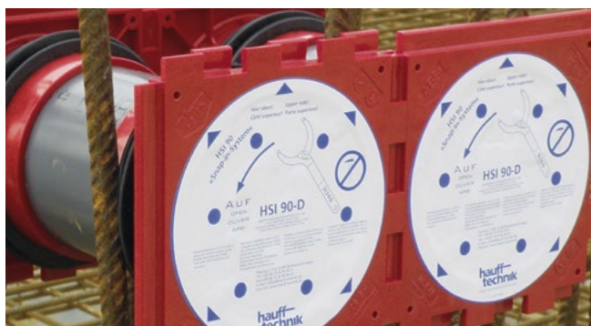
pakiet dwustronnych przepustów HSI90 zamocowany w szalunku
