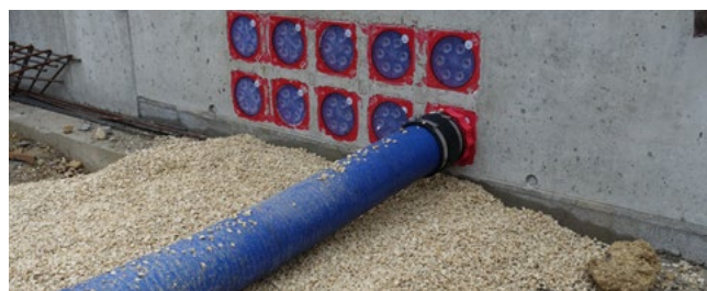
zastosowanie z pokrywami systemowymi KES MA150 D
