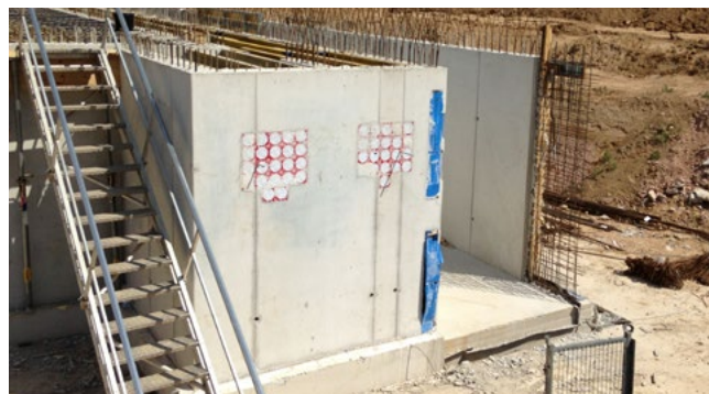
HSI 90 po zabetonowaniu
