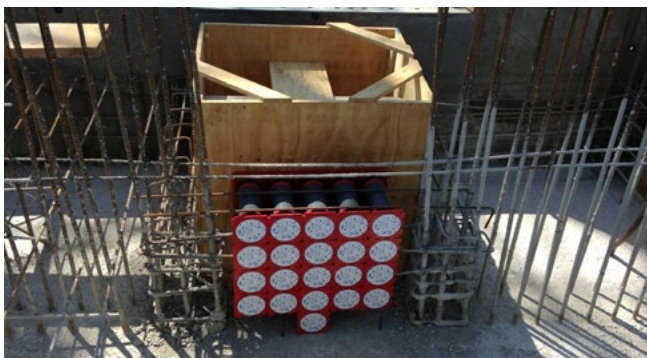
dwustronne przepusty kablowe HSI90 przed zabetonowaniem
