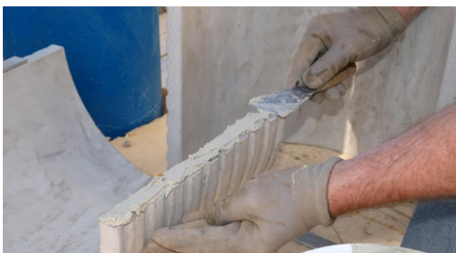
FZRG350/300 nanoszenie kleju epoksydowego MSET FZRG
