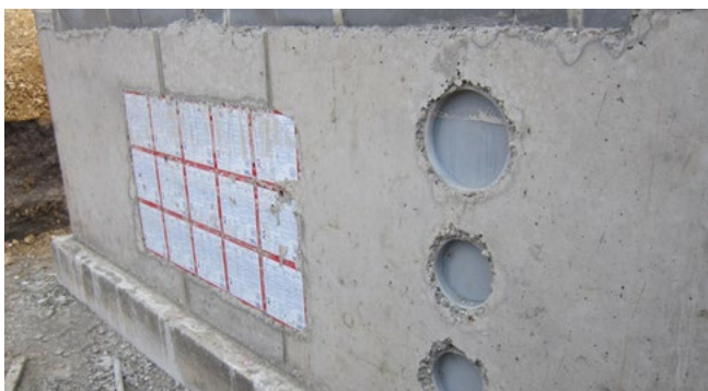
ZVR150 i ZVR200 zabetonowane obok przepustów HSI150
