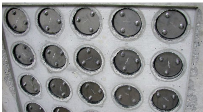
FZR100/240 po zabetonowaniu w oknie technologicznym, zaślepienie gumowymi wkładami zaślepiającymi
