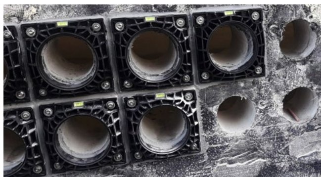
montaż flansz na przygotowanych otworach
