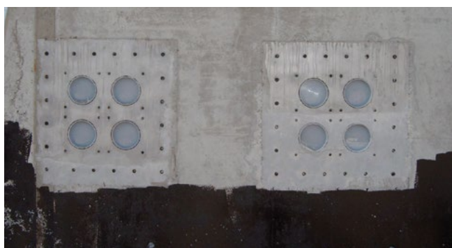
zabetonowany przepust HSI150 2x2 FLFE/X od strony aplikacji powłoki hydroizolacyjnej
