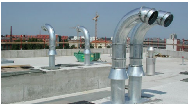
zamocowane do powierzchni stropo-dachu przepusty SHD 200
