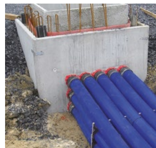
przyłączenie rury osłonowej Hateflex do zabetonowanego przepustu za pomocą pokrywy systemowej KES MA90 D
