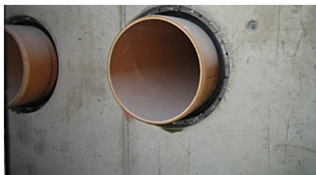
HSD500 G 1x429 b40 A2/EPDM55 napowietrzanie/odpowietrzanie
