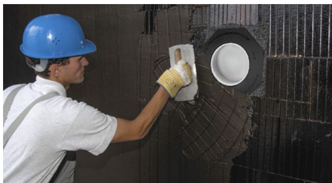
zabetonowany UFR z naniesioną powłoką hydroizolacyjną
