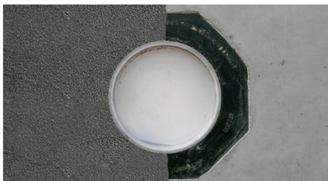
zabetonowany UFR z naniesioną powłoką hydroizolacyjną
