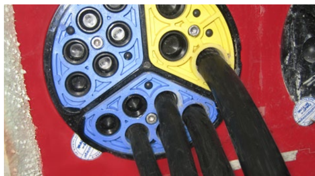
HSI150 – SEGMENTO – punkty kontroli poprawności montażu wraz z fabrycznymi zaślepkami niewykorzystanych otworów
