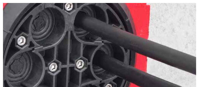
Abdichtung mit Systemdeckel HSI150 DG
