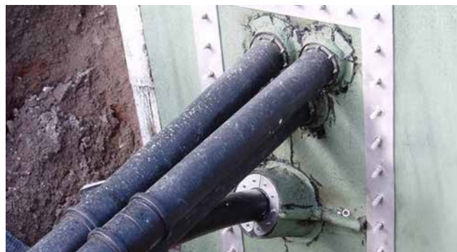
Geteilter Fest-/Losflansch in Anlehnung an DIN 18533
