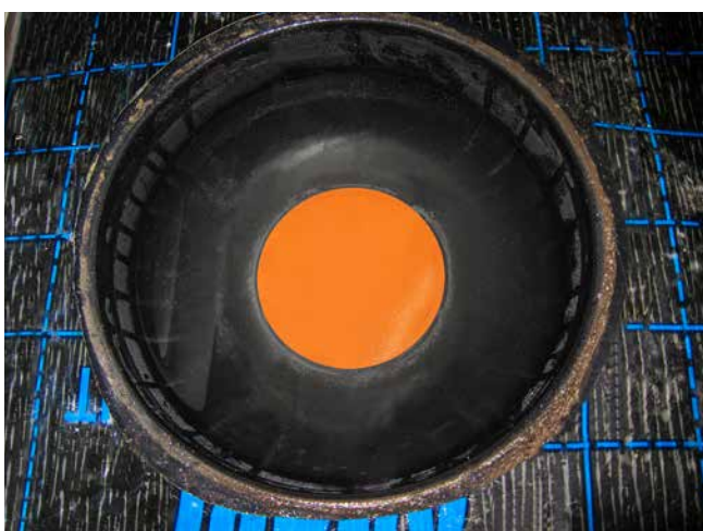
Einfache Einbindung der Dampfsperre über Anarbeitsflansch
