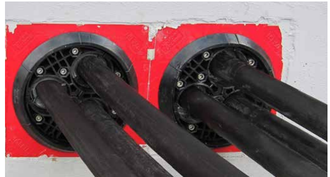
Verschiedene Montageschritte bei HSI150 DG 3x24-54
