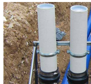
Reihenanzordnung 2x KES150 MA ZVR150/500 an der Aufstellvorrichtung KES FUBO-FIX AV
