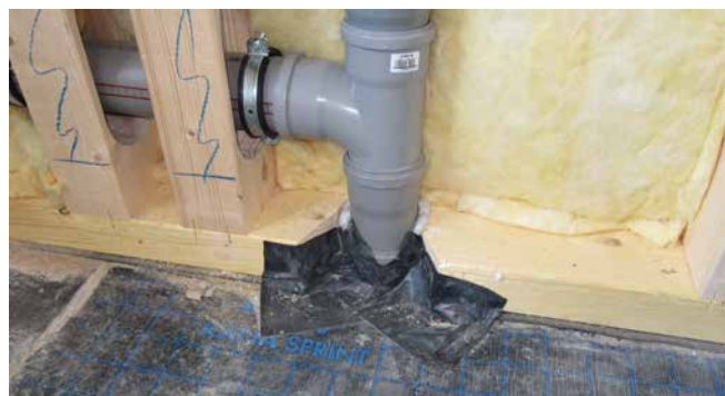
Schwierigkeit: Einbindung der Dampfsperre
