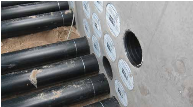
HSI150 GSM eingebaut
