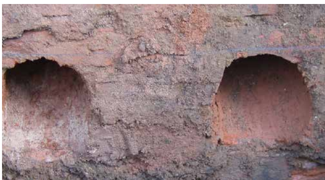
Schräge Kernbohrung in porösem Mauerwerk
