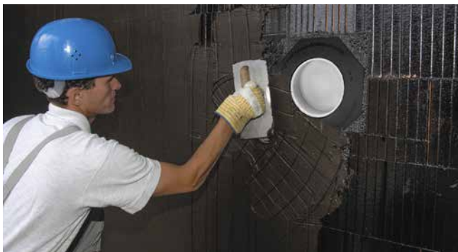
Betoniertes UFR mit PMBC
