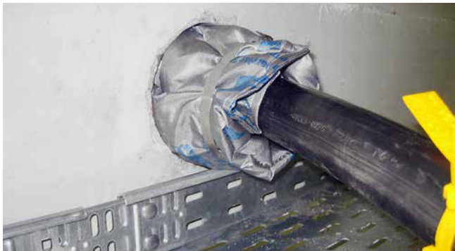
HSS – Einbau in Kernbohrung mit HRD Ringraumdichtungen
