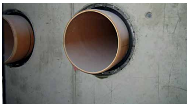
HSD500 G 1x429 b40 A2/EPDM55 Be-/Entlüftung
