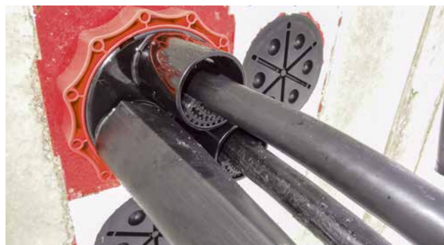
Zentrierband im Systemdeckelstutzen des HSI150 D3x58 WS
