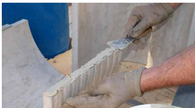
FZRG350/300 mit Spachtelmasse aus Montageset MSET FZRG
