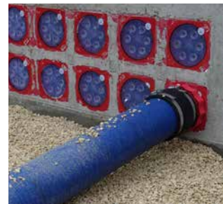
Druckdichter Anschluss an die HSI150-Dichtpackungen
