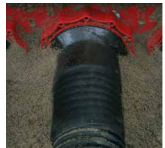
Wellrohranschluss mit Kaltschrumpftechnik HSI150 D1x110 KS WR
