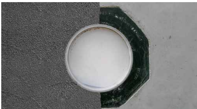
Betoniertes UFR mit PMBC
