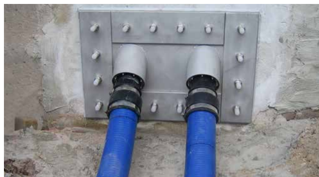
Fest-/Losflansch mit schräger Leerrohranbindung vor Flächenabdichtung
