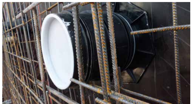
UFR in Schalung
