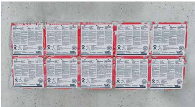
Doppeldichtpackung HSI150 als Paket
