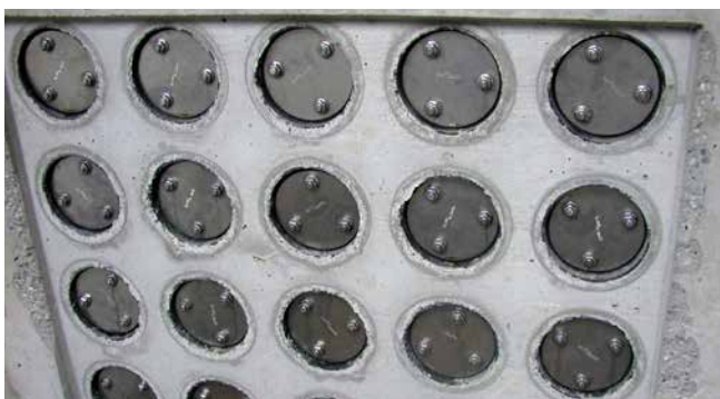
FZR100 / 240 Abdichtung Rohrtrasse
