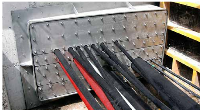
Geteilter Rechteck-Flansch mit Mehrfachbelegung
