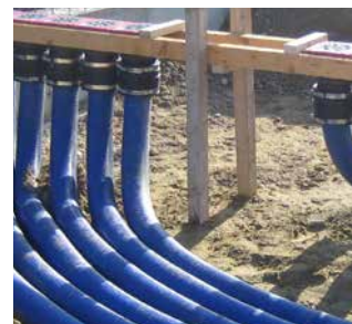
Reihenanzordnung 2x KES150 MA ZVR150/500 an der Aufstellvorrichtung KES FUBO-FIX AV
