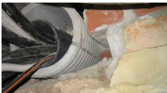
FZRG150 / 350 Sanierung im Mauerwerk
