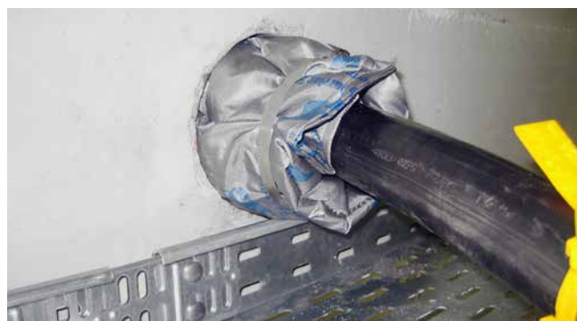
HSS – Einbau in Kernbohrung mit HRD Ringraumdichtungen
