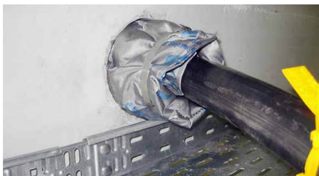
HSS – Einbau in Kernbohrung mit HRD Ringraumdichtungen
