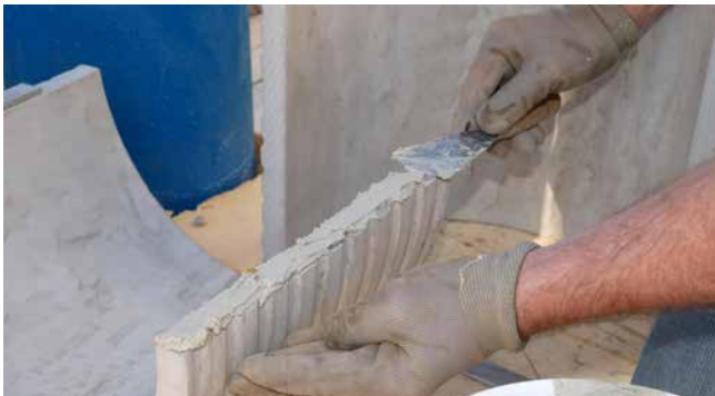
FZRG350/300 mit Spachtelmasse aus Montageset MSET FZRG
