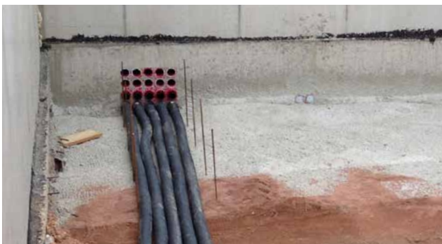
Wellrohranschluss HSI90 D1x75 KS WR
