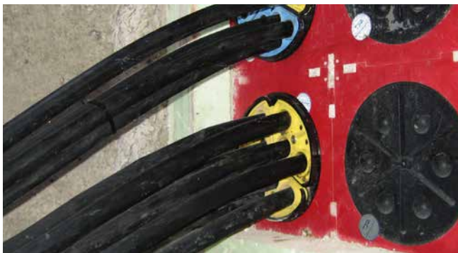
Abdichtung von Kabeln für Straßenbeleuchtung mit SEGMENTO
