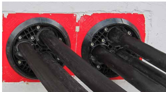
Verschiedene Montageschritte bei HSI150 DG 3x24-54
