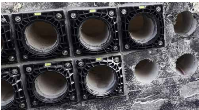
Kernbohrung und Dübellöcher
