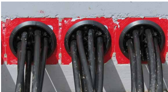
Abdichtung von Niederspannungskabeln mit HSI150 DG 6x10-36
