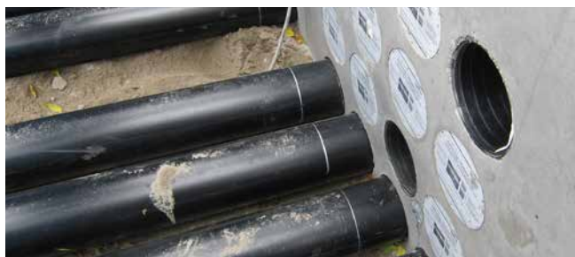
HSI150 GSM Varia als Paket eingesetzt
