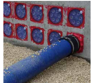
Druckdichter Anschluss an die HSI150-Dichtpackungen
