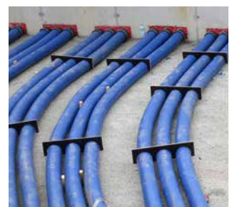
KES MA150 D und Spiralschlauch Hateflex14150
