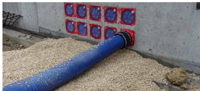
Anschluss des Kabeleinführungssystems KES MA150 D
