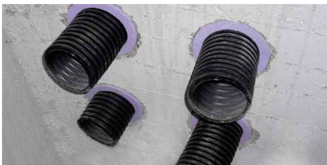
Ansicht Gebäudeinnenseite (Isoring)
