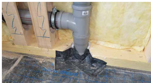
Schwierigkeit: Einbindung der Dampfsperre
