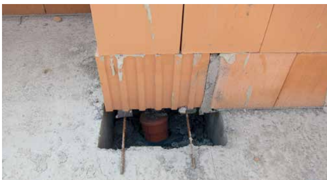
Schwierigkeit: nachträglicher gas- und dampfdichter Verschluss
