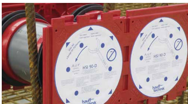
Doppeldichtpackung HSI90 als Paket in Schalung eingesetzt
