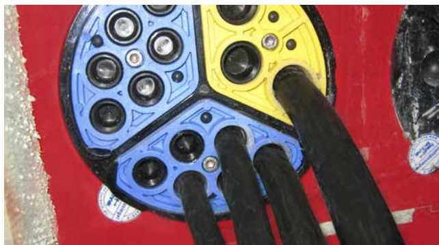
HSI150 SEGMENTO mit integrierter Drehmomentkontrolle und Blindstopfen
