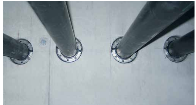
HSD125 1x75 b20 A2/EPDM55 Leerrohranbindung
