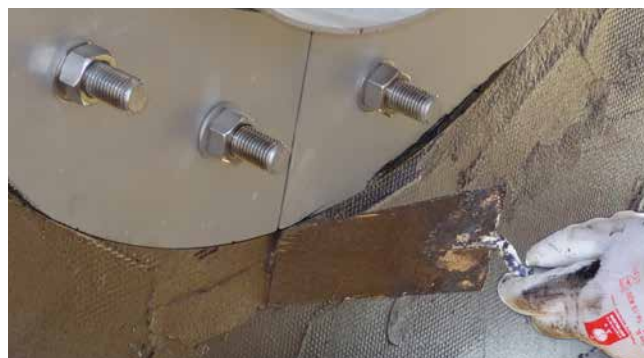
FLFE 1x200/X Edelstahlausführung mit Anbindung an PMBC mittels Vlies-Zulage
