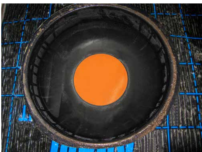
Einfache Einbindung der Dampfsperre über Klebeflansch
