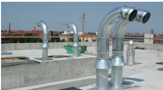
Montierte SHD200 vor Verlegung der Dachabdichtung
