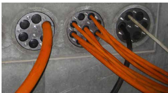
HRD150 SG eingebaut in Faserzementfutterrohre
