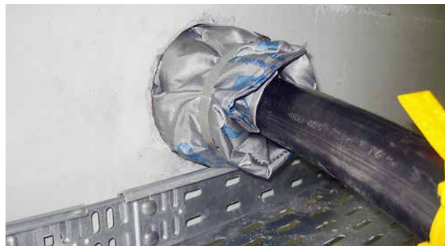
HSS – Einbau in Kernbohrung mit HRD Ringraumdichtungen
