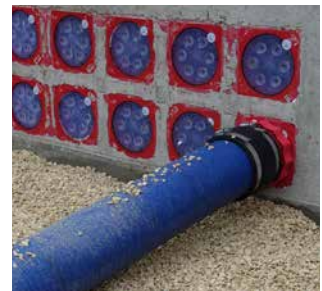
Druckdichter Anschluss an die HSI150-Dichtpackungen
