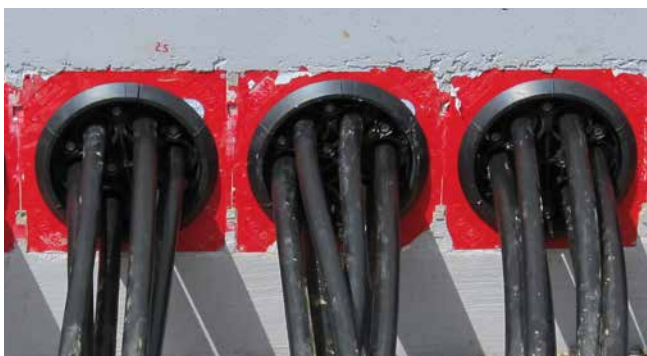
Abdichtung von Niederspannungskabeln mit HSI150 DG 6x10-36
