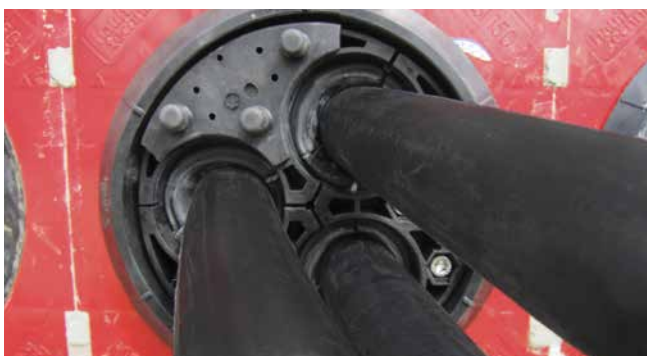
Pressplattenabdeckung HSI150 DG PA 3x24-54
