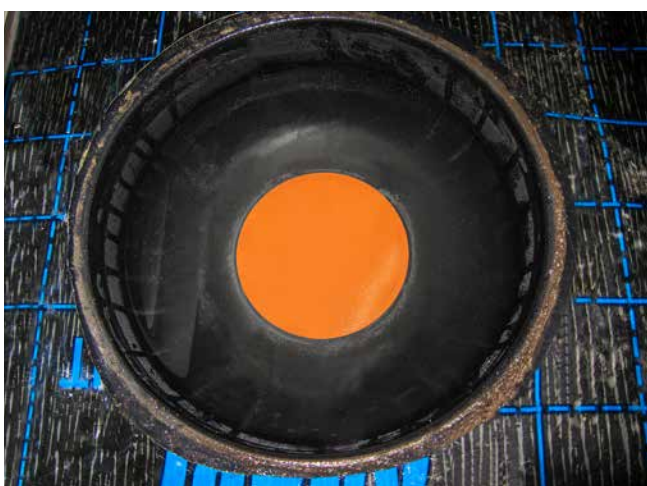
Einfache Einbindung der Dampfsperre über Klebeflansch
