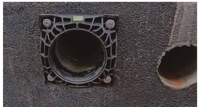
HSI150 DFK Kunststoffflansch
