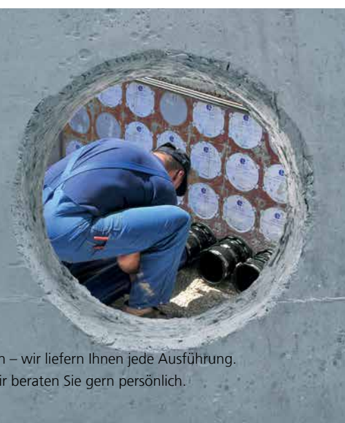
Herstellen von vertikal und horizontal verlaufenden Diamantschrägböhrungen für die Aufnahme von HRD-Dichteinsätzen
