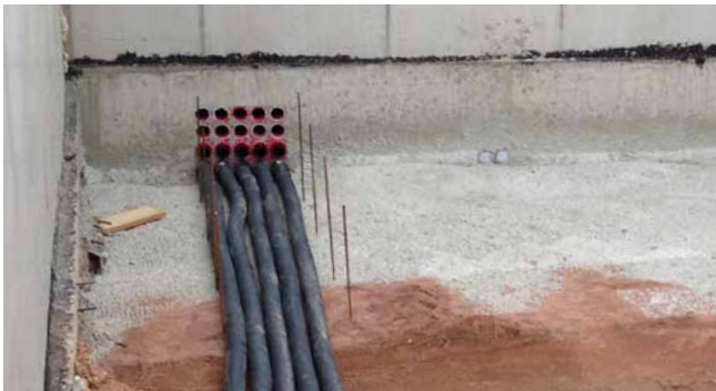
Wellrohranschluss HSI90 D1x75 KS WR
