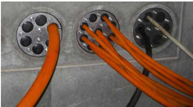
HRD150 SG eingebaut in Faserzementfutterrohre
