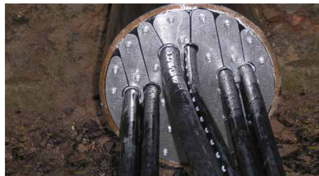
HRD200 G b30 in einem Stahlrohr
