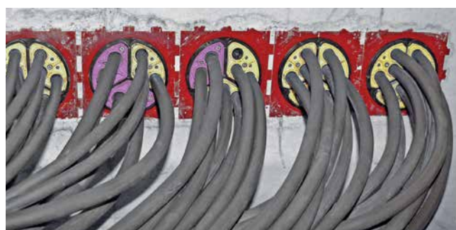
Kabelzug durch HSI-Dichtpackungen mit SEGMENTO-Systemeinsätzen
