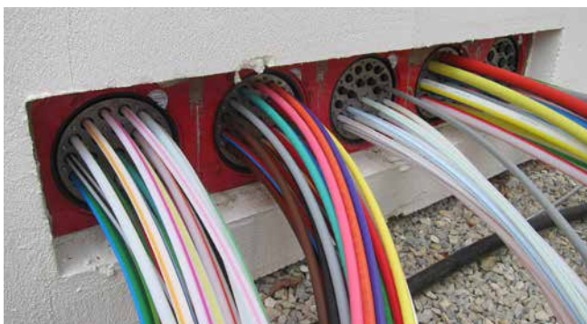
HSI150 Dichtpackung, abgedichtet mit HRD150 21x14 b60 A2/EPDM55
