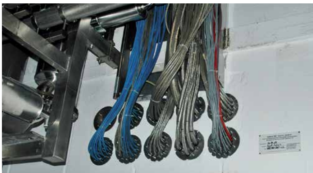
HRD150 G b30 mit Mehrfachbelegung
