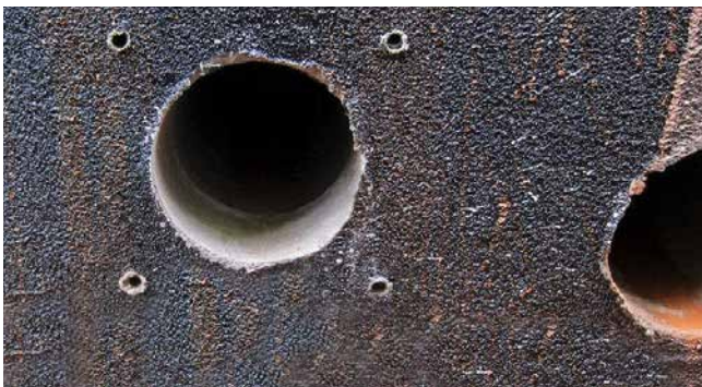
Kernbohrung und Dübellöcher
