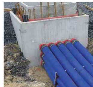
KES MA90 D – Anschluss an Dichtpackung HSI90
