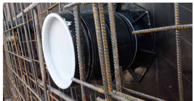
UFR in Schalung
