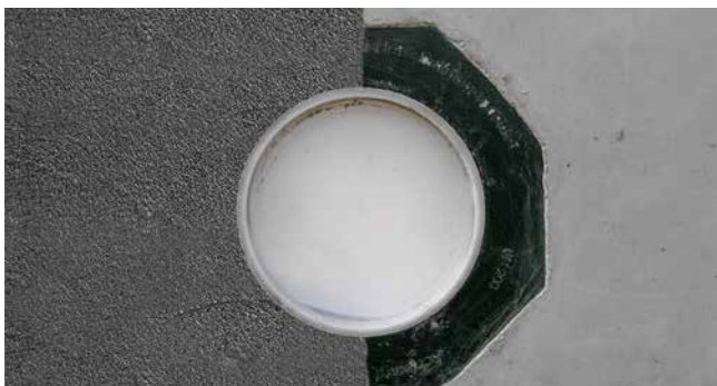
Betoniertes UFR mit PMBC
