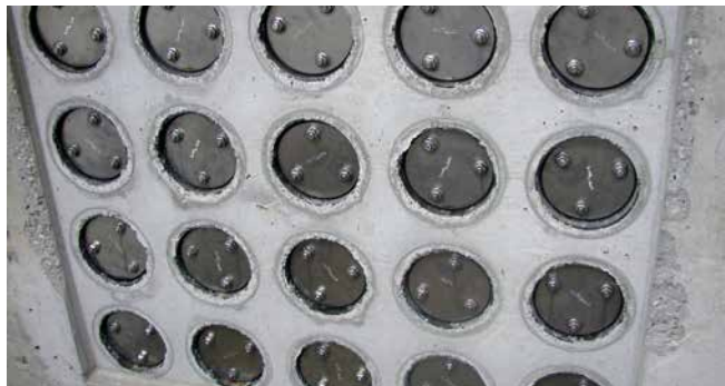
FZR100/240 Abdichtung Rohrtrasse
