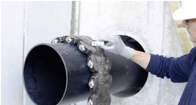
GKD400 - Montagevorbereitung mit Gleitmittel GM
