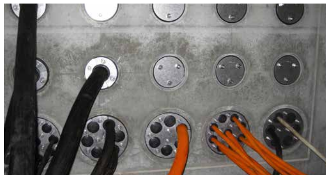
HRD150 SG eingebaut in Faserzementfutterrohre
