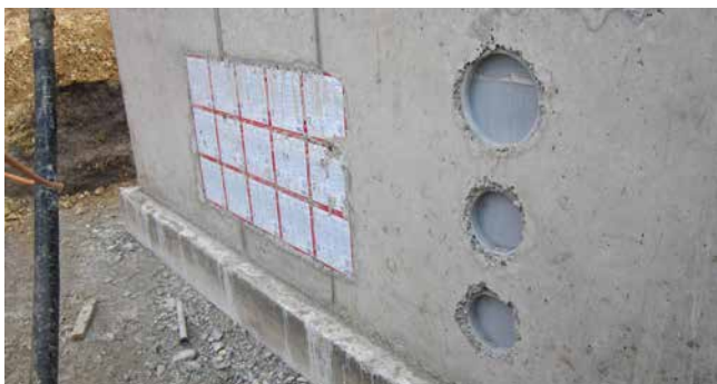
ZVR150 und ZVR200 einbetoniert neben HSI150
