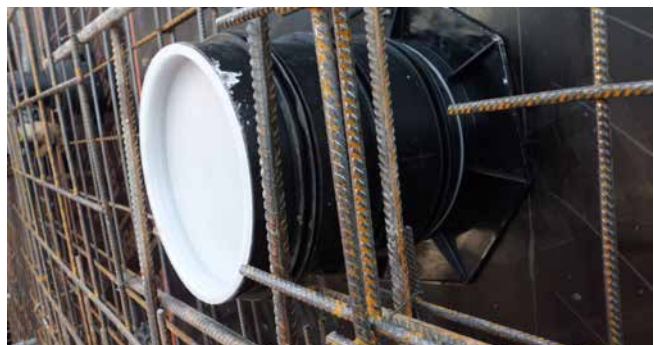
UFR in Schalung
