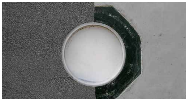
Betoniertes UFR mit PMBC
