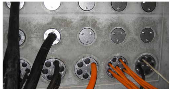
HRD150 SG eingebaut in Faserzementfütterrohre
