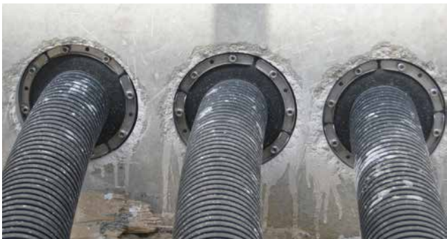
Detailansicht: Clipring/Dichtung
