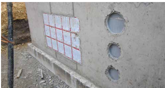
ZVR150 und ZVR200 einbetoniert neben HSI150
