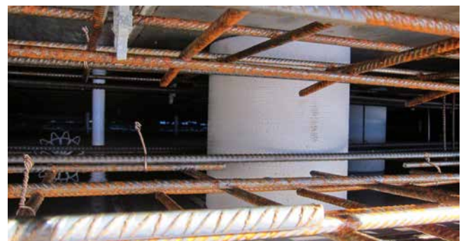
ZVR200/300 in der Schalung fixiert
