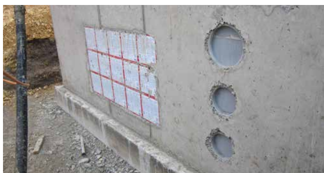
ZVR150 und ZVR200 einbetoniert neben HSI150
