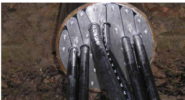
HRD200 G b30 in einem Stahlrohr
