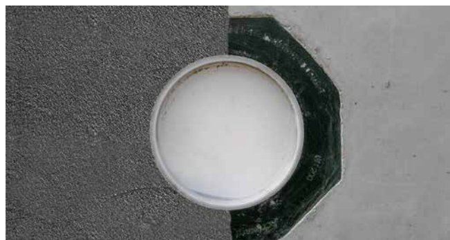
Betoniertes UFR mit PMBC
