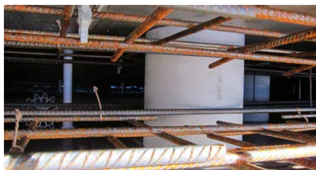
ZVR200/300 in der Schalung fixiert
