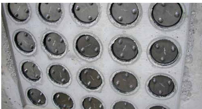
FZR100/240 Abdichtung Rohrtrasse
