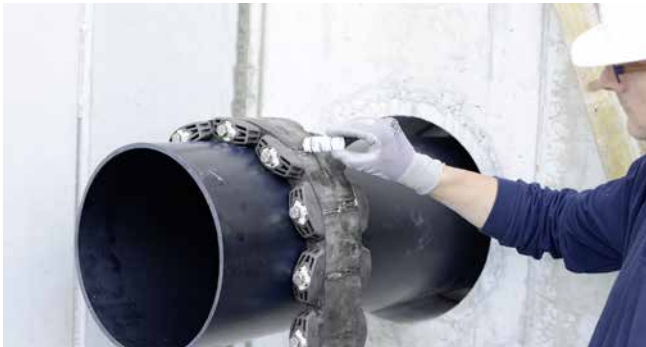
GKD400 - Montagevorbereitung mit Gleitmittel GM
