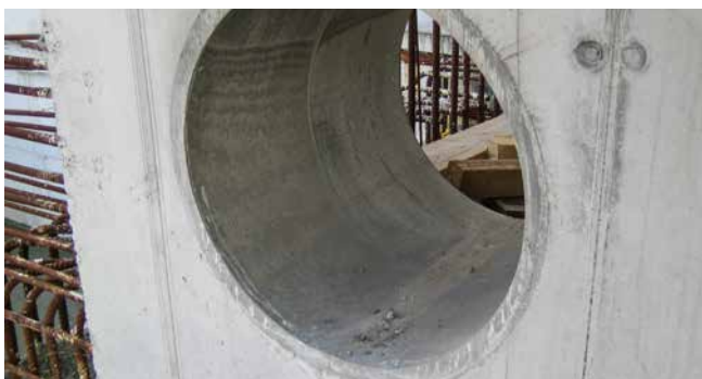
FZR400/300 Einbauort Kläranlage
