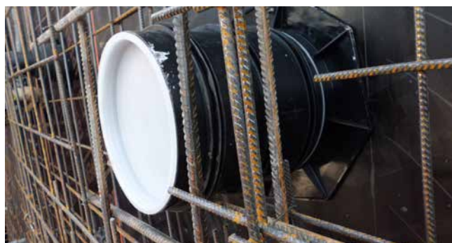
UFR in Schalung
