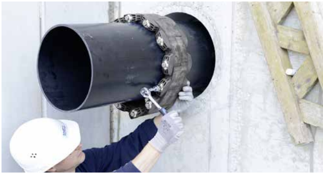
GKD400 - vastdraaien van de segmenten
