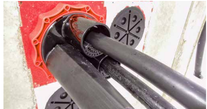
centreerband in tuiten van systeemdeksel HSI150 D3x58 WS
