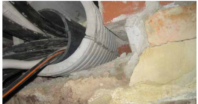
FZRG150/350 - renovatie in het metselwerk
