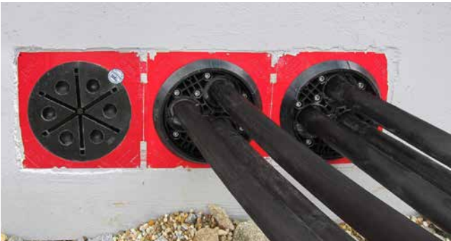
diverse montage stappen bij HSI150 DG 3x24-54
