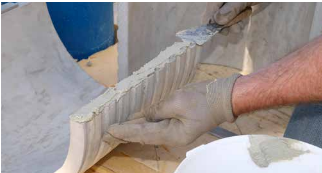
FZRG350/300 met vulmiddel uit montageset MSET FZRG
