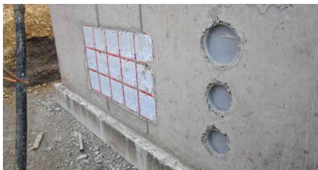
ZVR150 en ZVR200 ingebed in beton naast HSI150
