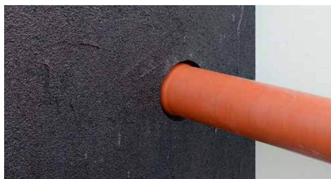
Praktisch beeld van UDM/UDME geïnstalleerd met PMBC-coating en aangesloten KG-buis
