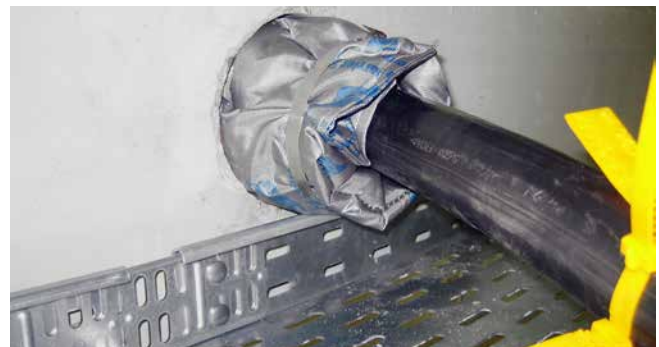
HSS - inbouw in kernboringen met HRD rubberafdichtingen
