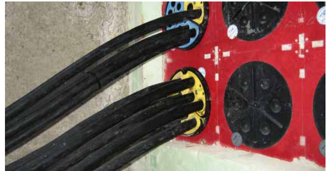
afdichting van kabels voor straatverlichting met SEGMENTO
