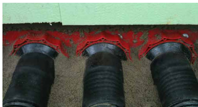
geribde mantelbuizen met koude HSI150 D1x110 KS WR
