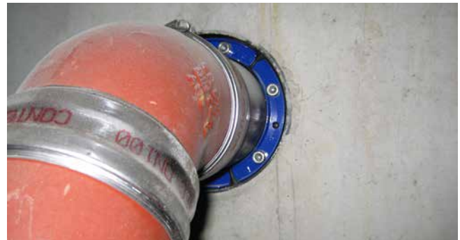
HSD200 C 1x159 b40 A2/EPDM5 5 in verzinkte vaste en losse flens
