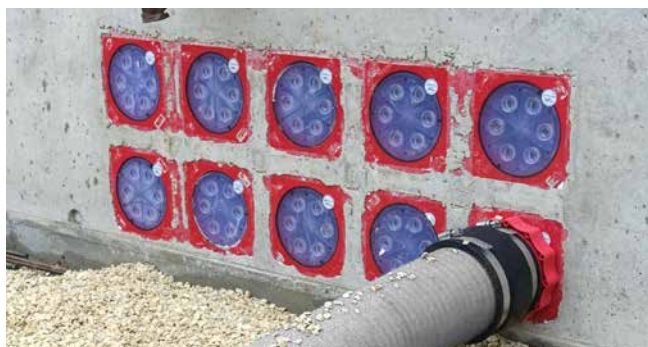
drukdichte aansluiting op de HSI150-afdichtpakkingen
