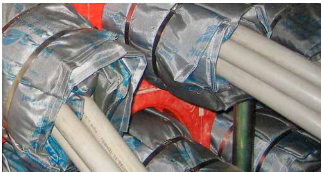
HSS - inbouw van brandbeveiligingskussens in instortpakking HSI150-K2, afdichting met systeemdekseel of Segmento
