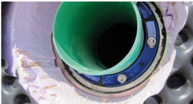
HSD150 C 1x110 b40 A2/EPDM55 n verzinkte vaste en losse flens
