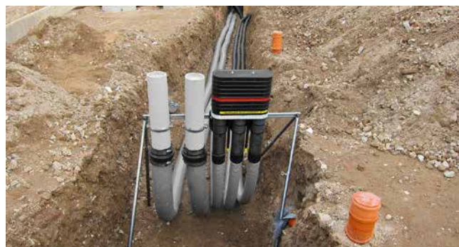
2x KES90 MA ZVR100/500 het plaatsingsframe KES FUBO-FIX AV
