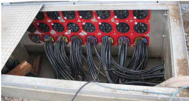
HSI150 - doorvoer uitgerust met SEGMENTO afdichtingsysteem voor stuurkabels in een schakelhuis
