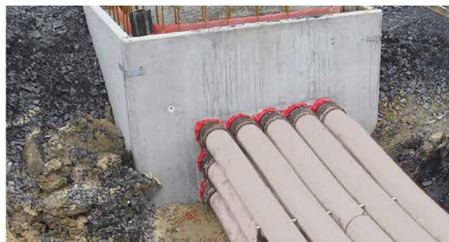
KES MA90 D - aansluiting aan dichtpakking HSI90
