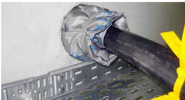
HSS - inbouw in kernboringen met HRD rubberafdichtingen
