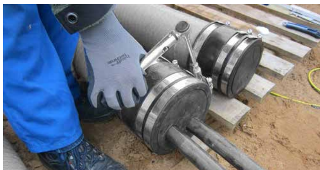
kit d'étanchéité KES90 MA WE100 SG 1x18-65 SET pour étanchement de câbles à l'extrémité de la gaine de câble
