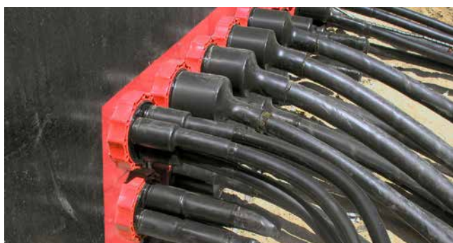
stationsuitvoering: laagspanningskabel afgedicht met HSI90 D1x75 WS en HSI90 D3x32 WS
