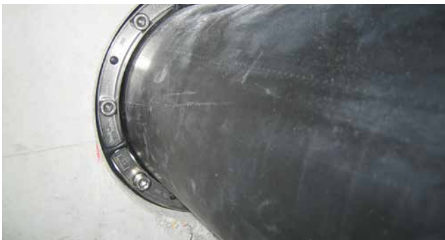
Gedetailleerd overzicht - HSD, inspectieopening en aanhaalvolgorde van de schroeven
