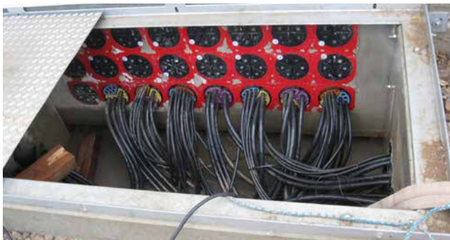
HSI150 - doorvoer uitgerust met SEGMENTO afdichtsysteem voor stuurkabels in een schakelhuis
