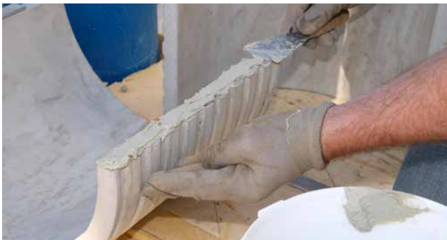
FZRG350/300 met vulmiddel uit montageset MSET FZRG
