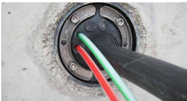
HSD100 EW geïnstalleerd
