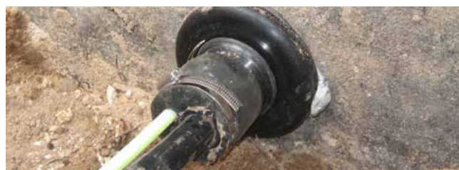
MIS90D geïnstalleerd
