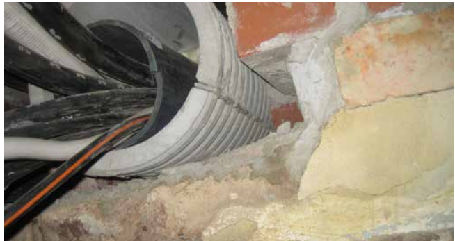
FZRG150/350 - renovatie in het metselwerk
