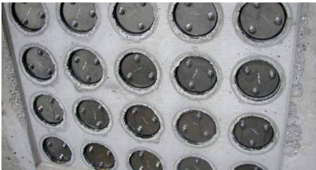
FZR100/240 afdichting buistraject
