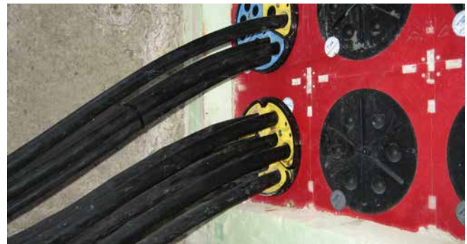
afdichting van kabels voor straatverlichting met SEGMENTO
