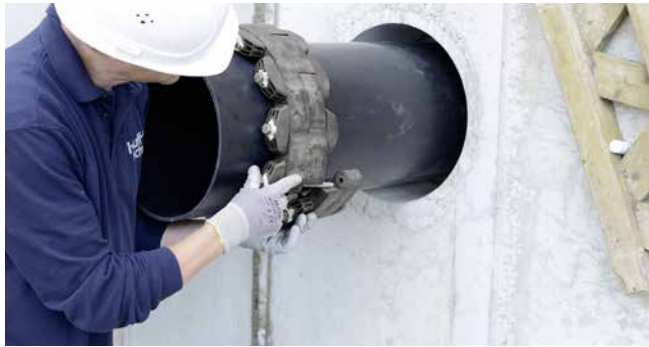
GKD400 - aanbrengen van de segmenten
