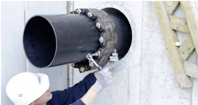
GKD400 - vastdraaien van de segmenten
