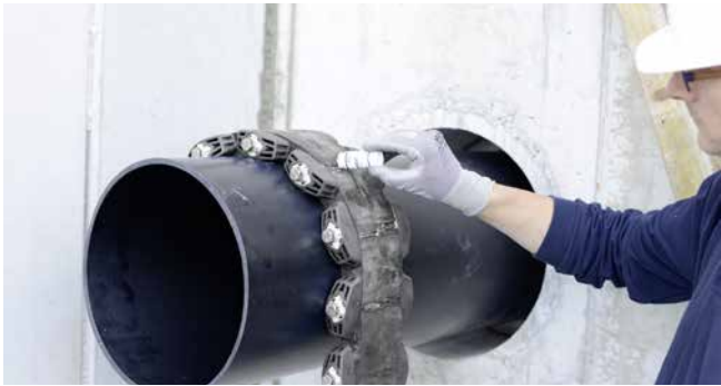
GKD400 - montage voorbereiding met glijmiddel GM
