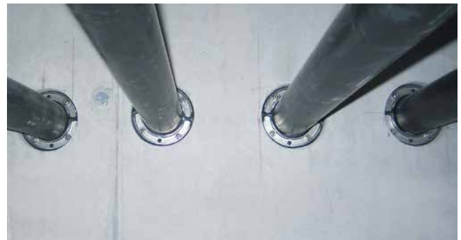
HSD125 1x75 b20 A2/EPDM55 aansluiting lege buis
