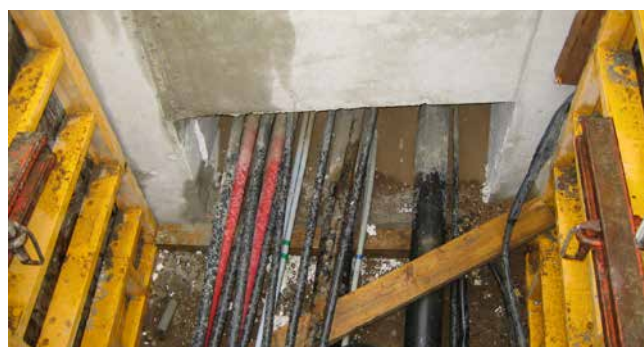
ter plaatse aanwezige rechthoekige uitsparing - moet naderhand worden afdicht
