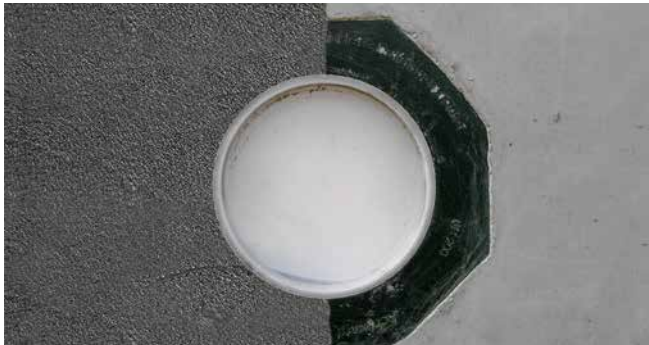
gebetonneerde UFR met PMBC
