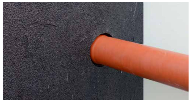
Praktisch beeld van UDM/UDME geïnstalleerd met PMBC-coating en aangesloten KG-buis
