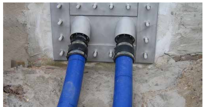
HSD b40 geïnstalleerd
