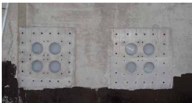
in het beton gestorte vaste flens van de dubbele afdichtpakking HSI150 2x2 FLFE/X
