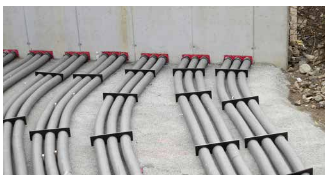
KES MA150 D en spiraalslang Hateflex 14150
