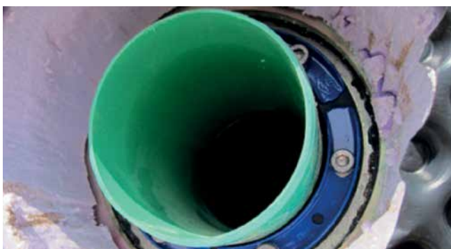
HSD150 C 1x110 b40 A2/EPDM5 n verzinkte vaste en losse flens
