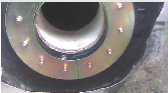
FLFA 1x400/X A3C ontwateringsaansluiting
