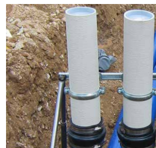
2x KES90 MA ZVR100/500 het plaatsingsframe KES FUBO-FIX AV
