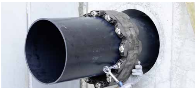
GKD400 – vastdraaien van de segmenten
