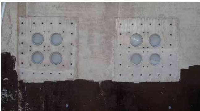
in het beton gestorte vaste flens van de dubbele afdichtpakking HSI150 2x2 FLFE/X
