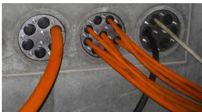
HRD150 SG ingebouwd in vezelcementbuis
