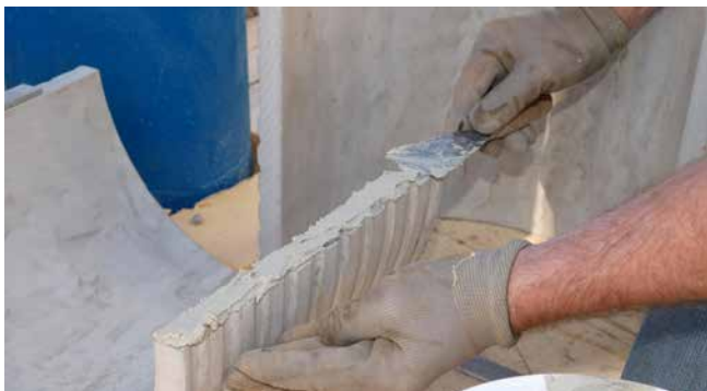
FZRG350/300 met vulmiddel uit montageset Z-FZR-G
