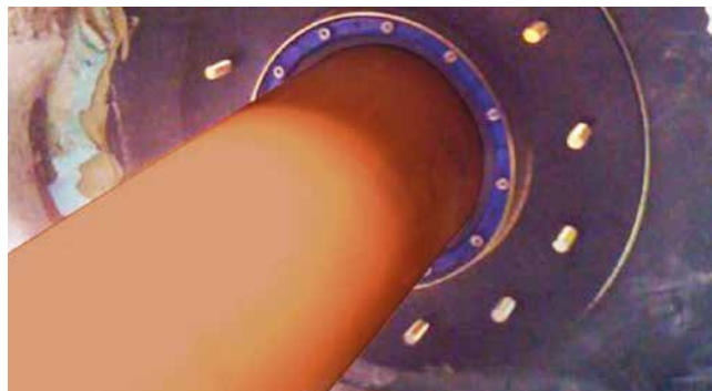
HSD200 C 1x159 b40 A2/EPDM5 5 in verzinkte vaste en losse flens
