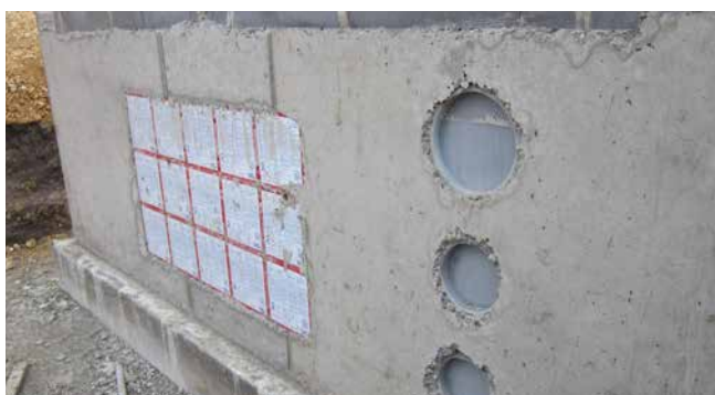
ZVR150 en ZVR200 ingebed in beton naast HSI150
