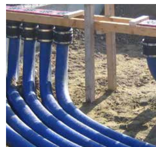
Reeksen met elk 6 x KES-M 150-KVB, voor bodemvoer van de spiraalslang Hateflex 14150
