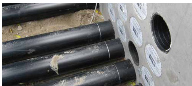
HSI150 GSM Varia als pakket geplaatst
