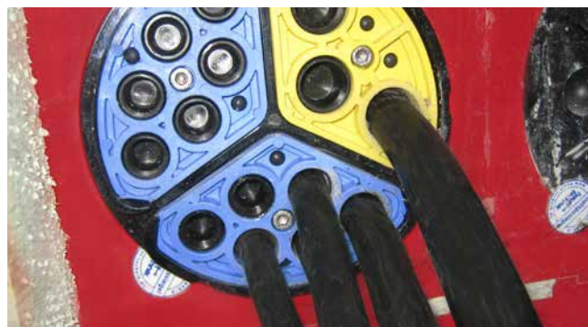
HSI150 – SEGMENTO – met geïntegreerde draaimomentcontrole en blindstoppen
