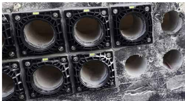
boring en plugopeningen
