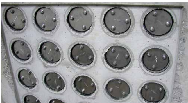
FZR100/240 afdichting buistraject
