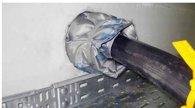
HSS – inbouw in kernboringen met HRD rubberafdichtingen
