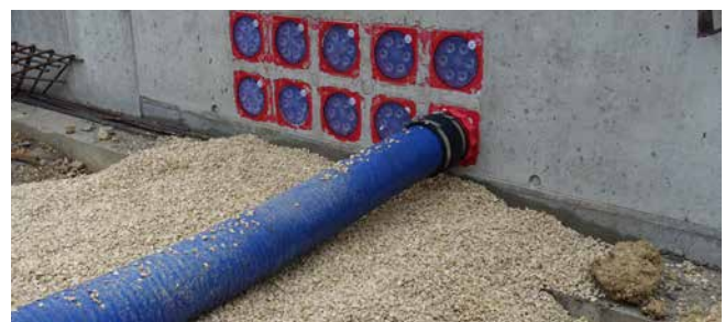
aansluiting van het kabeldoorvoersysteem KES MA150 D
