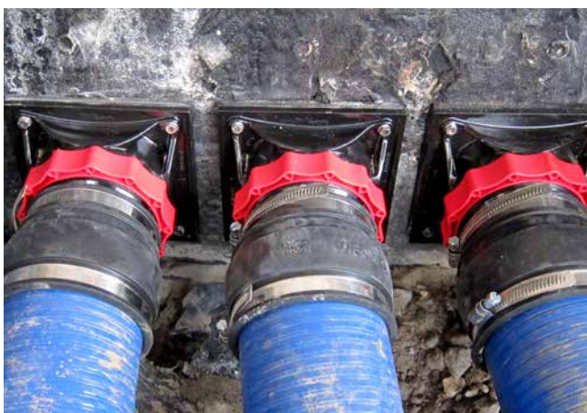
HSI90 DF met aangesloten systeemdeksel HSI90 M 110 WR
