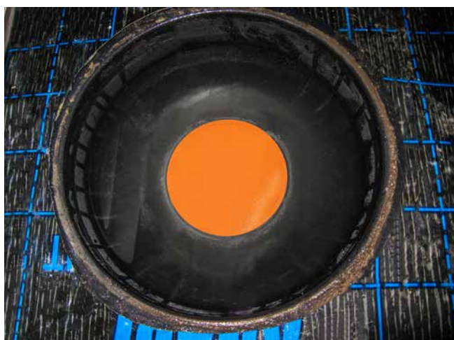
eenvoudige opname van de dampblokkering via lijmflens
