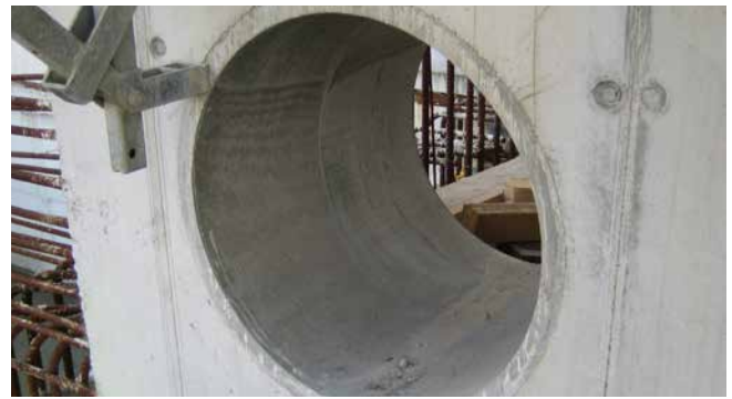
FZR400/300 inbouwlocatie zuiveringsinstallatie
