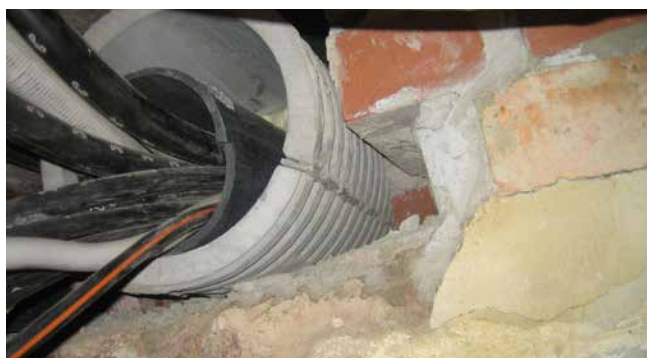
FZRG150/350 renovatie in het metselwerk
