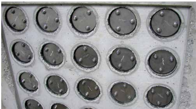
FZR100/240 afdichting buistraject
