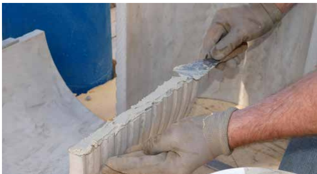
FZRG350/300 met vulmiddel uit montageset Z-FZR-G
