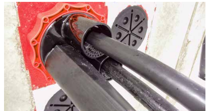
stationsuitvoering: laagspanningskabel afgedicht met HSI150 D1x80 WS centreeband in tuiten van systeemdeksel HSI150 D3x58 WS
