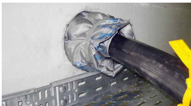
HSS – inbouw in kernboringen met HRD rubberafdichtingen
