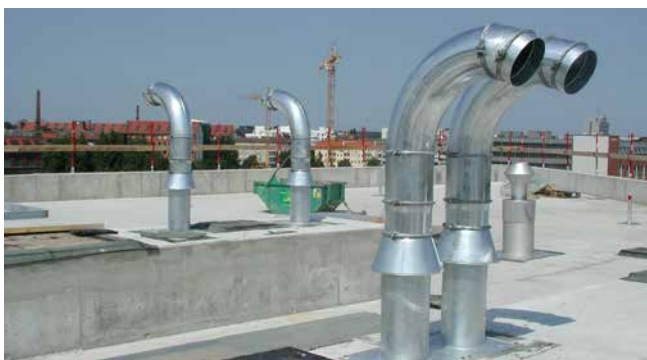
gemonteerd SHD 200 voor verlegging van dakafdichting
