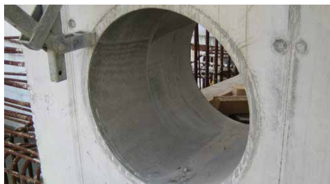
FZR400/300 inbouwlocatie zuiveringsinstallatie
