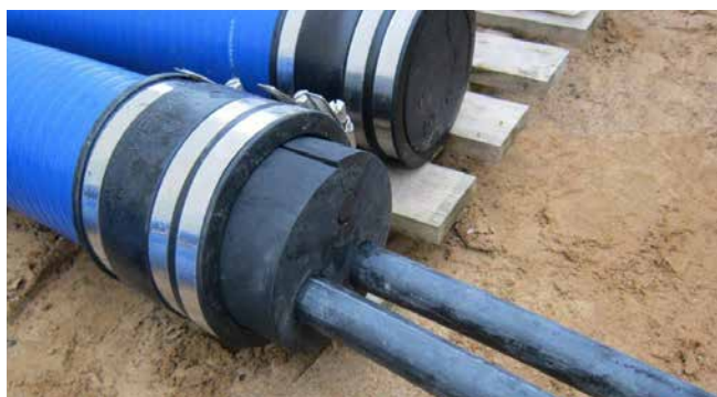
drukdichte aansluiting van de Hateflex-spiraalslang 14150 op de afdichtpakking HSI150 en de afsluitkap voor de mantelbuis
