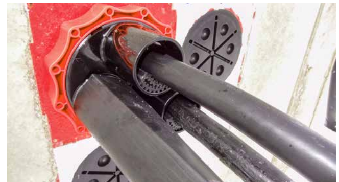
stationsuitvoering: laagspanningskabel afgedicht met HSI150 D1x80 WS centreerband in tuiten van systeemdeksel HSI150 D3x58 WS
