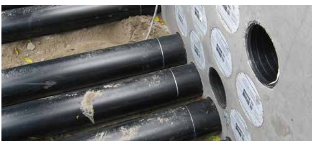
HSI150 GSM Varia als pakket geplaatst
