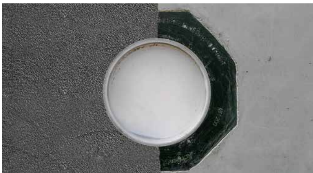
gebetonneerde UFR met PMBC
