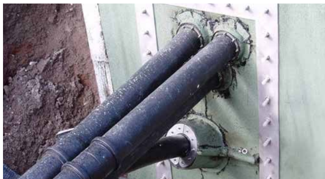
gesplitste vaste/losse flens op basis van DIN 18533
