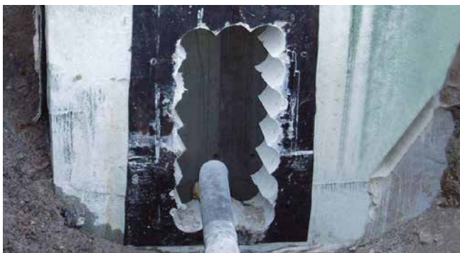
hoogspanningskabels en beschermbuizen moeten naderhand in schachtwacht worden afgedicht
