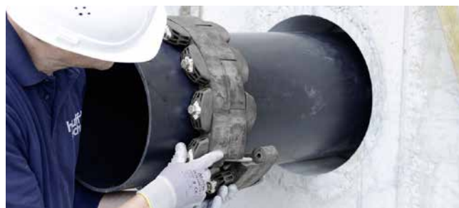
GKD400 – aanbrengen van de segmenten
