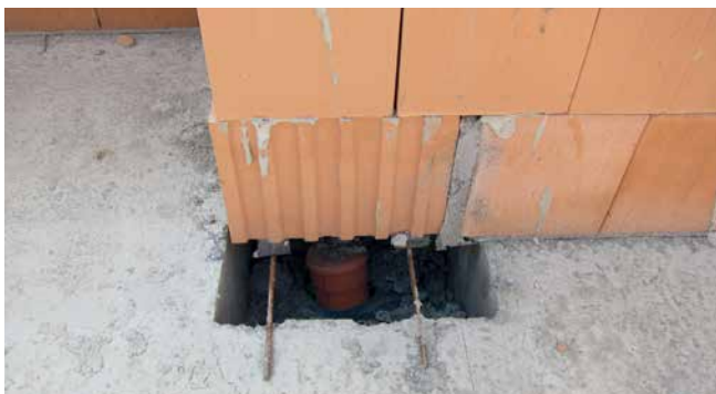
moeilijkheid: naderhand een gas- en dampdichte afsluiting
