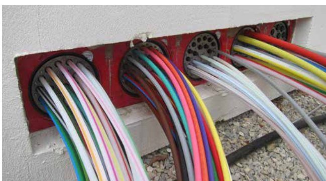
HSI150 Afdichtpakking, afgedicht met HRD150 21x14 b60 A2/EPDM55
