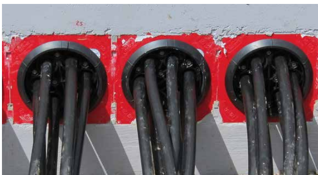
afdichting van laagspanningskabels met HSI150 DG 6x10-36
