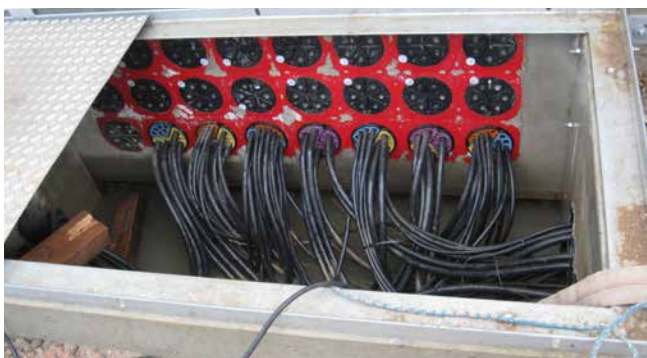
HSI150 - doorvoer uitgerust met SEGMENTO afdichtstelsysteem voor stuurkabels in een schakelhuis
