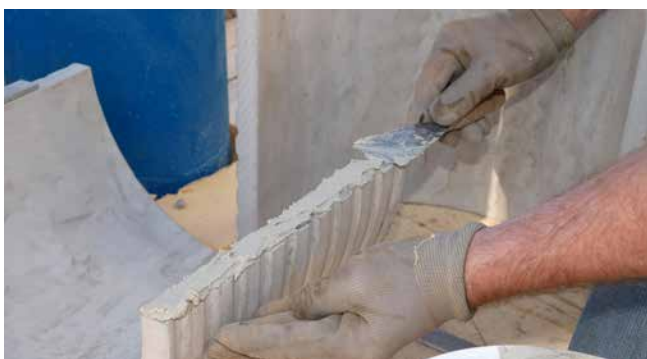
FZRG350/300 met vulmiddel uit montageset Z-FZR-G
