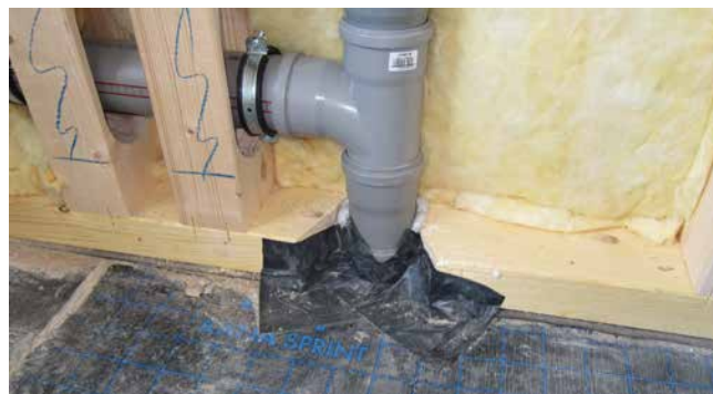
moeilijkheid: opname van de dampblokkering
