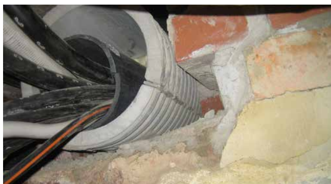
FZRG150/350 renovatie in het metselwerk
