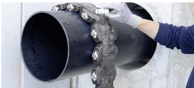
GKD400 – montage voorbereiding met glijmiddel GM
