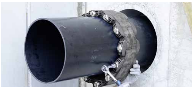
GKD400 – vastdraaien van de segmenten
