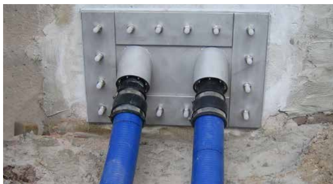
vaste/losse flens met schuine aansluiting lege buis voor oppervlakafdichting
