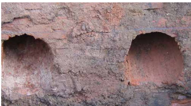
schuine boring in poreus metselwerk
