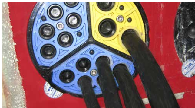
HSI150 – SEGMENTO – met geïntegreerde draaimomentcontrole en blindstoppen
