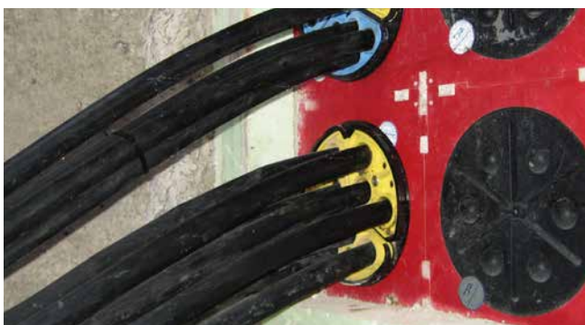
afdichting van kabels voor straatverlichting met SEGMENTO
