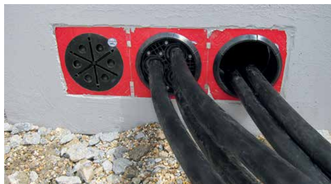
diverse montage stappen bij HSI150 DG 3x24-54
