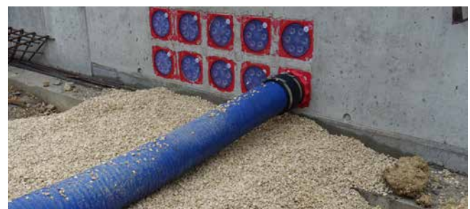
aansluiting van het kabeldoorvoersysteem KES MA150 D
