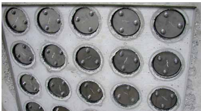
FZR100/240 afdichting buistraject
