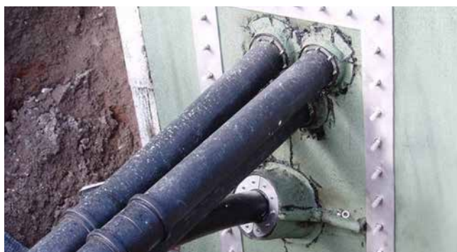
gesplitste vaste/losse flens op basis van DIN 18533
