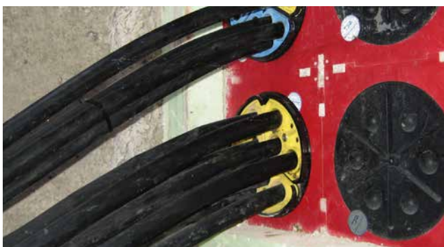
afdichting van kabels voor straatverlichting met SEGMENTO
