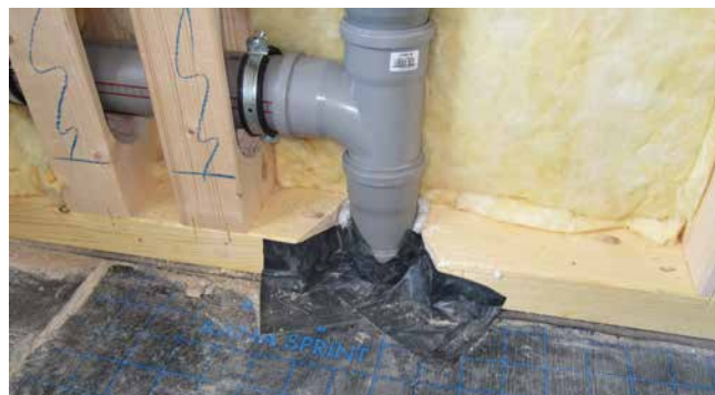
moeilijkheid: opname van de dampblokkering
