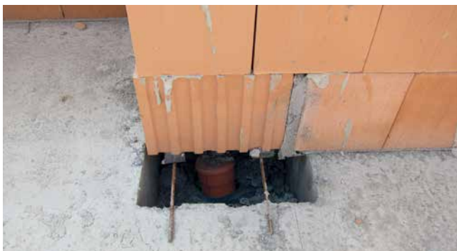
moeilijkheid: naderhand een gas- en dampdichte afsluiting
