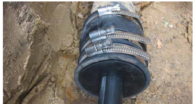
afdichtingsset KES90 MA WE100 SG 1x18-65 SET voor de kabelafdichting aan het uiteinde van de mantelbuis
