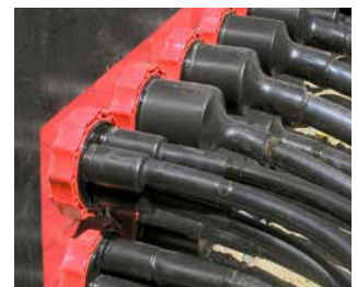
stationsuitvoering: laagspanningskabel afgedicht met HSI90 D1x75 WS en HSI90 D3x32 WS
