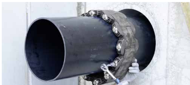
GKD400 – serrage des segments
