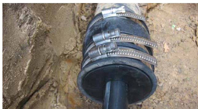
kit d'étanchéité KES90 MA WE100 SG 1x18-65 SET pour étanchement de câbles à l'extrémité de la gaine de câble
