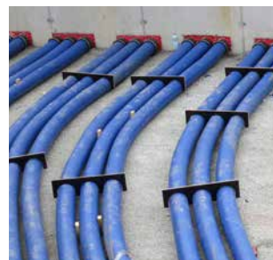
KES MA90 D et flexible spiralé Hateflex14090
