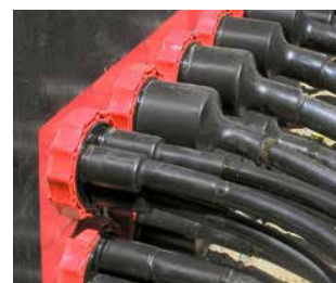
entrée de poste de transformation: câbles basse tension étanchéifiés HSI90 D1x75 WS and HSI90 D3x32 WS
