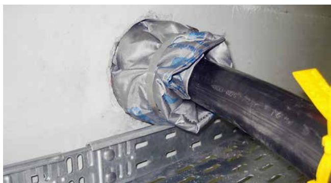
HSS – montage dans carottage avec joints annulaires en caoutchouc HRD
