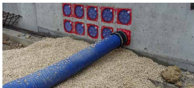
raccordement du système d'entrée de câbles KES MA 150 D
