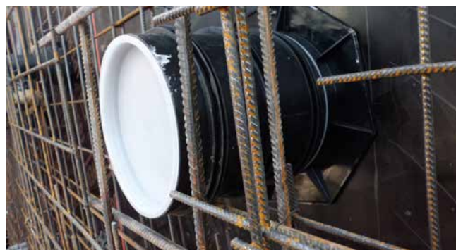
UFR dans le coffrage
