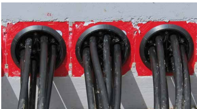
étanchéification de câbles basse tension avec HSI150 DG 6x10-36
