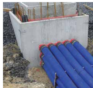
KES MA90 D – raccord au passage étanche HSI90
