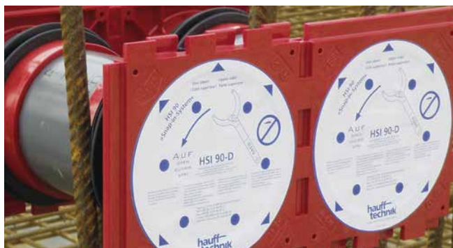
passage double face HSI90 utilisé en faisceau dans un coffrage
