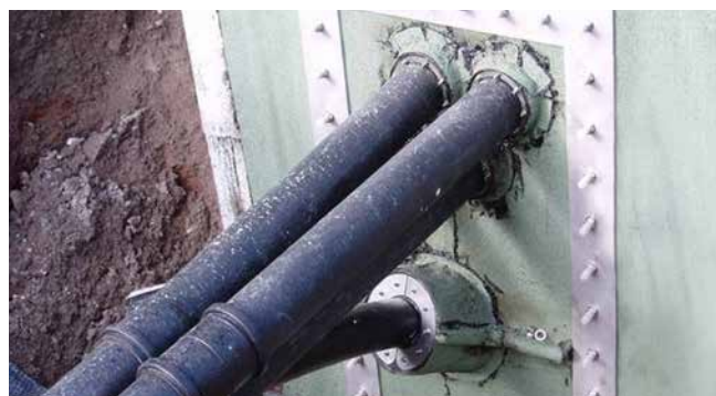
bride fixe/amovible divisée conforme à DIN 18533
