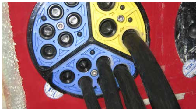
HSI150 SEGMENTO avec contrôle intégré du couple et obturateurs
