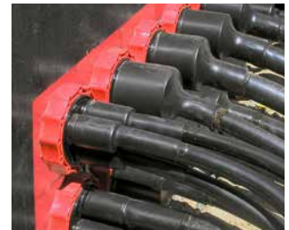
entrée de poste de transformation: câbles basse tension étanchéifiés HSI90 D1x75 WS and HSI90 D3x32 WS
