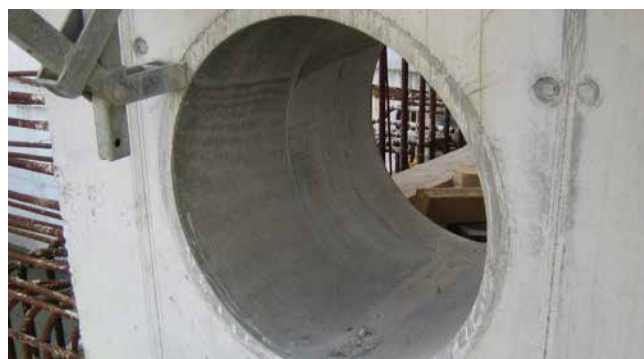
FZR400/300 – lieu de montage station d'épuration
