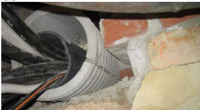
FZRG150/350 – assainissement dans la maçonnerie
