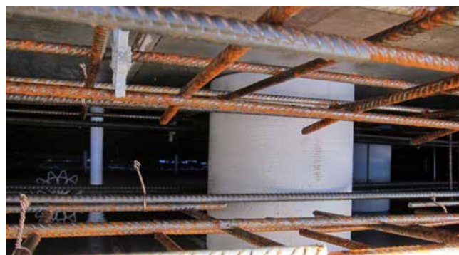
ZVR200/300 fixé dans le coffrage
