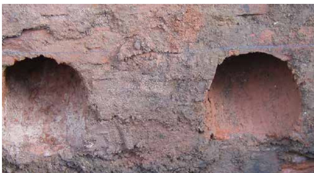
carottage incliné dans un mur poreux
