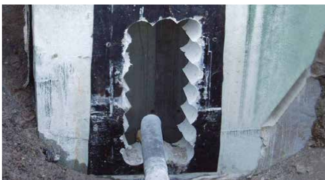
câbles haute tension et les gaines de protection devant être étanchéifiés à posteriori dans la paroi du puits
