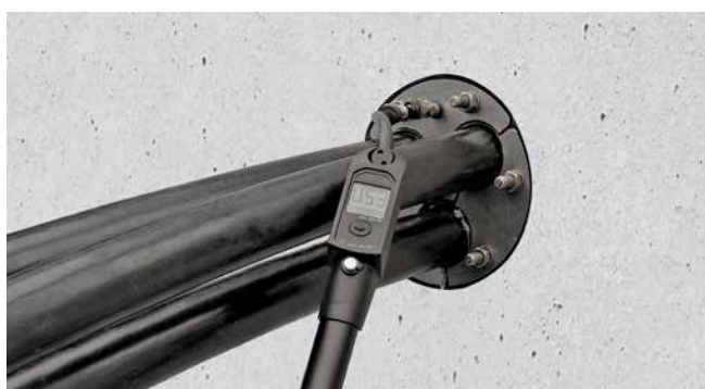
HRD150 PV G dans carottage
