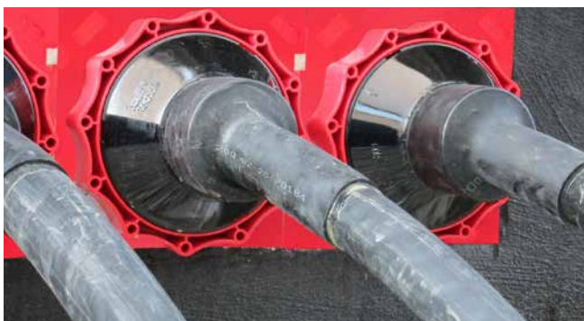
entrée de poste de transformation: câbles basse tension étanchéifiés avec HSI150 D1x80 WS
