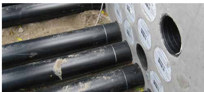
HSI150 GSM Varia utilisé en faisceau
