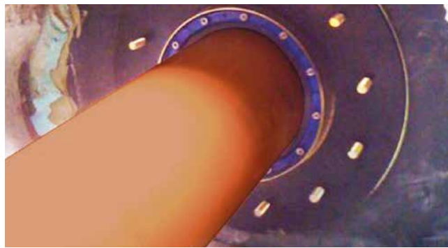
HSD200 C 1x159 b40 A2/EPDM5 5 dans bride zinguée amovible ou fixe
