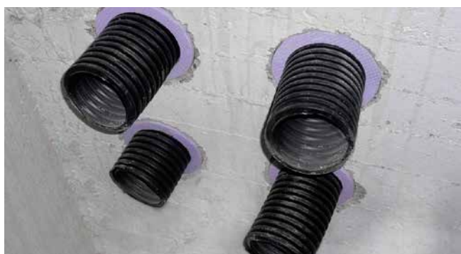
vue côté intérieur du bâtiment (joint Iso)
