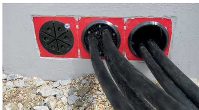
différentes étapes de montage pour HSI150 DG 3x24-54
