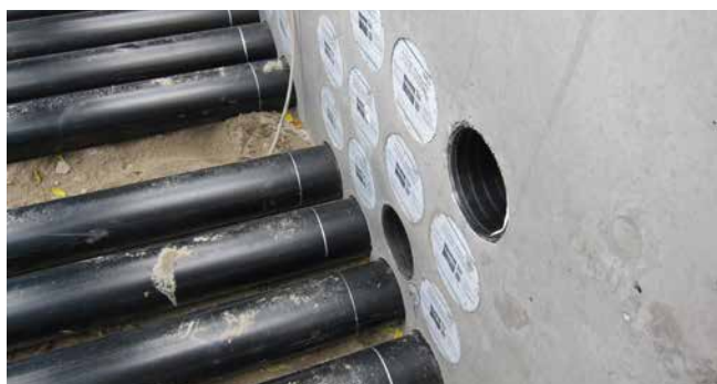
HSI150 GSM Varia utilisé en faisceau
