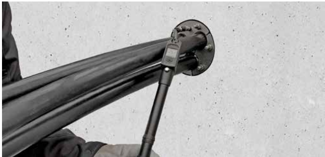
HRD150 PV G dans carottage
