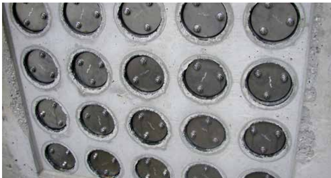
FZR100/240 - étanchement, tracé des tuyaux
