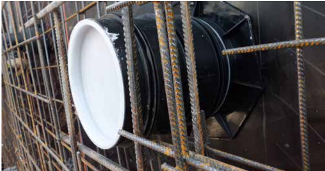
UFR dans le coffrage
