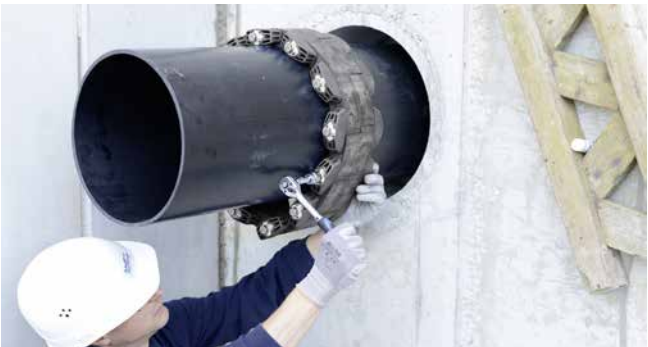
GKD400 -serrage des segments
