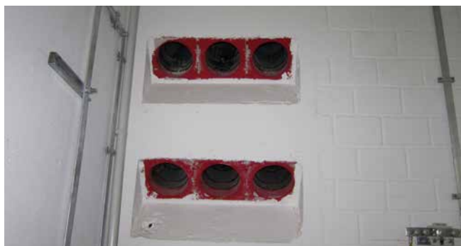
HSI150 1xZ K2 S45°/X garniture d'étanchéité biseautée double face
