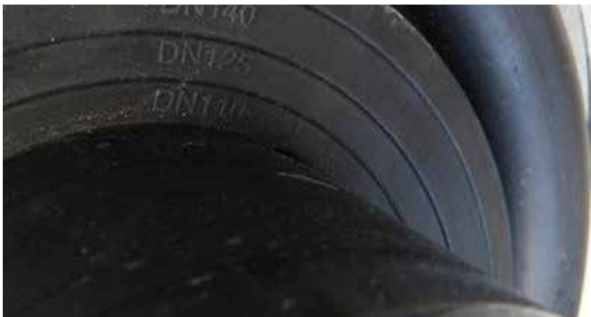
manchette d'étanchéité compensatrice devant le mur ADM - découpes segmentées
