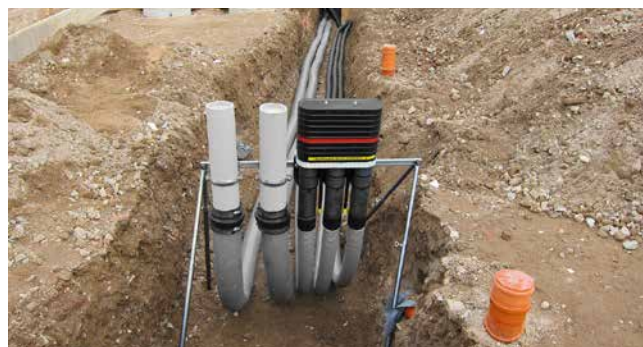
disposition en rangées de 2x KES90 MA ZVR100/500 sur le dispositif d'installation KES FUBO-FIX AV
