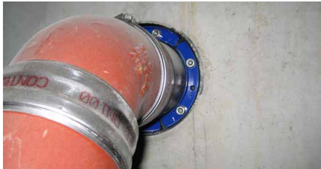
HSD200 C 1x159 b40 A2/EPDM5 5 dans bride zinguée amovible ou fixe
