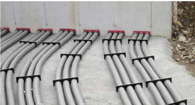
KES MA90 D et flexible spiralé Hateflex14090
