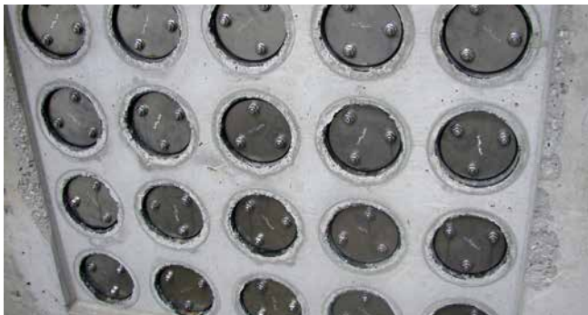
FZR100/240 - étanchement, tracé des tuyaux
