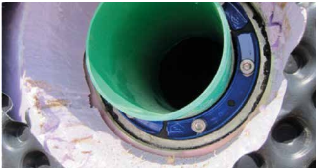
HSD150 C 1x110 b40 A2/EPDM55 dans bride zinguée amovible ou fixe
