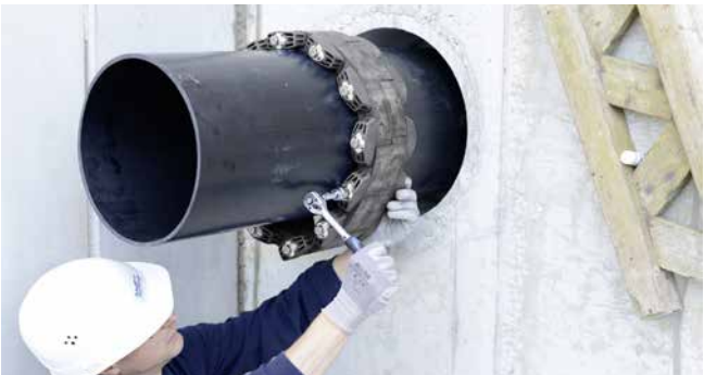
GKD400 -serrage des segments
