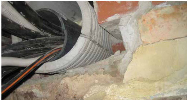
FZRG150/350 - assainissement dans la maçonnerie
