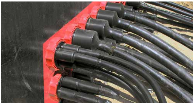
entrée de poste de transformation: câbles basse tension étanchéifiés HSI90 D1x75 WS and HSI90 D3x32 WS
