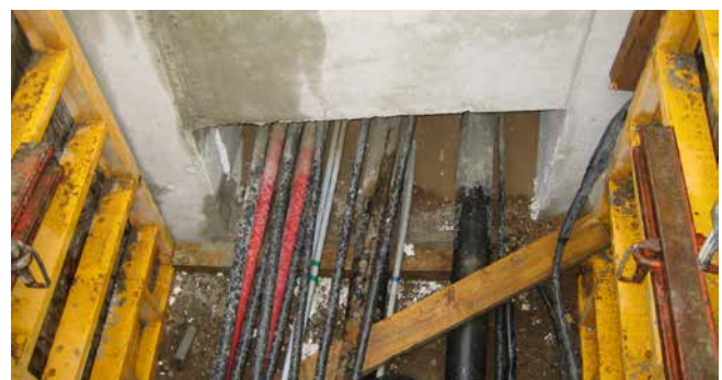
évidement rectangulaire existant sur le site devant être étanchéifié à postérieur
