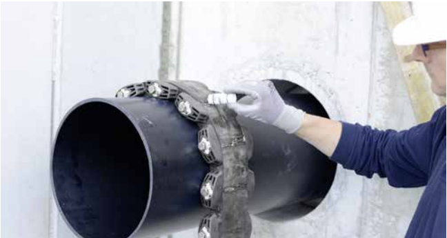
GKD400 - préparation de l'installation avec lubrifiant GM
