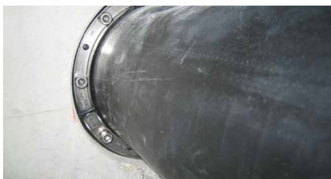
Vue détaillée - HSD, ouverture d'inspection et ordre de serrage des vis
