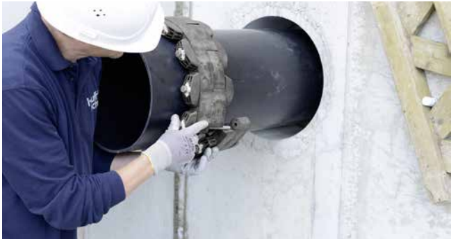
GKD400 - installation des segments
