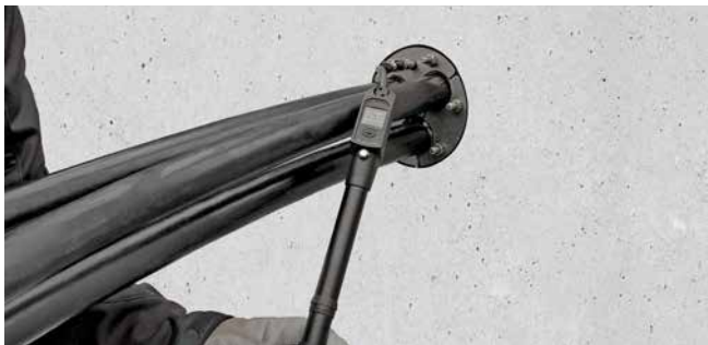
HRD150 PV G dans carottage
