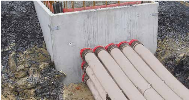
KES MA90 D - raccord au passage étanche HSI90
