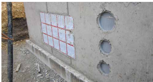
ZVR150 et ZVR200 bétonné près de HSI150
