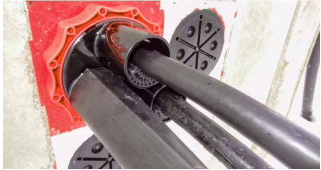
ruban de centrage dans la tubulure du couvercle du HSI150 D3x58 W5
