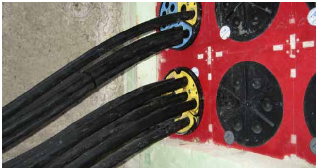
étanchéification des câbles pour l'éclairage public avec SEGMENTO
