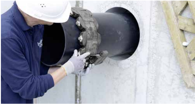
GKD400 - installation des segments
