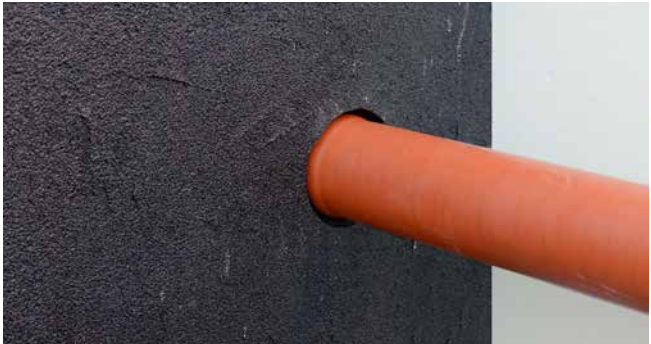
Image pratique de l'UDM/UDME installé avec revêtement PMBC et raccordé à un tuyau KG
