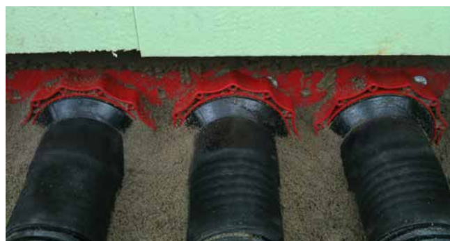
raccord de tube annelé avec technique de rétraction à froid HSI150 D1x110 KS WR
