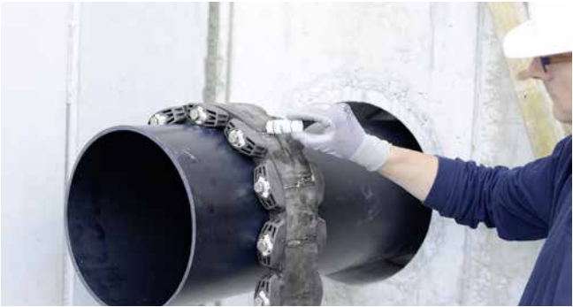
GKD400 - préparation de l'installation avec lubrifiant GM
