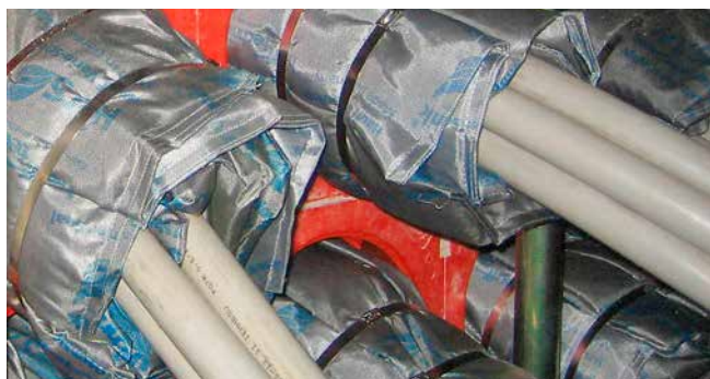
HSS - montage des coussins coupe-feu dans le passage étanche HSI150 K2, étanchéification avec couvercle ou SEGMENTO
