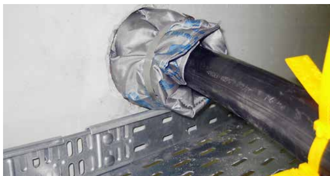
HSS - montage dans carottage avec joints annulaires en caoutchouc HRD
