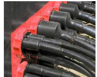
entrée de poste de transformation: câbles basse tension étanchéifiés HSI90 D1x75 WS and HSI90 D3x32 WS
