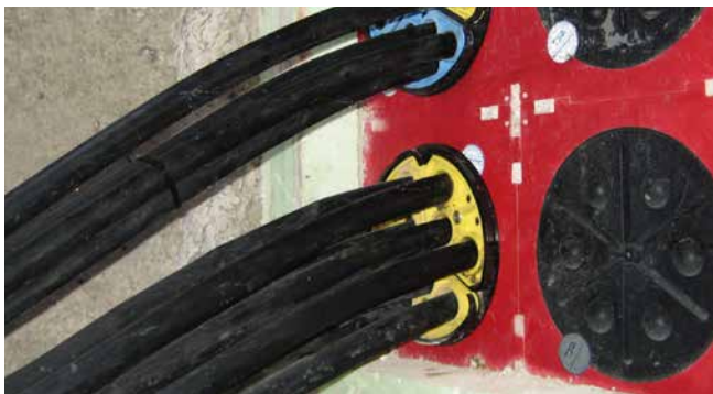
étanchéification des câbles pour l'éclairage public avec SEGMENTO
