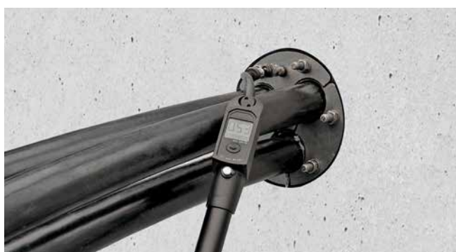
HRD150 PV G dans carottage
