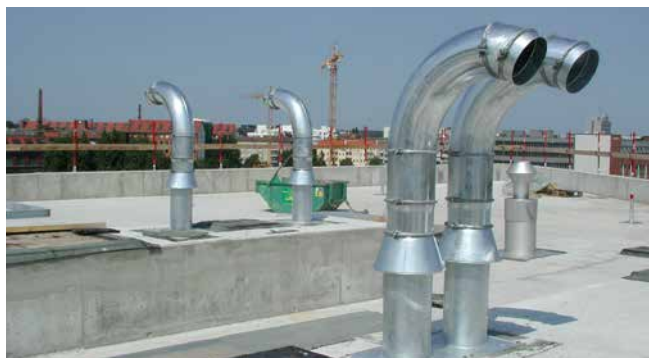
SHD200 installé avant de poser l'étanchéité du toit
