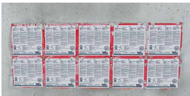
passage double face HSI150 utilisé en faisceau dans un coffrage
