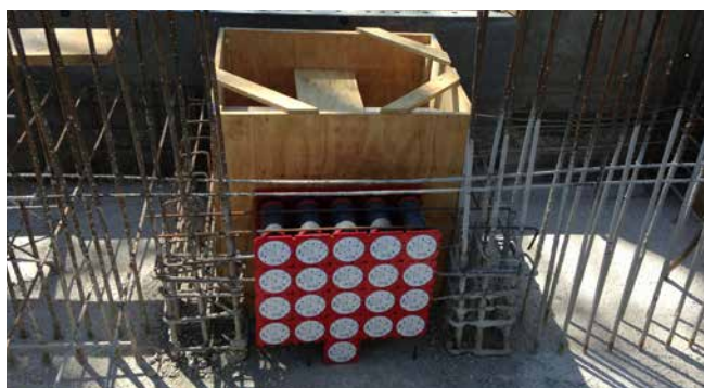
montage du passage double face HSI90 avant le bétonnage
