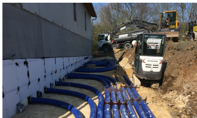
Die einbetonierten HSI150-Dichtpackungen sind gas- und wasserdicht. Sie befinden sich in der Betonwand, hinter der Gebäude-Dämmung. Mit dem Systemdeckel KES-M 150-D wird der Schlauch an die Dichtpackung angeschlossen.
