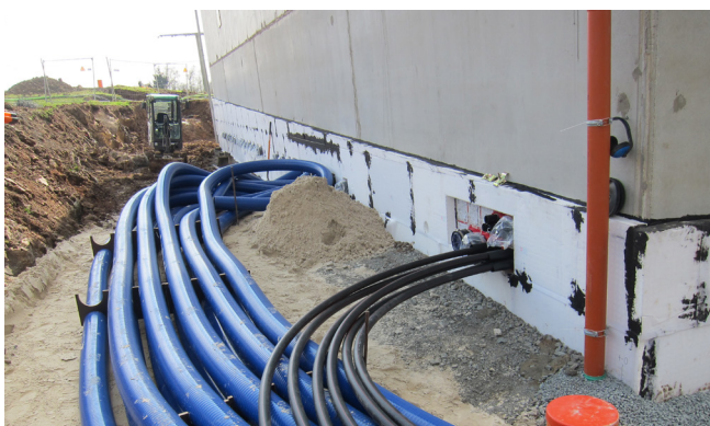
Das biegesteife Kabelschutzrohrsystem Hateflex14150 ist mechanisch druckbelastbar und hält einen entsprechenden Biegeradius vor.
