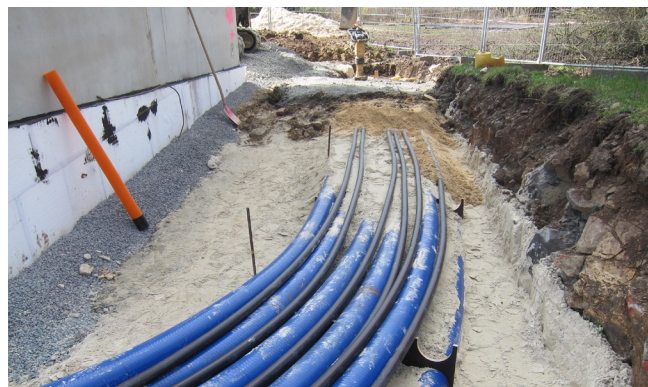
Die Kabeleinführungssysteme KES150 gewährleisten eine sichere Kabelverlegung im überbauten Bereich und halten höchsten Anforderungen stand.
