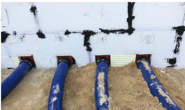
Grazie a una tecnica con manicotto in gomma, il tubo flessibile spiralato Hateflex 14150 viene collegato a tenuta di gas e di acqua alle guide passacavo nel calcestruzzo HSI150.
