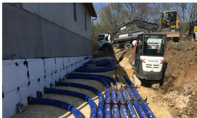
I passaggi impermeabili sigillati nel calcestruzzo HSI150 sono a tenuta di gas e acqua. Si trovano nella parete di calcestruzzo, dietro l'isolamento dell'edificio. Con la copertura di sistema KES-M 150-D, il tubo flessibile viene collegato al passaggio impermeabile.
