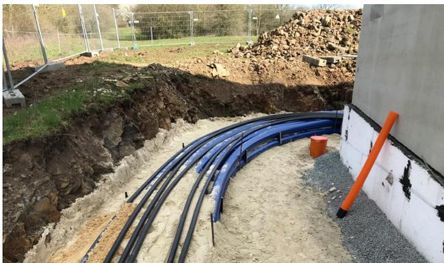
Fissaggio esatto dei tubi flessibili spiralati Hateflex con distanziali KES150-2x3 KA per una messa a tenuta ottimale del pavimento e la successiva posa dei cavi.
