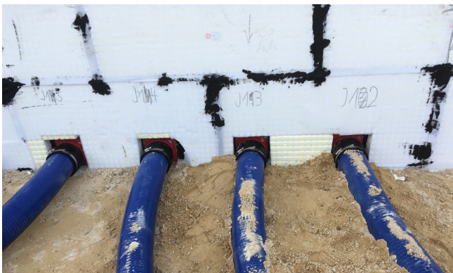
Le tuyau spirale Hateflex14150 est raccordé de manière étanche aux gaz et à l'eau aux passe-câbles HSI150 enrobés de béton, moyennant une technique de manchons.
