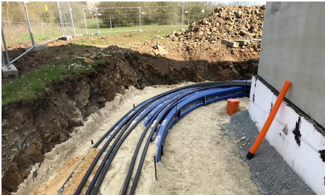
Fixation précise des tuyaux spirales Hateflex avec les supports d'espacement KES150-2x3 KA pour un compactage optimal du sol et une pose ultérieure des câbles.
