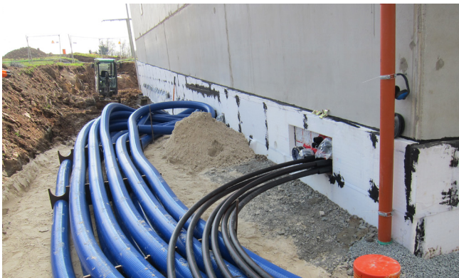
Le système de tuyaux de protection de câble Hateflex14150 est résistant à la flexion et peut être soumis à une pression mécanique et maintient un rayon de flexion correspondant.
