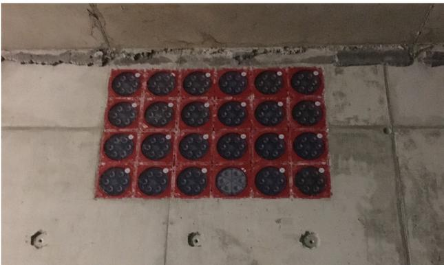
Unbelegte Kabeldurchführungen sind bereits dauerhaft 2bar druckdicht blind verschlossen. Durch den transparenten Verschlussdeckel HSI150 DT ist jederzeit erkennbar, ob Wasser in der Kabeldurchführung beziehungsweise im Schutzrohr ansteht.
