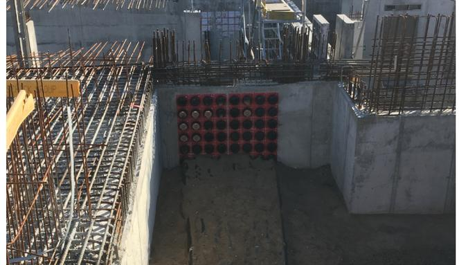
Glatte Kabelschutzrohre mit einem Da 160 mm wurden mit Systemdeckeln HSI150 M168 an die Kabeldurchführungen lagenweise angebunden. Die Momentaufnahme zeigt die erste Lage Kabelschutzrohre.
