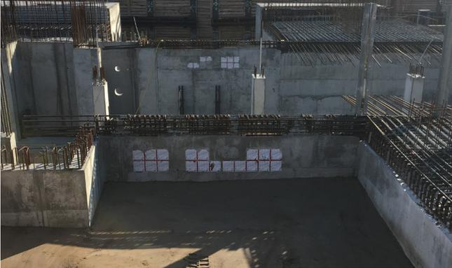
Zum Anschluss von Kabelschutzrohren und zur späteren Kabelabdichtung kamen die Kabeldurchführungen HSI150 K2 von Hauff-Technik zum Einsatz.
