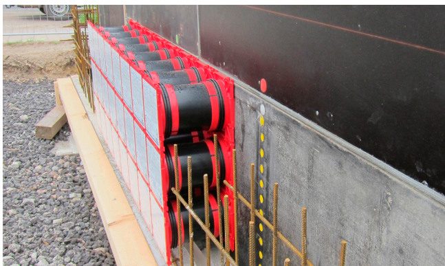
An verschiedenen Seiten des Betriebsgebäudes wurden Kabeldurchführungen in unterschiedlichen Paketen verbaut.. Durch die Paketanordnung wird eine hohe Belegungsichte zum Anschluss von z.B. Kabelschutzrohren erreicht.
