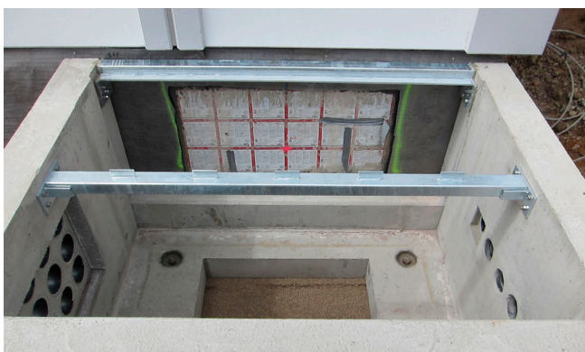
Vor das Gebäude werden im Bereich der Kabeldurchführungen teilweise noch Kabelzug- bzw. Kontrollschächte gesetzt. Diese vereinfachen eine spätere Nachbelegung der Kabeldurchführung mit zusätzlichen Kabeln.
