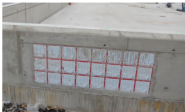
Der komplette Kabelkeller wurde in WU-Betonqualität betoniert.
