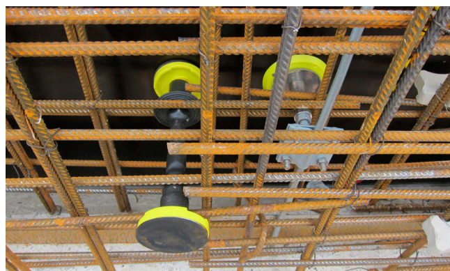
Für die Erdung bzw. den Potentialausgleich kommen mehrere Erdungsdurchführungen sowie Erdungsfestpunkte zum Einsatz. Diese werden in die Bewehrung eingebunden und fixiert. Die Erdungsfestpunkte werden vor der Betonage bereits an die Potentialausgleichsleiter angeschlossen.
