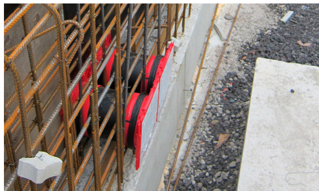
Die Kabeldurchführungen wurden in die Bewehrung mit eingearbeitet und über die vorgesehenen Nagellöcher an der Schalung fixiert.
