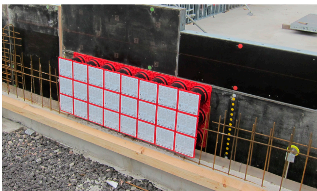
Alle Durchführung sind standardmäßig mit dem druckdichten Verschlussdeckel HSI 150-DT blind verschlossen und verhindern einen möglichen Wassereintritt. Der Verschlussdeckel befindet sich unterhalb der Schutzfolie.
