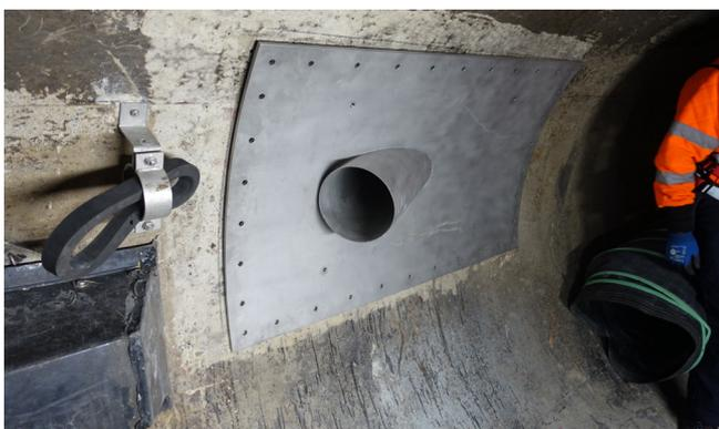
Es wurde eine eingemessene, montierte Edelstahlflanschplatte FA 1x250 A4 zur Aufnahme der Ringraumdichtung HRD250 b90 F-A4 direkt im Abwasserkanal montiert.
