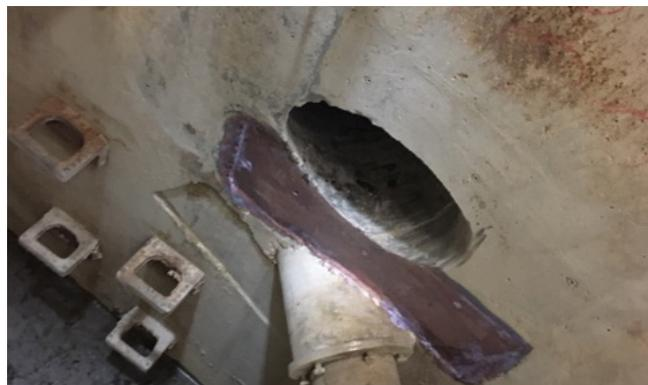
Vor dem Einsetzen des Flansches sieht man Austrittstellen der Kabel-Leitungsführungen zum Maschinenraum und zum Steigschacht.
