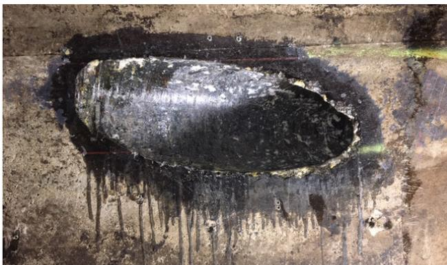
Zustand des Dükers im Abwasserkanal vor der Montage der Edelstahlflanschplatte: schräge Kernbohrungen  $\varnothing$  250 mm mit Gefälle zur Führung der neuen Energie- und Datenkabel direkt an der Betonröhrenwandung (1,80 m Abwasserkanaldurchmesser).
