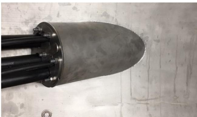
Anschließend wurde als Dichteinsatz die Ringraumdichtung HRD250 b90 F-A4 direkt im Abwasserkanal angebracht.
