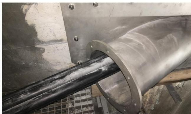
Montierte Edelstahlflanschplatte FA 200-S45 mit Kabelbelegung zur Aufnahme einer passenden geteilten Ringraumdichtung HRD200 b90 F-A4 vom Düker zum Steigschacht.
