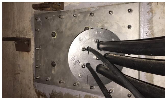
Zustand mit montiertem Dichteinsatz Ringraumdichtung HRD200 b90 F-A4 im Steigschacht mit Lagefixierung des Dichteinsatz über einen geschraubten Flanschanschluss.
