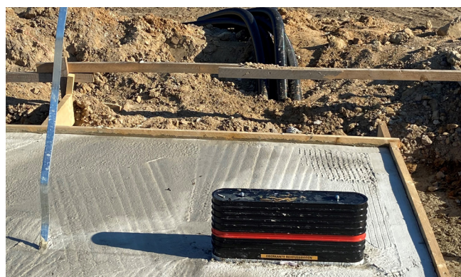
De meervoudige huisinvoer kan variabel op de hoogte van de opgeleverde vloer worden aangepast. De vijf flexibele mantelbuizen worden tot de perceelgrens geïnstalleerd. Daardoor is het mogelijk om toekomstige aansluitingen achteraf zonder problemen aan te brengen.
