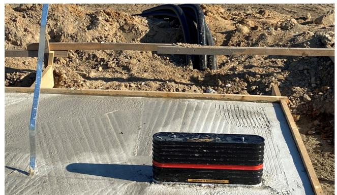
Die Mehrspartenhaufeinführung kann variabel an das Fertigfußbodenniveau angepasst werden. Die fünf flexiblen Schutzrohrsysteme werden bis zur Grundstücksgrenze verlegt. Dadurch ist eine problemlose Nachbelegung auch in der Zukunft möglich.
