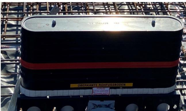
Das Rohbauteil der Mehrspartenhaufeinführung MSH Basic FUBO R5 wird am Schnurgerüst ausgerichtet und zum Betonieren der Bodenplatte vorbereitet. Im Bauvorhaben Quartierkonzept Neustadt wird die fünffache Bodeneinführung mit folgenden Sparten belegt: Nahwärme Vor- und Rücklauf, Trinkwasser, Elektro und Telekommunikation.
