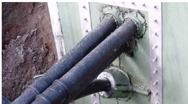
Brida fija/suelta separada siguiendo la norma DIN 18533
