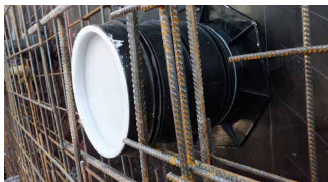
UFR en encofrado
