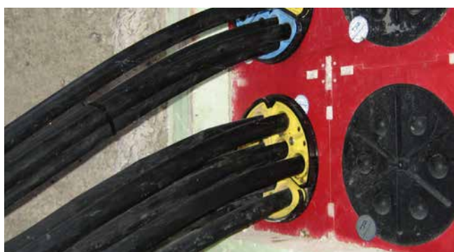
Sellado de cables para alumbrado público con SEGMENTO
