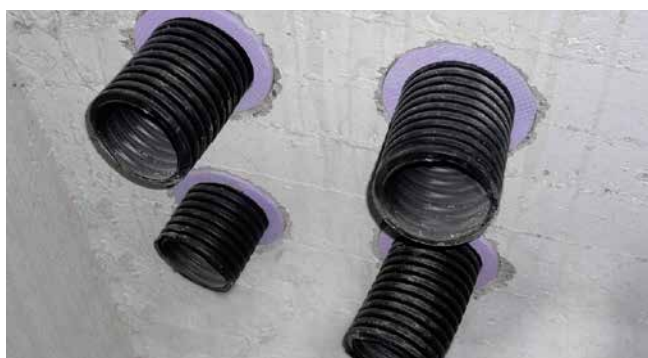
Vista del interior del edificio (anillo aislante)
