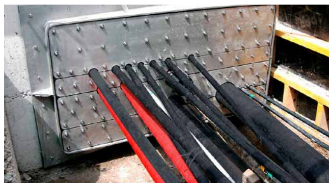
Brida rectangular separada con múltiples entradas
