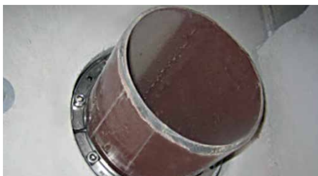
HSD200 1x160 b40 A2/EPDM55 – Tubería de desagüe SML
