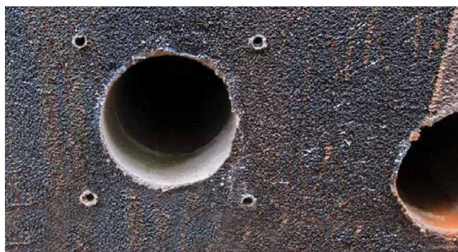
Taladro de núcleo y agujeros para la colocación de tacos
