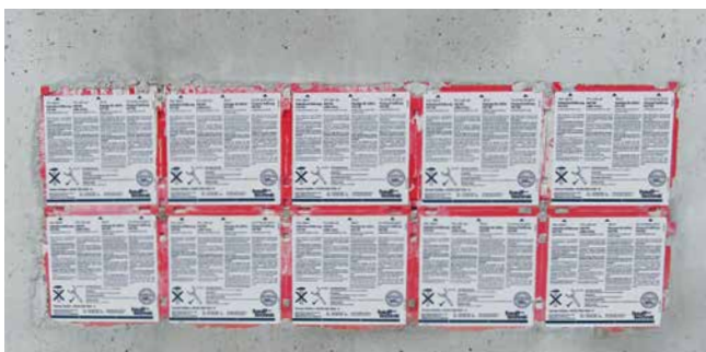
Inserto de pared doble HSI150 como paquete empleado en encofrado
