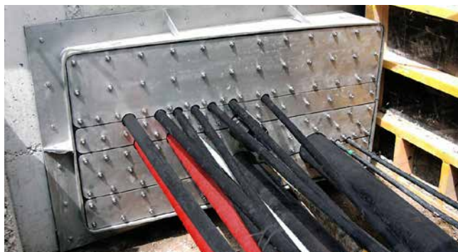
Brida rectangular separada con múltiples entradas
