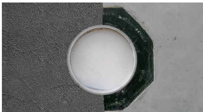
UFR hormigonado con PMBC
