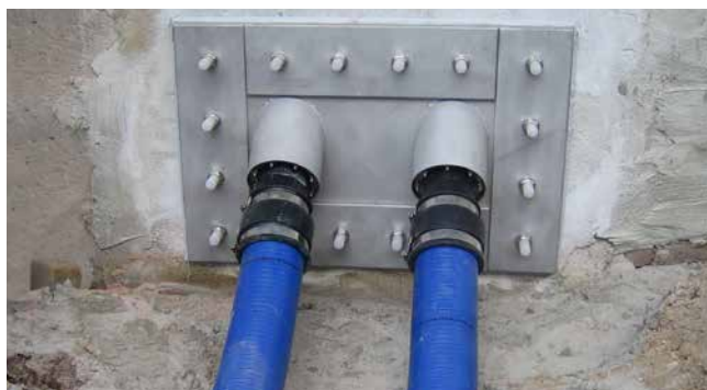
Brida fija/suelta con unión de tubería vacía inclinada antes del sellado superficial
