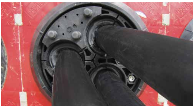
Cubierta de la placa de prensa HSI150 DG PA 3x24-54
