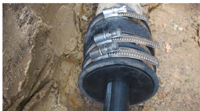
Kit de sellado KES90 MA WE100 SG 1x18-65 SET f para el sellado de cables en el extremo del canal de cables
