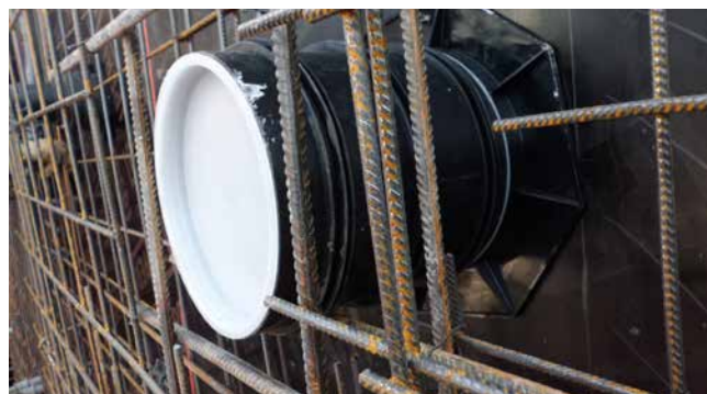
UFR en encofrado
