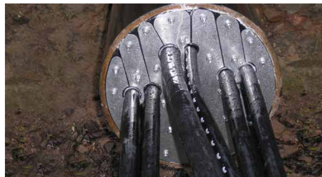
HRD200 G b30 en una tubería de acero
