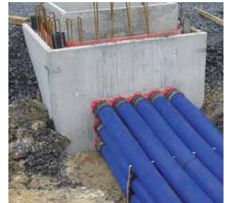
KES MA90 D – Conexión con inserto de pared HSI90
