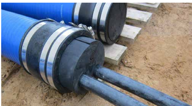
Conexión estanca a la presión de la manguera espiral Hateflex14150 al inserto de pared HSI150 y conexión final para el canal de cables
