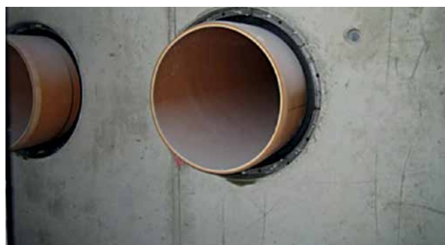
HSD500 G 1x429 b40 A2/EPDM55 – Entrada y salida de aire
