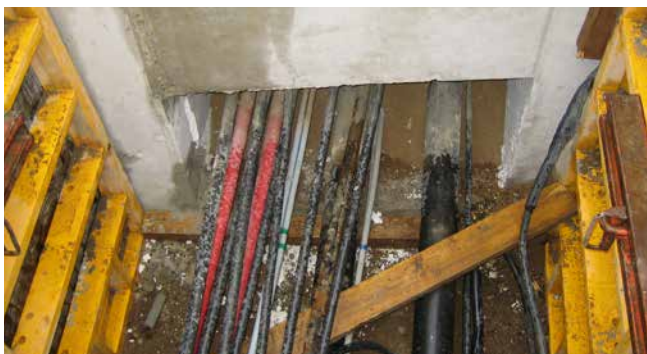
Receso rectangular existente en obra – debe sellarse posteriormente
