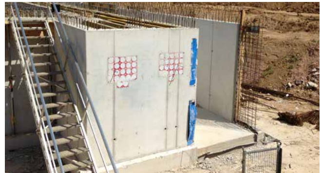
HSI90-K2 tras el hormigonado: A continuación viene la conexión de la tubería vacía
