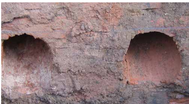
Taladro de núcleo inclinado en mampostería porosa
