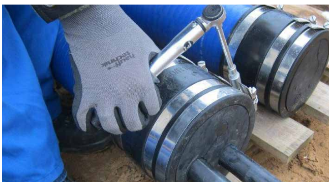
Conexión estanca a la presión de la manguera espiral Hateflex14090 al inserto de pared HSI90 y conexión final para el canal de cables
