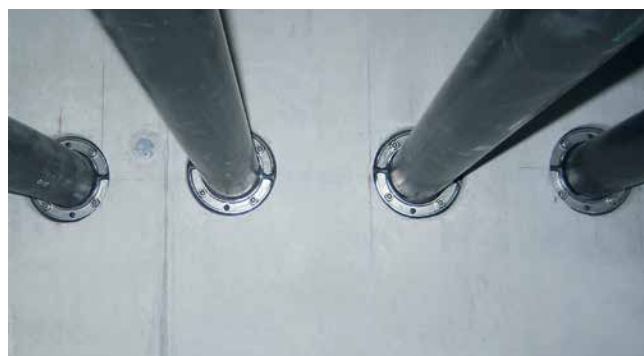
HSD125 1x75 b20 A2/EPDM55 Sellado de tuberías vacías
