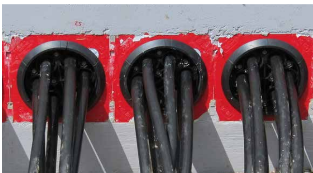
Sellado de cables de baja tensión con HSI150 DG 6x10-36
