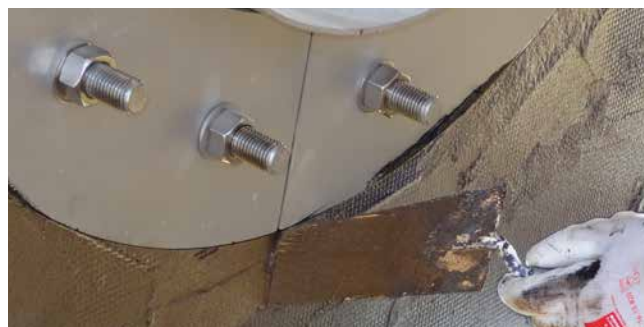
Versión en acero inoxidable FLFE 1x300/X con unión a los recubrimientos gruesos bituminosos modificados con polímeros (PMBC) mediante una incrustación de lana
