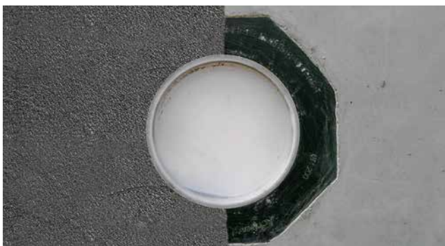
UFR hormigonado con PMBC
