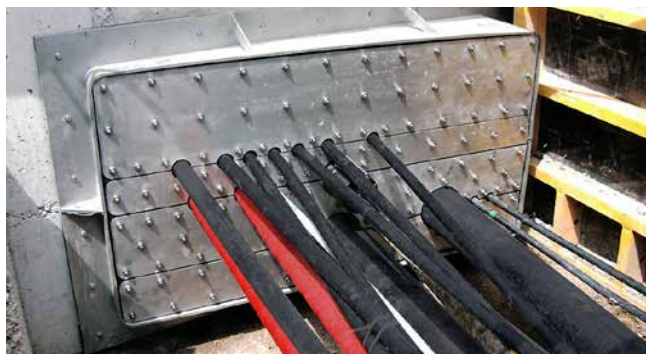
Brida rectangular separada con múltiples entradas
