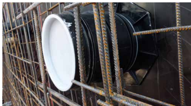
UFR en encofrado
