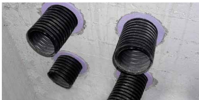
Vista del interior del edificio (anillo aislante)
