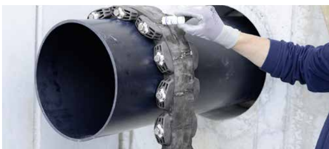
GKD400 – preparación del montaje con lubricante GM
