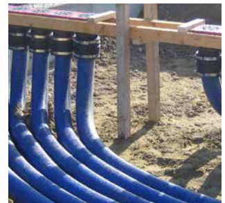
Filas con HSI150 1x6 KVB150 cada una, para entrada al suelo de la manguera espiral Hateflex14150
