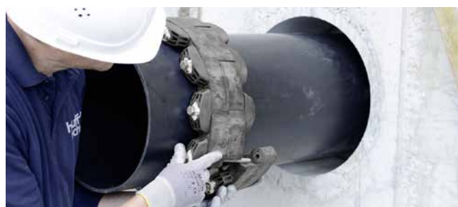
GKD400 – colocación de los segmentos
