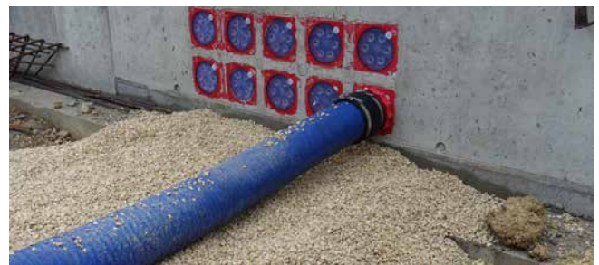
Conexión del sistema de entrada de cables KES MA150 D
