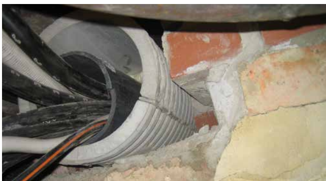
FZRG150/350 – Restauración de la mampostería
