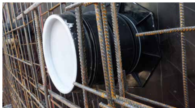
UFR en encofrado
