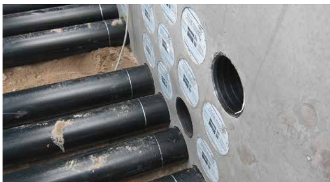
HSI150 GSM instalado
