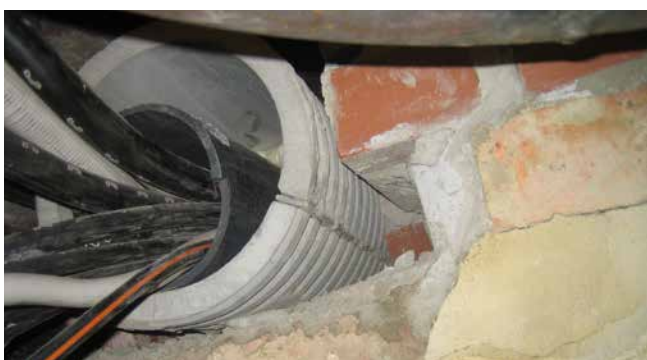
FZRG150/350 – Restauración de la mampostería
