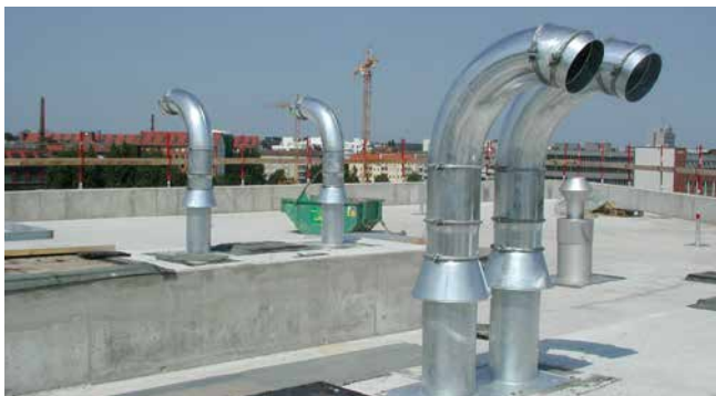
SHD200 montado antes de la aplicación del sellado del tejado
