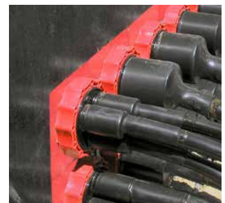
Canalización de estaciones: Cable de baja tensión sellado con HSI90 D1x75 WS and HSI90 D3x32 WS
