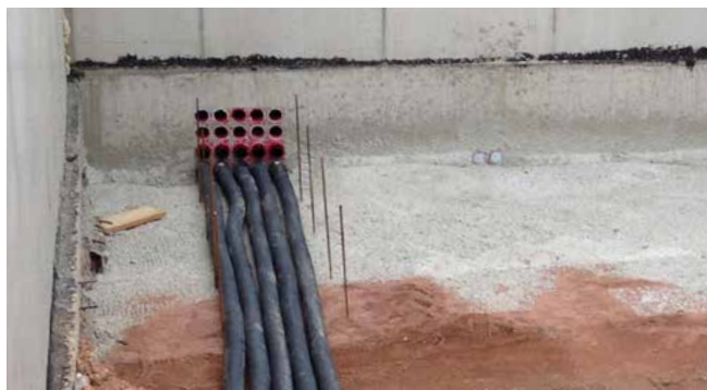
Conexión de tuberías corrugadas HSI90 D1x75 KS WR
