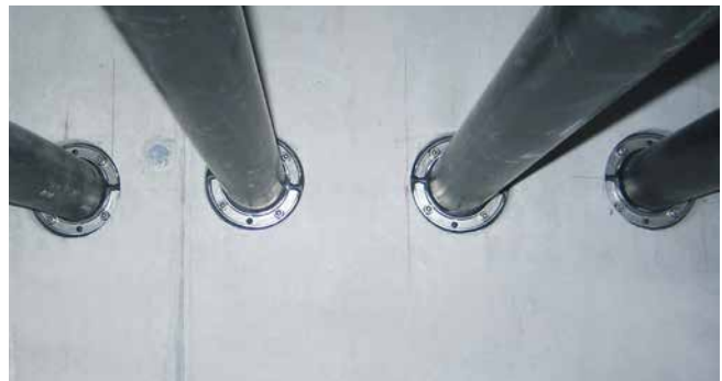
HSD125 1x75 b20 A2/EPDM55 Sellado de tuberías vacías
