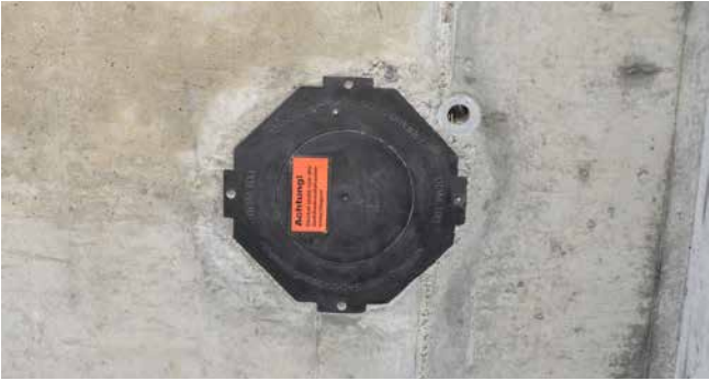
Imagen práctica de UDM/UDME en muro de hormigón
