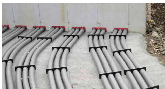
KES MA150 D y manguera espiral Hateflex14150
