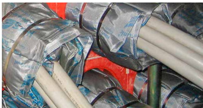
HSS - Instalación de tabletas anti fuego en inserto de pared HSI150 K2, sellado con cubierta del sistema o SEGMENTO
