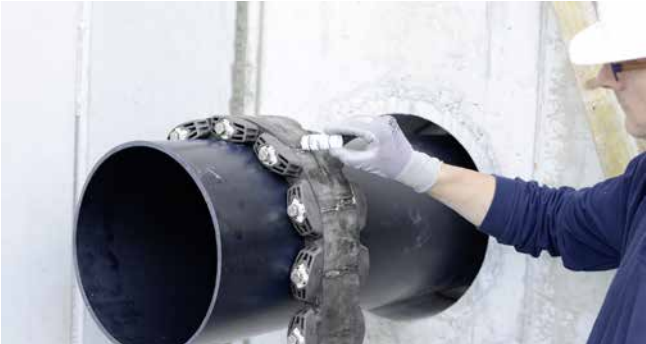
GKD400 - preparación del montaje con lubricante GM
