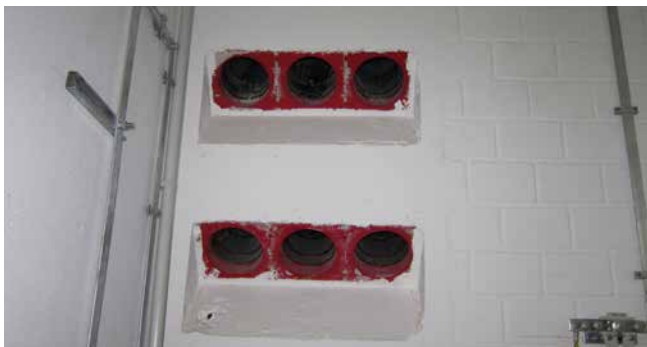
2x HSI150 1xZ K2 S45°/X Empaquetadura inclinada doble
