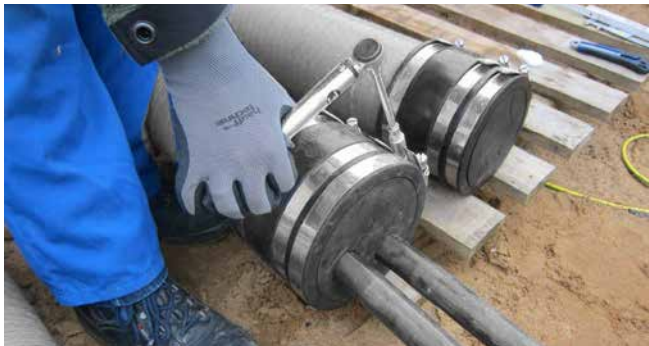
Conexión estanca a la presión de la manguera espiral Hateflex14090 al inserto de pared HSI90 y conexión final para el canal de cables
