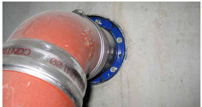
HSD200 C 1x159 b40 A2/EPDM5 5 con brida fija y suelta galvanizada
