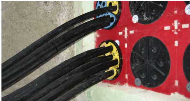
Sellado de cables para alumbrado público con SEGMENTO
