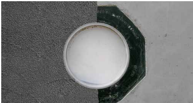
UFR hormigonado con PMBC
