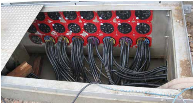
uszczelnienia przewodów o?wietlenia ulicznego za pomoc? systemu SEGMENTO
