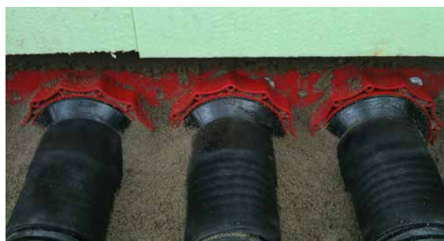
Conexión de tuberías corrugadas con tecnología de retracción en frío HSI150 D1x110 KS WR
