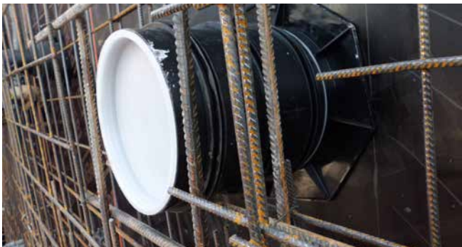
UFR en encofrado
