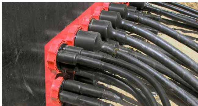
Canalización de estaciones: Cable de baja tensión sellado con HSI90 D1x75 WS and HSI90 D3x32 WS
