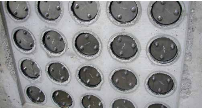
FZR100/240 Sellado de canalizaciones
