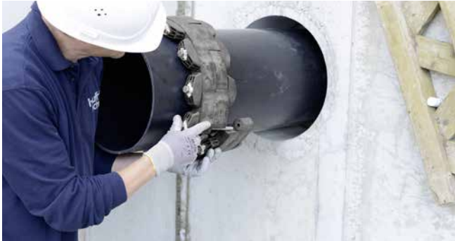
GKD400 - colocación de los segmentos
