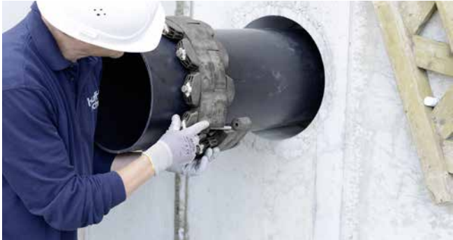
GKD400 - colocación de los segmentos
