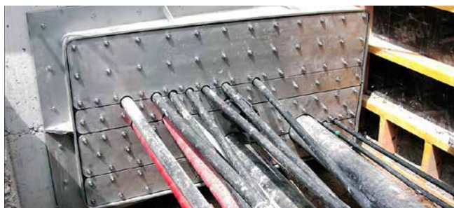
Brida rectangular separada con múltiples entradas
