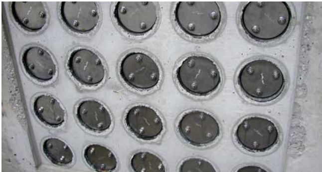
FZR100/240 Sellado de canalizaciones
