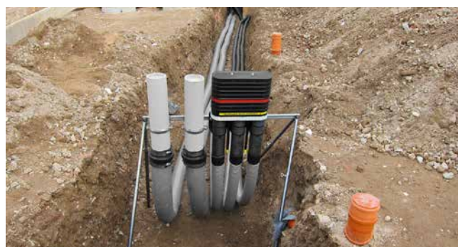
Disposición en línea 2x KES90 MA ZVR100/500 en el dispositivo de ajuste KES FUBO-FIX AV
