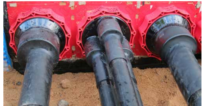
Cinta de centrado en los apoyos de cubierta del sistema del HSI150 D3x58 WS
