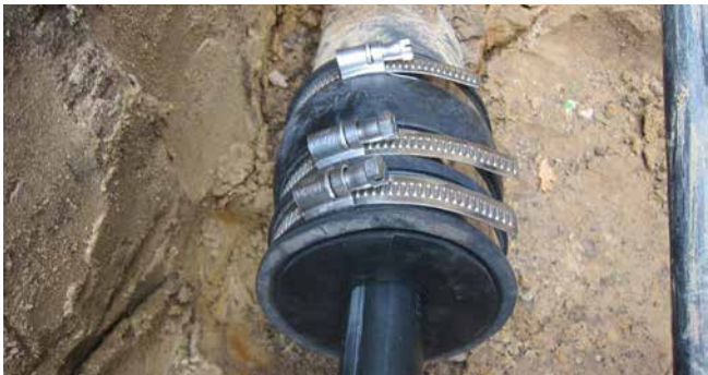
Kit de sellado KES90 MA WE100 SG 1x18-65 SET f para el sellado de cables en el extremo del canal de cables
