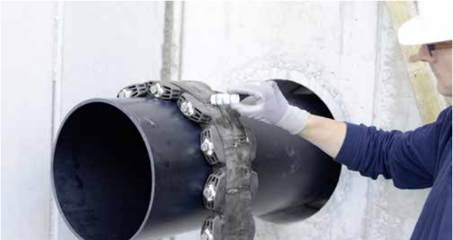
GKD400 - preparación del montaje con lubricante GM
