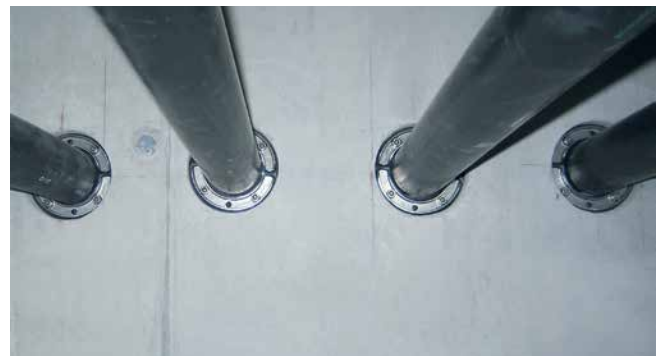
HSD125 1x75 b20 A2/EPDM55 empty conduit connection
