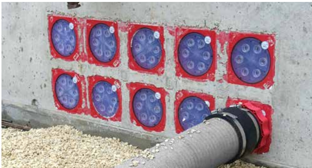
KES MA150 D und Spiralschlauch Hateflex14150
