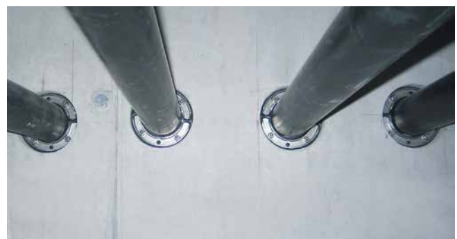
HSD125 1x75 b20 A2/EPDM55 empty conduit connection
