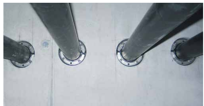
HSD125 1x75 b20 A2/EPDM55 empty conduit connection
