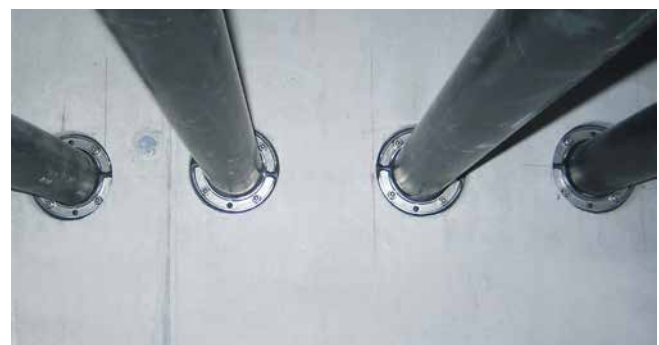
HSD125 1x75 b20 A2/EPDM55 empty conduit connection
