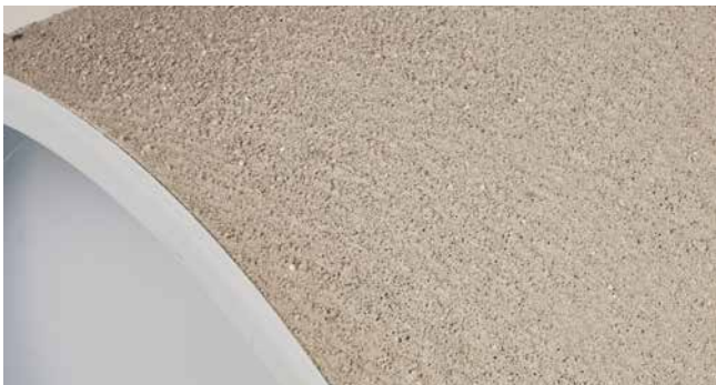
ZVR150 und ZVR200 einbetoniert neben HSI150
