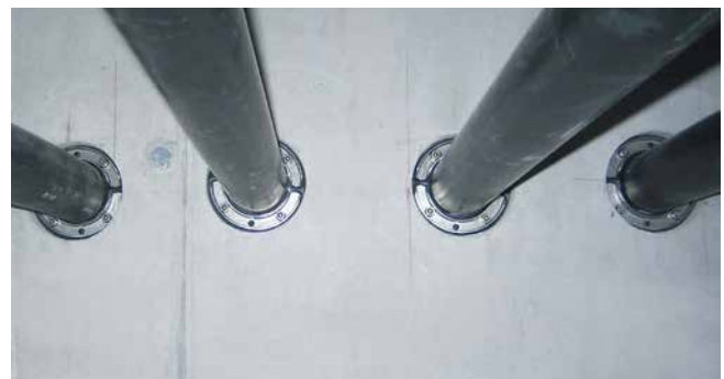
HSD125 1x75 b20 A2/EPDM55 empty conduit connection
