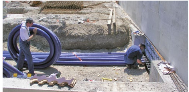
Verlegung Kabeleinführungs-System KES150 MA mit Manschettentechnik
