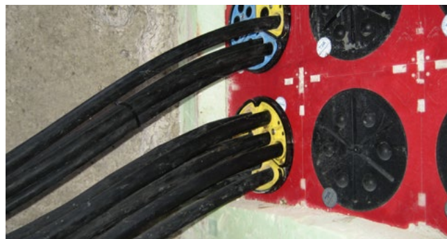
Abdichtung von Kabeln für Straßenbeleuchtung mit SEGMENTO
