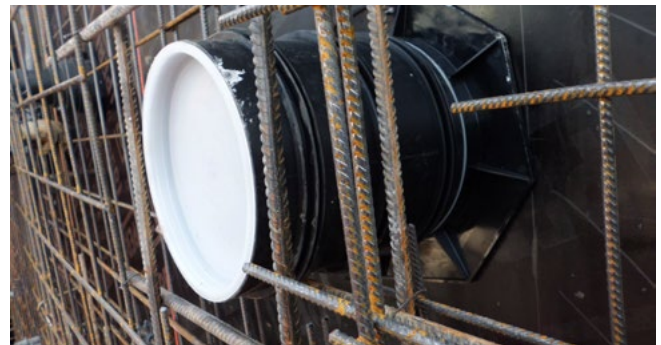
UFR in Schalung
