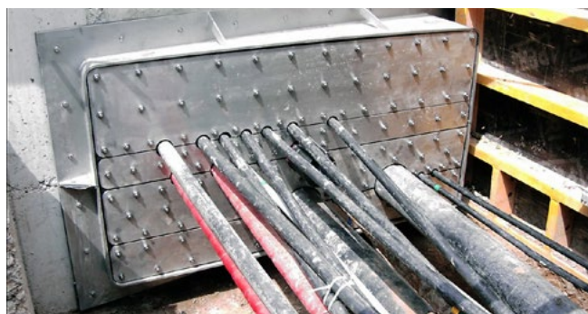
Geteilter Rechteck-Flansch mit Mehrfachbelegung
