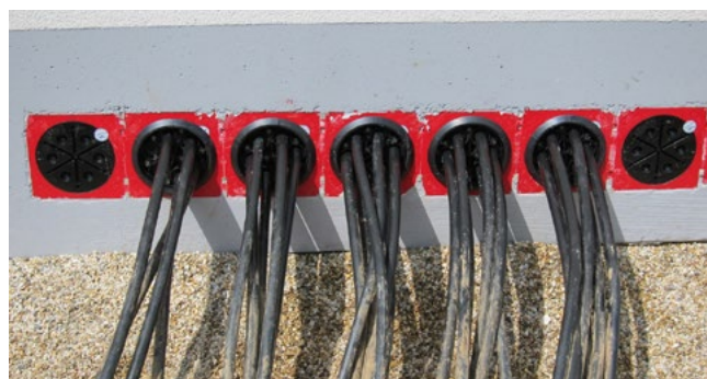
Abdichtung von Niederspannungskabeln mit HSI150 DG 6x10-36
