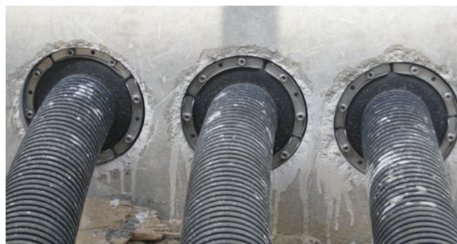
Detailansicht: Clipping/Dichtung
