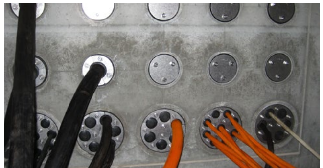
HRD150 SG eingebaut in Faserzementfutterrohre
