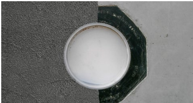
Betoniertes UFR mit PMBC
