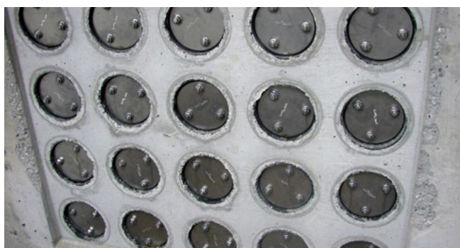
FZR100/240 Abdichtung Rohrtrasse
