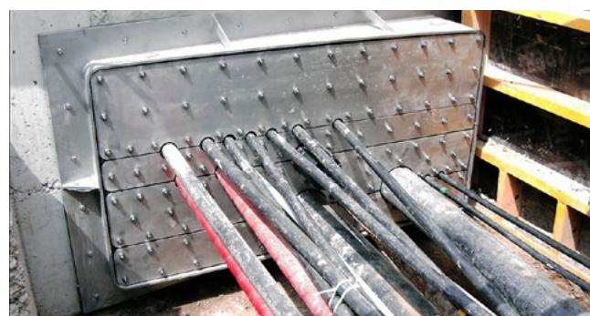
Geteilter Rechteck-Flansch mit Mehrfachbelegung
