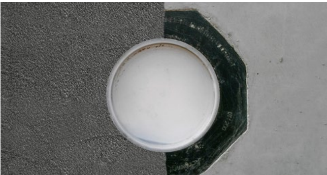
Betoniertes UFR mit PMBC
