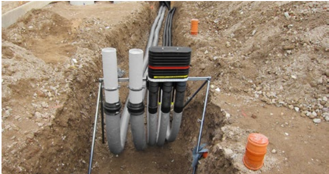
Reihenanzordnung 2x KES90 MA ZVR100/500 an der Aufstellvorrichtung KES FUBO-FIX AV
