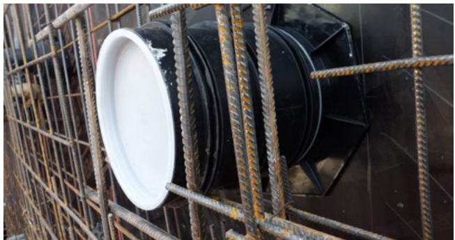
UFR in Schalung
