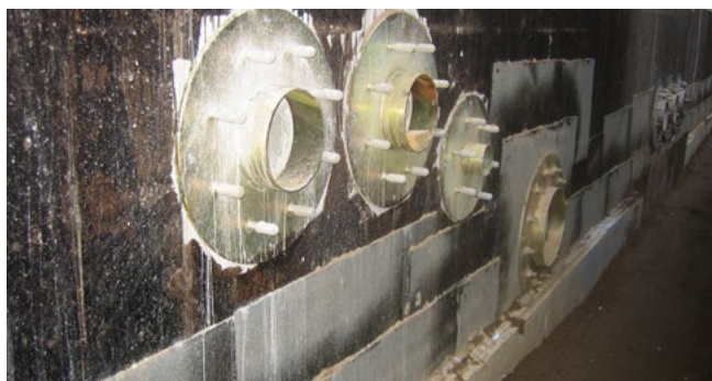
D1: Futterrohr \varnothing i , D2: Festflansch \varnothing a , D3: Losflansch \varnothing a
