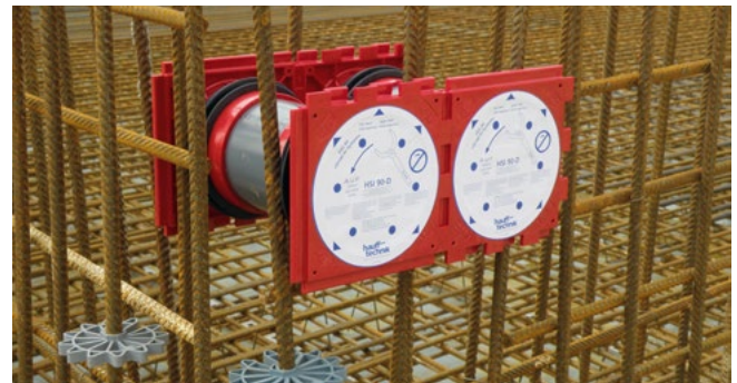
Doppeldichtpackung HSI90 als Paket in Schalung eingesetzt
