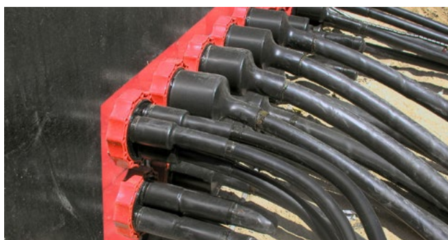
Stationseinführung: Niederspannungskabel abgedichtet mit HSI90 D1x75 WS und HSI90 D3x32 WS
