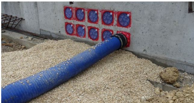
Druckdichter Anschluss an die HSI150-Dichtpackungen
