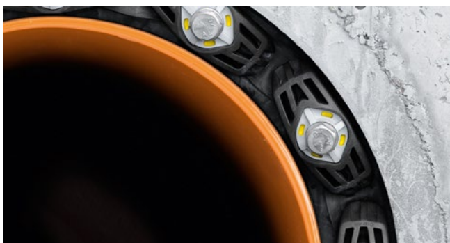
GKD fertig montiert - alle Sichtfenster sind komplett gelb ausgefüllt.
