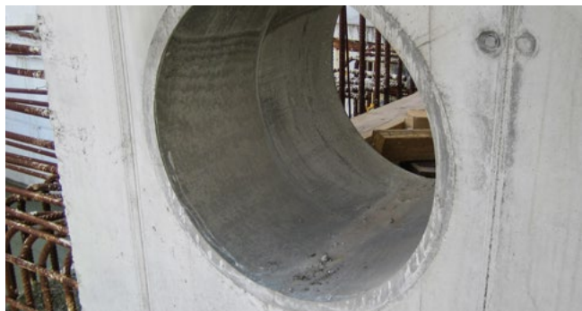
FZR400/300 Einbauort Kläranlage
