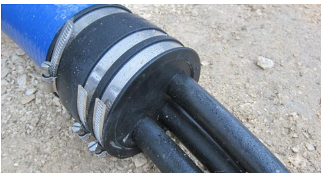
Abdichtung im Erdreich am Ende des Spiralschlauches Hateflex14150 mit dem Abdichtset KES150 MA WE160 SG 3x22-58 SET
