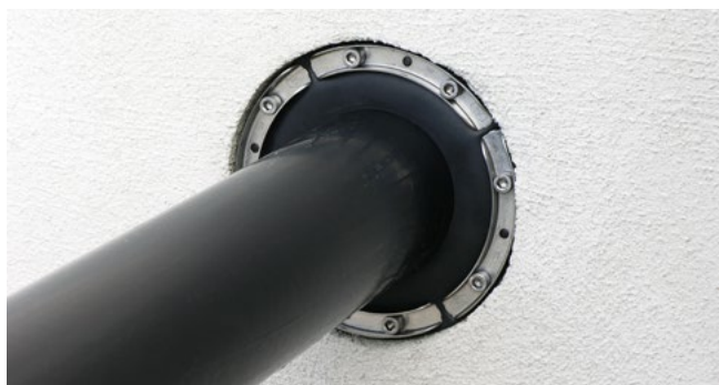
HSD200 1x159 b20 A2/EPDM55 „Schachtabdichtung“
