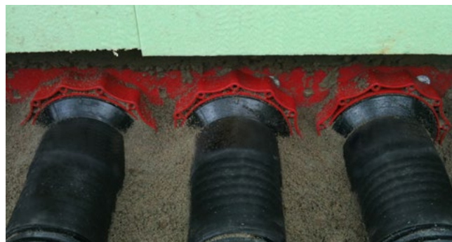
Wellrohranschluss mit Kaltschrumpftechnik HSI150 D1x110 KS WR
