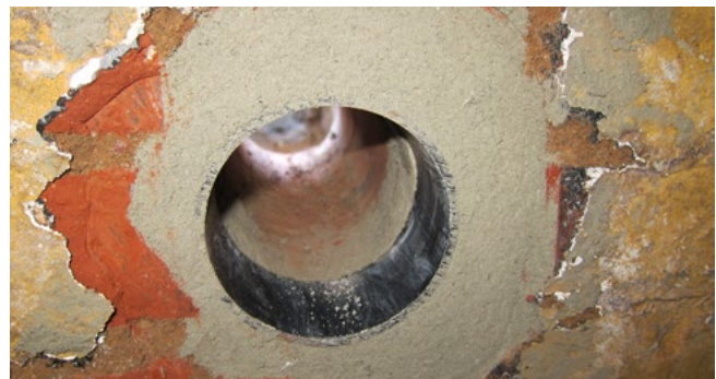
SFR nachträglich im Mauerwerk eingearbeitet
