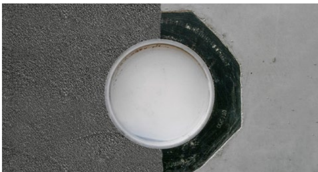
Betoniertes UFR mit PMBC
