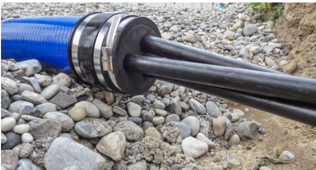
Abdichtung im Erdreich am Ende des Spiralschlauches Hateflex14150 mit dem Abdichtset KES150 MA WE160 SG 3x22-58 SET
