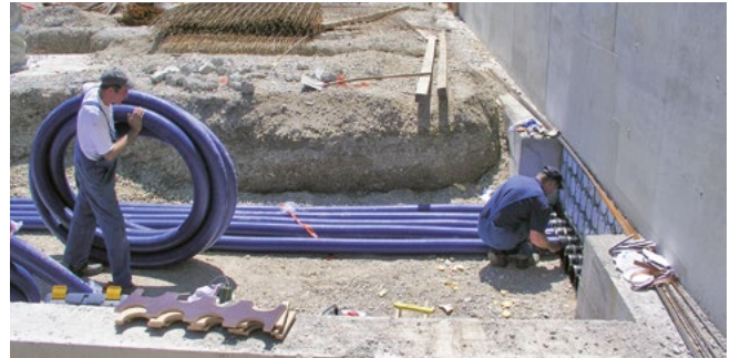
Verlegung Kabeleinführungs-System KES150 MA mit Manschettentechnik
