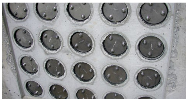
FZR100/240 Abdichtung Rohrtrasse
