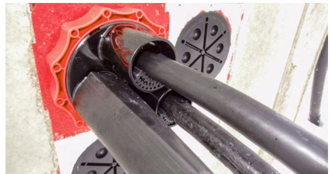
Zentrierband im Systemdeckelstutzen des HSI150 D3x58 WS
