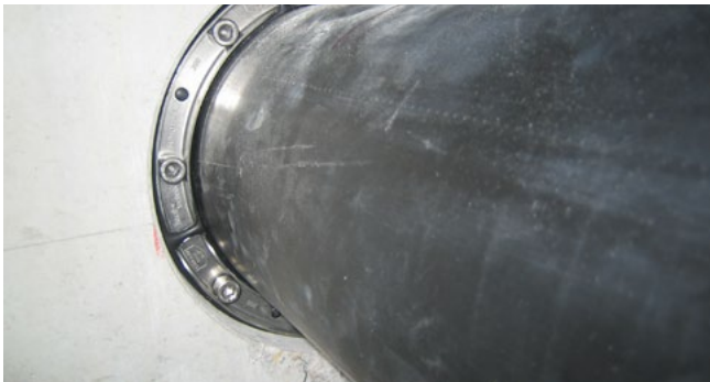
Detailansicht - HSD, Kontrollöffnung und Anzugsreihenfolge der Schrauben
