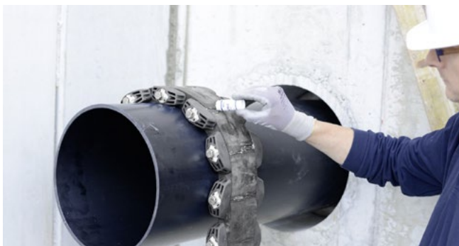
GKD400 - Montagevorbereitung mit Gleitmittel GM
