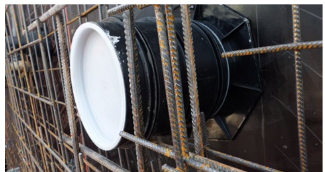
UFR in Schalung
