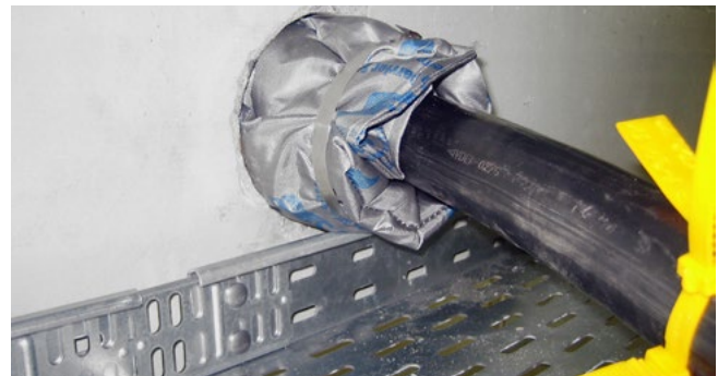
HSS – Einbau in Kernbohrung mit HRD Ringraumdichtungen
