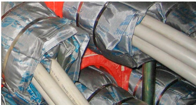
HSS - Einbau der Brandschutzkissen in Dichtpackung HSI150 K2, Abdichtung mit Systemdeckel oder SEGMENTO
