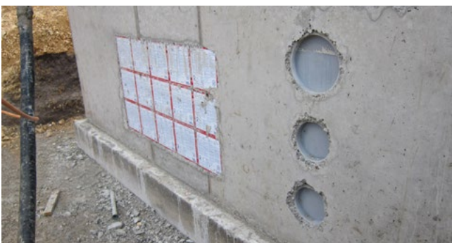
ZVR150 und ZVR200 einbetoniert neben HSI150
