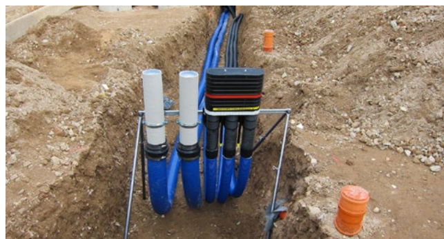
Reihenanzordnung 2x KES90 MA ZVR100/500 an der Aufstellvorrichtung KES FUBO-FIX AV
