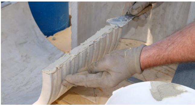
FZRG350/300 mit Spachtelmasse aus Montageset MSET FZRG
