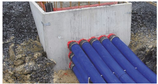
KES MA90 D - Anschluss an Dichtpackung HSI90
