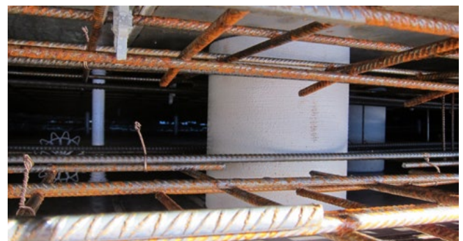
ZVR200/300 in der Schalung fixiert
