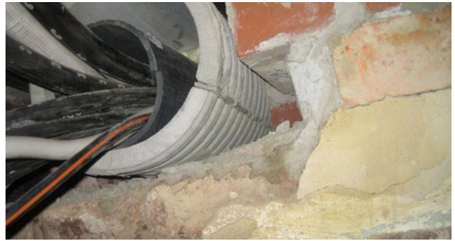
FZRG150/350 - Renovierung Mauerwerk
