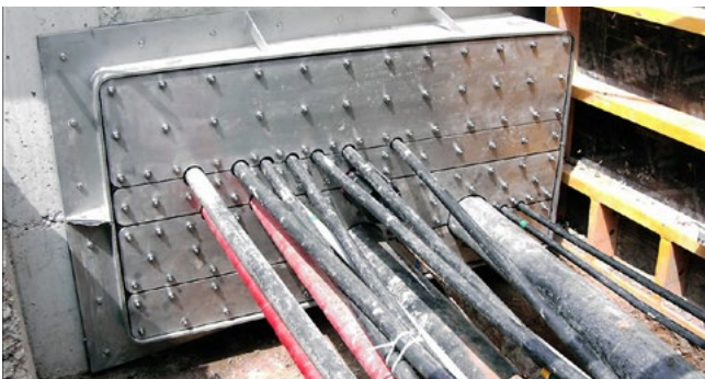
Geteilter Rechteck-Flansch mit Mehrfachbelegung
