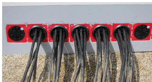
Abdichtung von Niederspannungskabeln mit HSI150 DG 6x10-36
