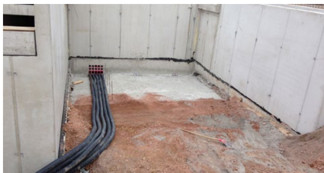
Wellrohranschluss HSI90 D1x75 KS WR
