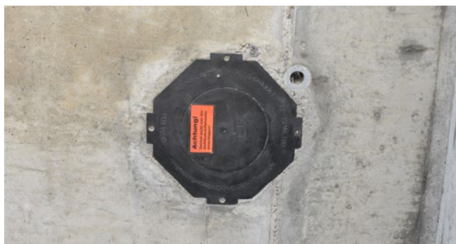
Praxisbild UDM/UDME in betonierter Wand
