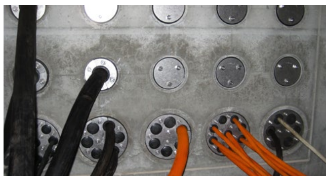
HRD150 SG eingebaut in Faserzementfutterrohre
