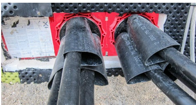
Zentrierband im Systemdeckelstutzen des HSI150 D3x58 WS
