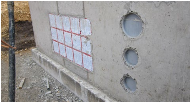
ZVR150 und ZVR200 einbetoniert neben HSI150
