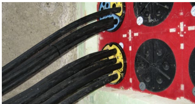
Abdichtung von Kabeln für Straßenbeleuchtung mit SEGMENTO
