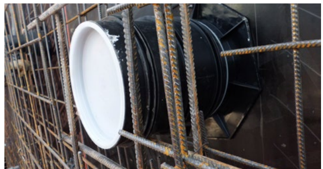
UFR in Schalung
