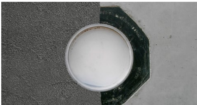
Betoniertes UFR mit PMBC
