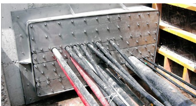
Geteilter Rechteck-Flansch mit Mehrfachbelegung
