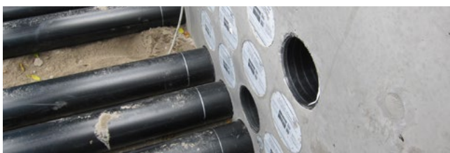
HSI150 GSM Varia als Paket eingesetzt
