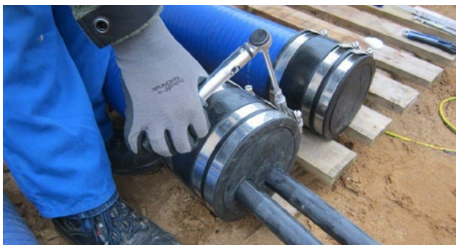
Druckdichter Anschluss des Hateflex14090 an die Dichtpackung HSI90 sowie Endabschluss für das Kabelschutzrohr
