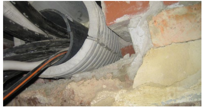
FZRG150/350 - Renovierung Mauerwerk
