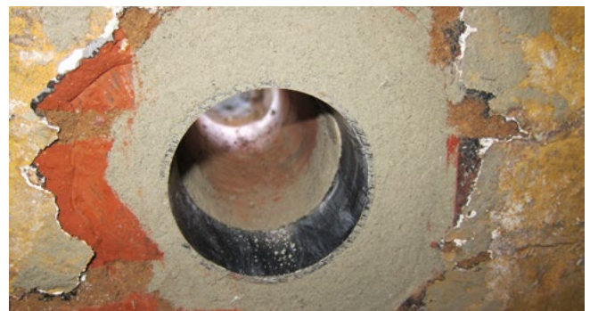
SFR nachträglich im Mauerwerk eingearbeitet
