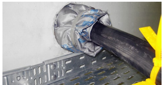
HSS - Einbau in Kernbohrung mit HRD Ringraumdichtungen
