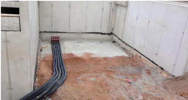
Wellrohranschluss HSI90 D1x75 KS WR
