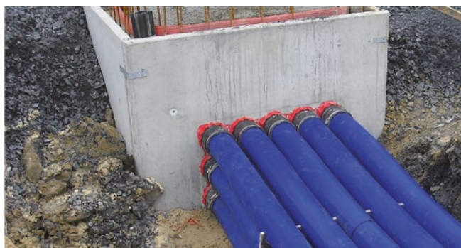
KES MA90 D - Anschluss an Dichtpackung HSI90
