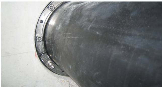
Detailansicht - HSD, Kontrollöffnung und Anzugsreihenfolge der Schrauben
