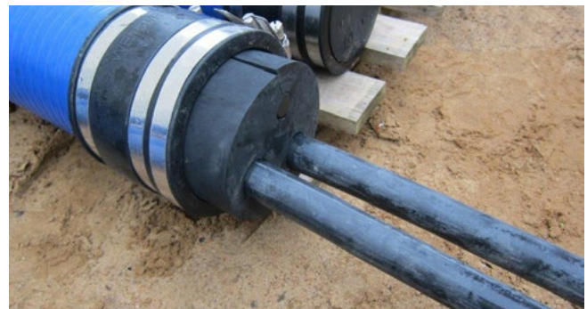
Druckdichter Anschluss des Spiralschlauches Hateflex14150 an die Dichtpackung HSI150 sowie Endabschluss für das Kabelschutzrohr
