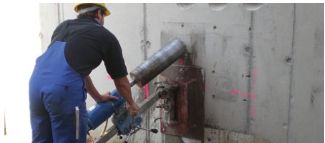
Herstellen von vertikal und horizontal verlaufenden Diamantschrägburbohrungen für die Aufnahme von HRD-Dichteinsätzen
