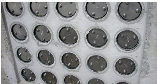
FZR100/240 Abdichtung Rohrtrasse
