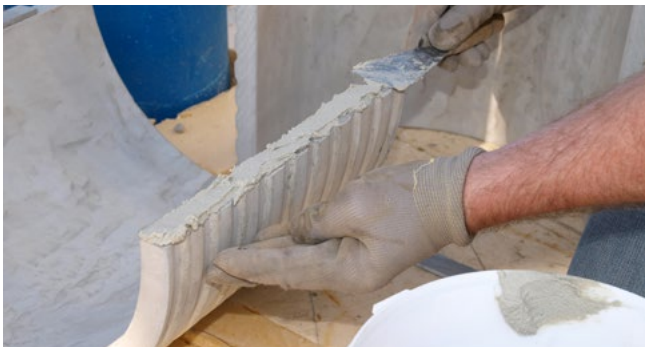
FZRG350/300 mit Spachtelmasse aus Montageset MSET FZRG
