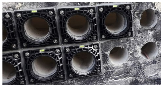
HSI150 DFK Kunststoffflansch
