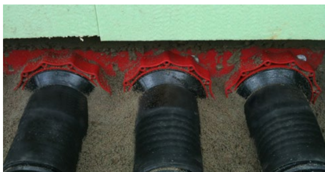
Wellrohranschluss mit Kaltschrumpftechnik HSI150 D1x110 KS WR
