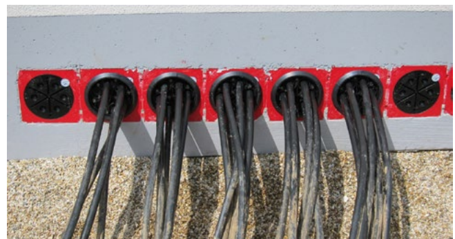
Abdichtung von Niederspannungskabeln mit HSI150 DG 6x10-36
