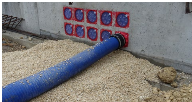
Druckdichter Anschluss an die HSI150-Dichtpackungen
