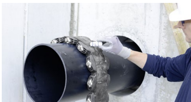
GKD400 - Montagevorbereitung mit Gleitmittel GM
