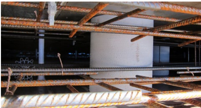
ZVR200/300 in der Schalung fixiert
