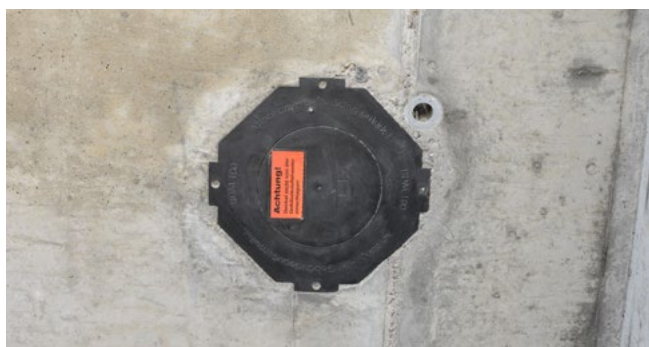
Praxisbild UDM/UDME in betonierter Wand
