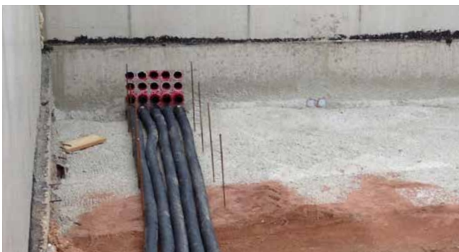
Wellrohranschluss HSI90 D1x75 KS WR
