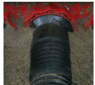
Wellrohranschluss mit Kaltschrumpftechnik HSI150 D1x110 KS WR
