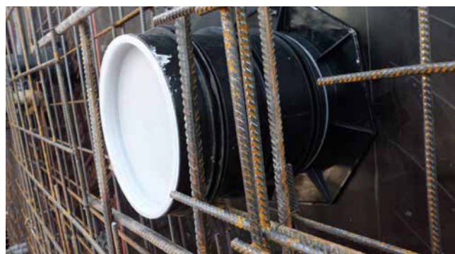
UFR in Schalung
