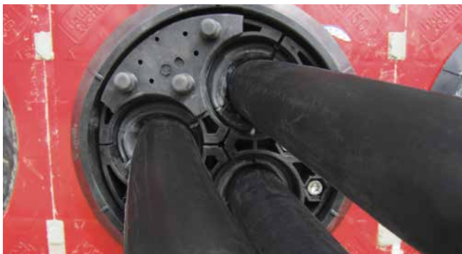
Pressplattenabdeckung HSI150 DG PA 3x24-54
