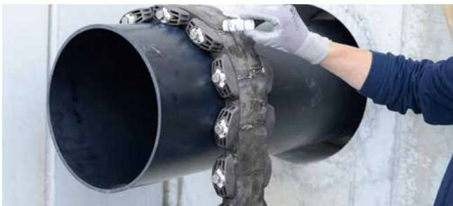
GKD400 – Montagevorbereitung mit Gleitmittel GM
