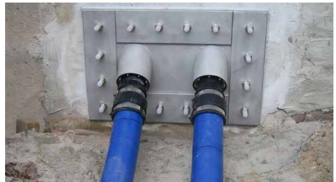
Fest-/Losflansch mit schräger Leerrohranbindung vor Flächenabdichtung
