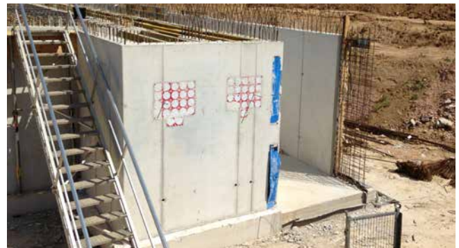
Paket HSI90 Doppel-Dichtpackungen nach dem Betonieren: Hier folgt der Leerrohranschluss
