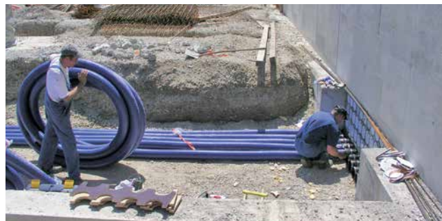
Verlegung Kabeleinführungssystem KES-M 150 mit Manschettentechnik
