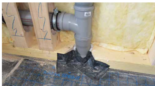
Schwierigkeit: Einbindung der Dampfsperre
