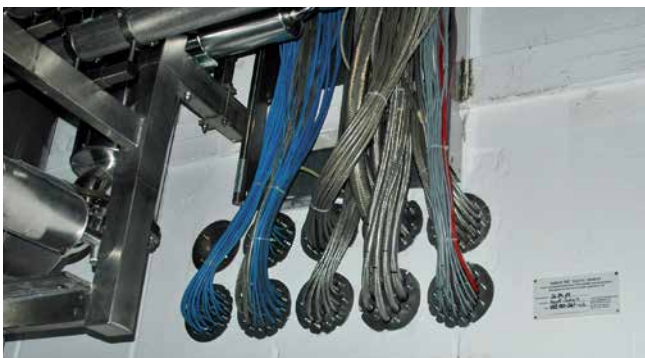
HRD150 G b30 mit Mehrfachbelegung
