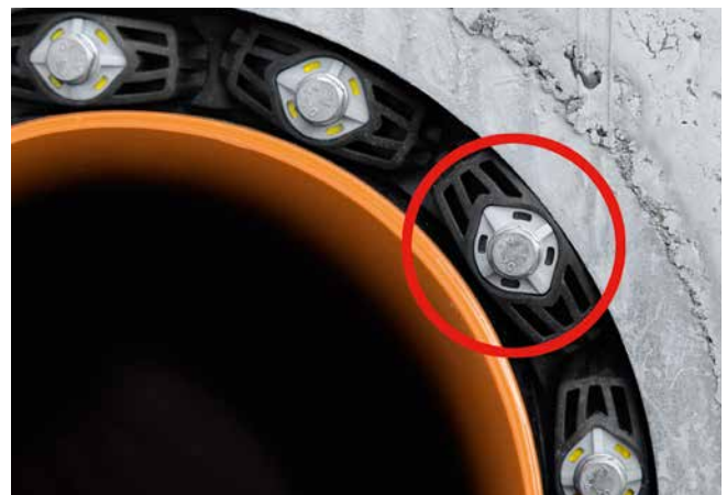
GKD mit einem nicht angezogenen Segment – Montagefehler sofort erkannt.
