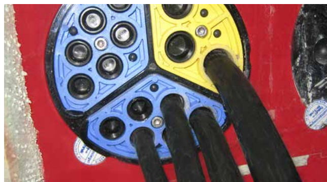
HSI150 SEGMENTO mit integrierter Drehmomentkontrolle und Blindstopfen
