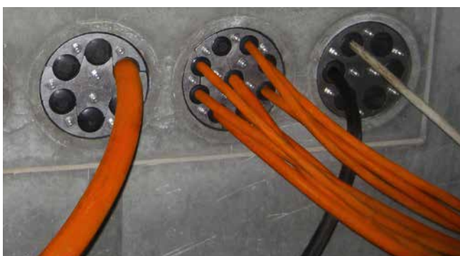
HRD150 SG eingebaut in Faserzementfutterrohre
