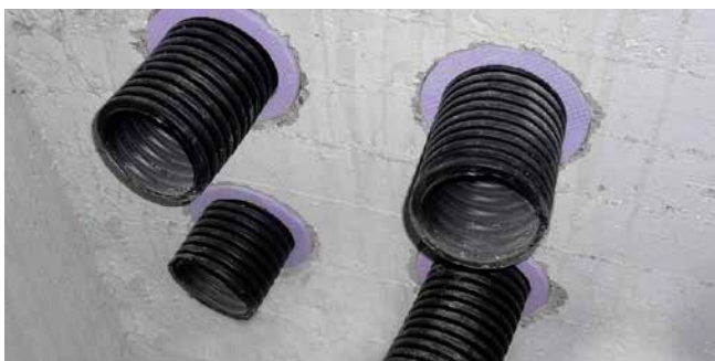
Ansicht Gebäudeinnenseite (Isoring)
