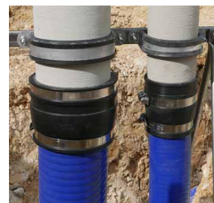
Reihenanzordnung 2x KES MA150 ZVR150/500 an der Aufstellvorrichtung KES FUBO-FIX AV
