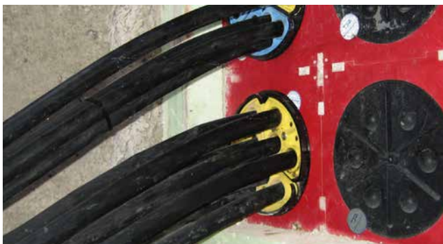
Abdichtung von Kabeln für Straßenbeleuchtung mit SEGMENTO
