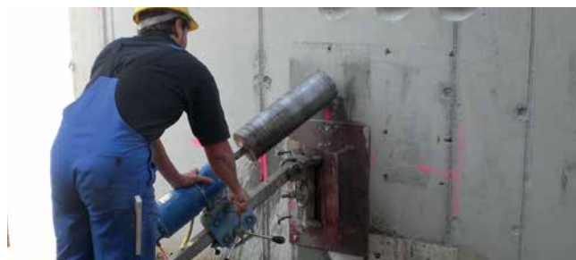
Herstellen von vertikal und horizontal verlaufenden Diamantschrägborkernbohrungen für die Aufnahme von HRD-Dichteinsätzen
