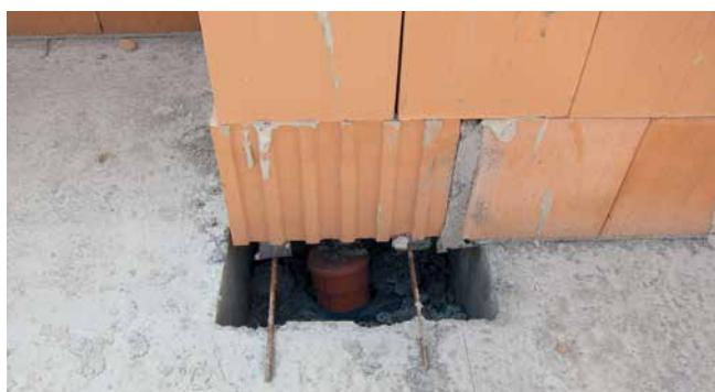
Schwierigkeit: nachträglicher gas- und dampfdichter Verschluss
