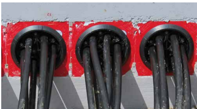
Abdichtung von Niederspannungskabeln mit HSI150 DG 6x10-36
