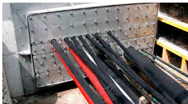
Geteilter Rechteck-Flansch mit Mehrfachbelegung
