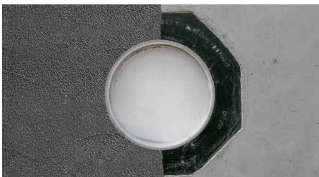
Betoniertes UFR mit PMBC
