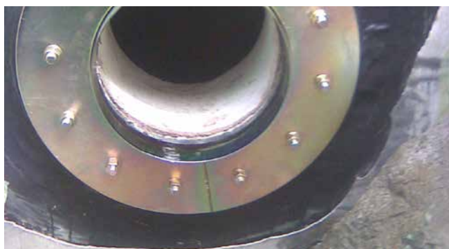
FLFA 400 A3C Entwässerungsanbindung
