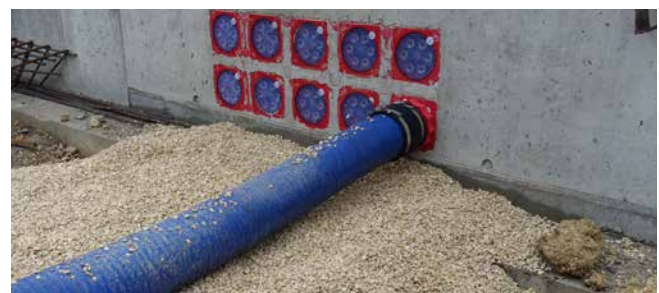
Anschluss des Kabeleinführungssystems KES MA150 D
