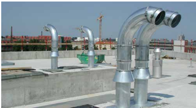
Montierte SHD200 vor Verlegung der Dachabdichtung
