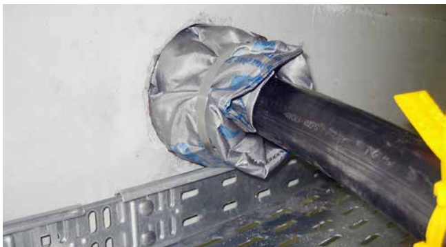
HSS – Einbau in Kernbohrung mit HRD Ringraumdichtungen
