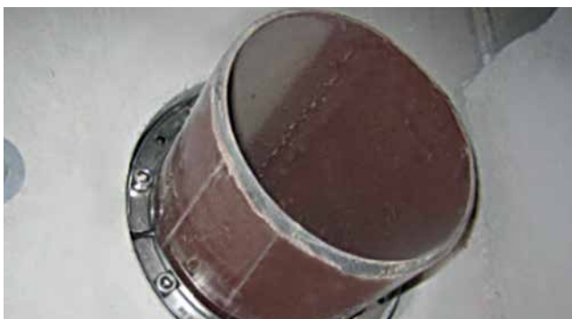
HSD200 1x160 b40 A2/EPDM55 Entwässerung SML Rohr
