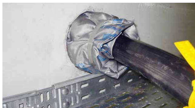
HSS – Einbau in Kernbohrung mit HRD Ringraumdichtungen
