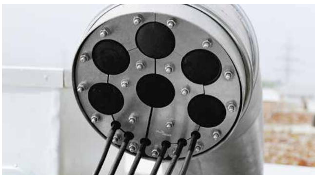
Montierter Dichteinsatz SKD in Schwanenhals SHD200
