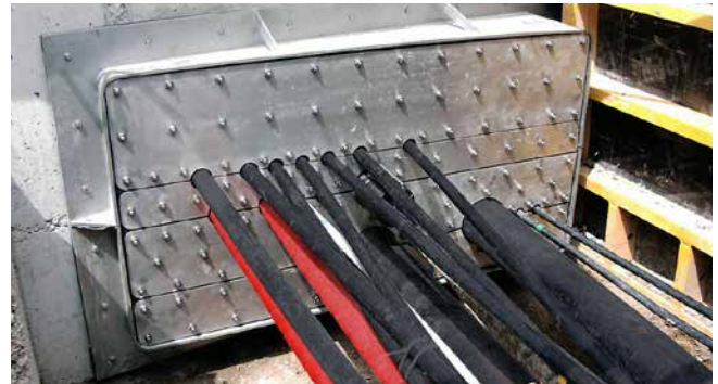
Geteilter Rechteck-Flansch mit Mehrfachbelegung
