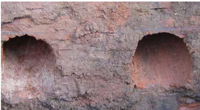
Schräge Kernbohrung in porösem Mauerwerk
