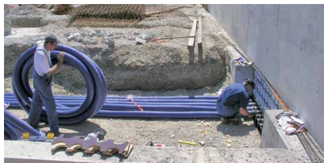
Verlegung Kabeleinführungssystem KES-M 150 mit Manschettentechnik
