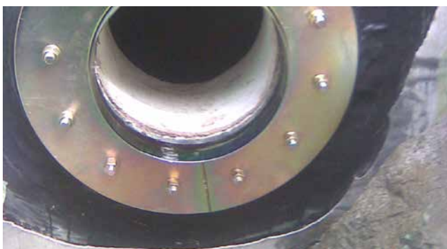
FLFA 400 A3C Entwässerungsanbindung
