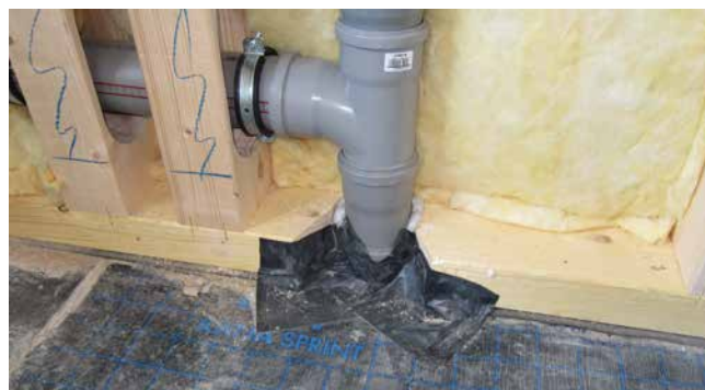
Schwierigkeit: Einbindung der Dampfsperre
