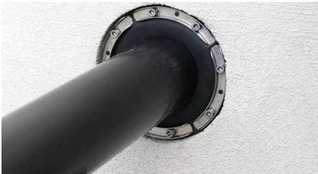
HSD200 1x159 b20 A2/EPDM55 „Schachtabdichtung“
