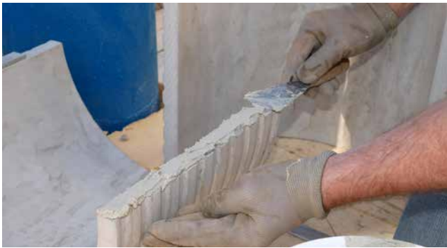
FZRG350/300 mit Spachtelmasse aus Montageset Z-FZR-G
