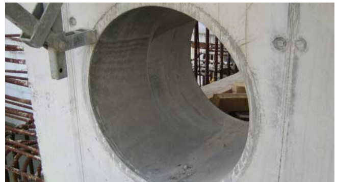
FZR400/300 Einbauort Kläranlage
