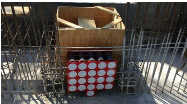
Einbau von Doppeldichtpackung HSI90 vor dem Betonieren
