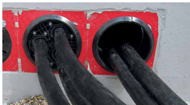
Verschiedene Montageschritte bei HSI150 DG 3x24-54
