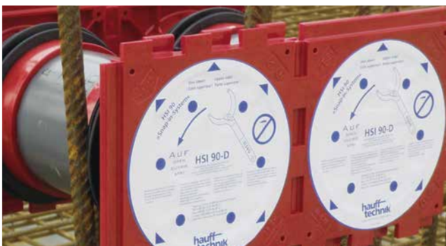
Doppeldichtpackung HSI90 als Paket in Schalung eingesetzt
