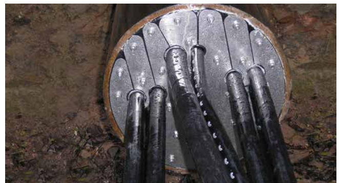
HRD200 G b30 in einem Stahlrohr
