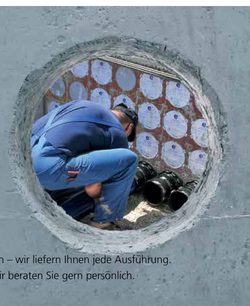
Herstellen von vertikal und horizontal verlaufenden Diamantschrägburungen für die Aufnahme von HRD-Dichteinsätzen
