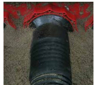
Wellrohranschluss mit Kaltschrumpftechnik HSI150 D1x110 KS WR
