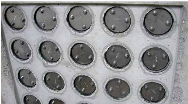
FZR100/240 Abdichtung Rohrtrasse
