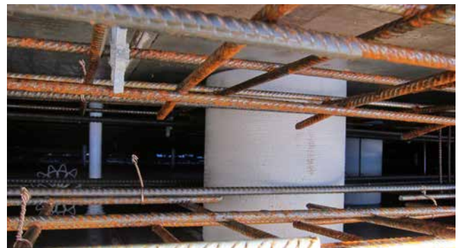
ZVR200/300 in der Schalung fixiert
