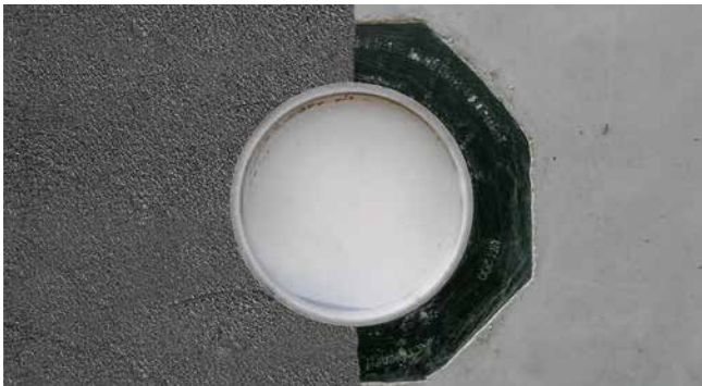
Betoniertes UFR mit PMBC
