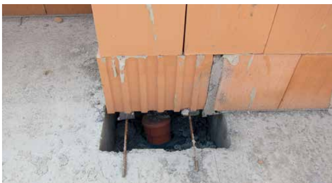
Schwierigkeit: nachträglicher gas- und dampfdichter Verschluss
