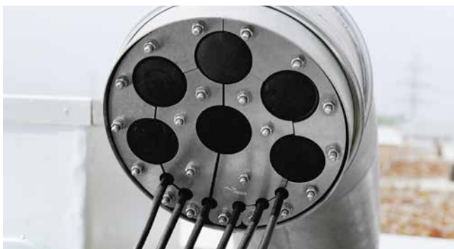
Montierter Dichteinsatz SKD in Schwanenhals SHD200
