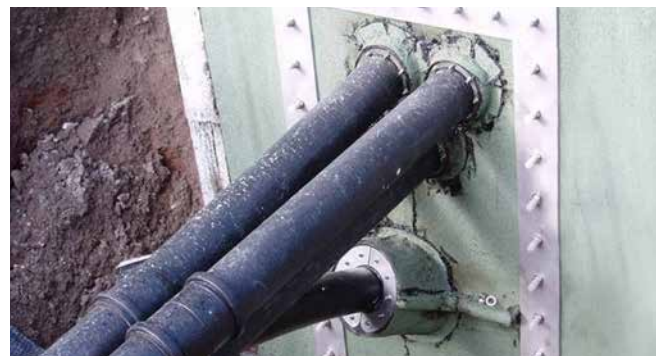
Geteilter Fest-/Losflansch in Anlehnung an DIN 18533
