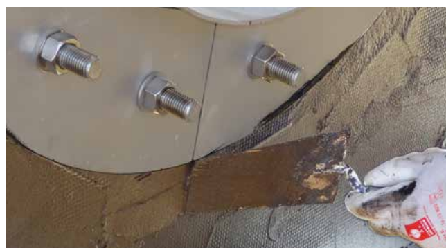
FLFE 1x200/X Edelstahlausführung mit Anbindung an PMBC mittels Vlies-Zulage, s. Seite 81 und Folgende
