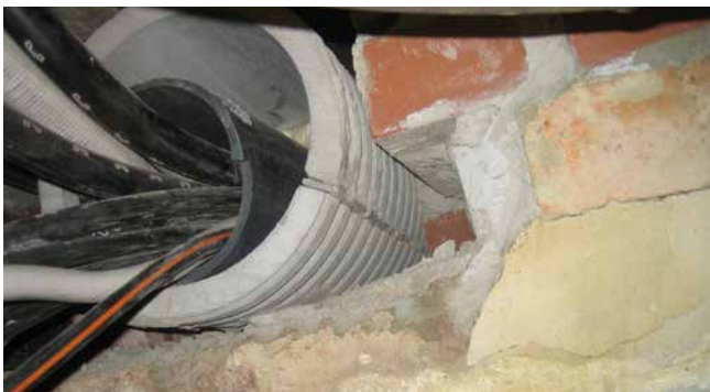
FZR100 / 240 Abdichtung Rohrtrasse
