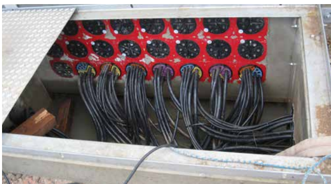
HSI150 – Dichtpackungen bestückt mit SEGMENTO-Abdichtung von Steuerleitungen in einem Schalthaus
