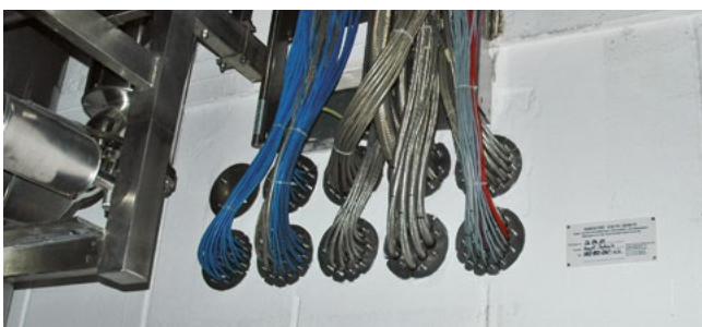
HRD150 G b30 mit Mehrfachbelegung
