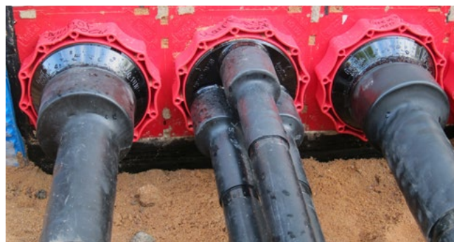
Zentrierband im Systemdeckelstutzen des HSI150 D3x58 WS
