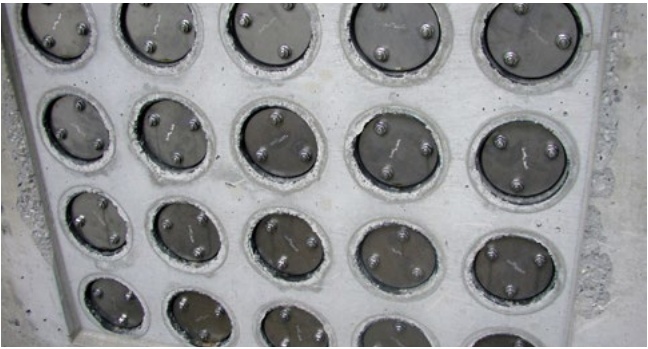
FZR100/240 Abdichtung Rohrtrasse
