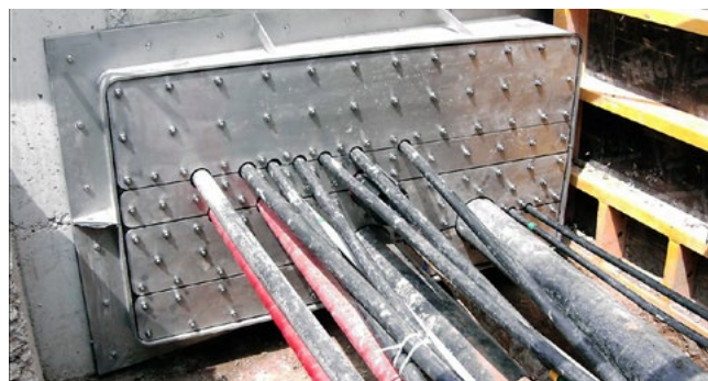
Geteilter Rechteck-Flansch mit Mehrfachbelegung
