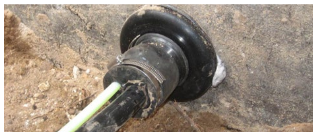
Eingebaute MIS90D
