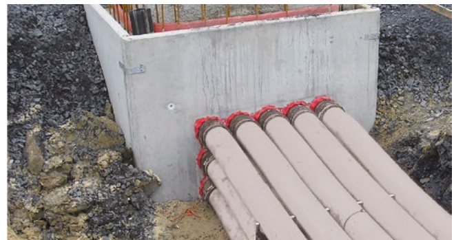
KES MA90 D - Anschluss an Dichtpackung HSI90
