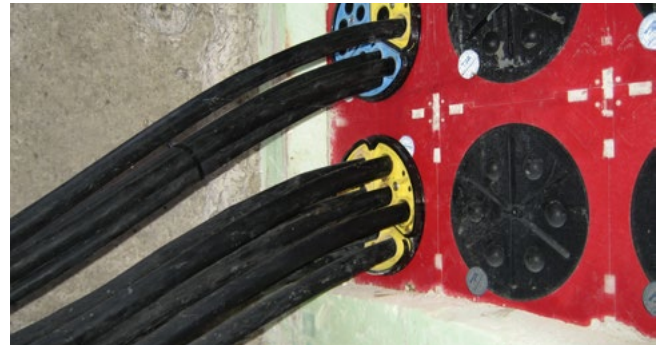
Abdichtung von Kabeln für Straßenbeleuchtung mit SEGMENTO
