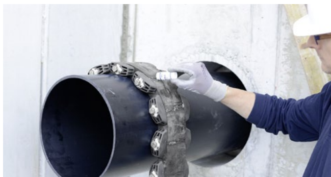
GKD400 - Montagevorbereitung mit Gleitmittel GM
