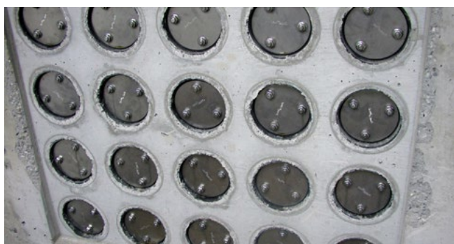
FZR100/240 Abdichtung Rohrtrasse
