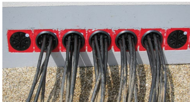
Abdichtung von Niederspannungskabeln mit HSI150 DG 6x10-36
