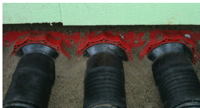
Wellrohranschluss mit Kaltschrumpftechnik HSI150 D1x110 KS WR
