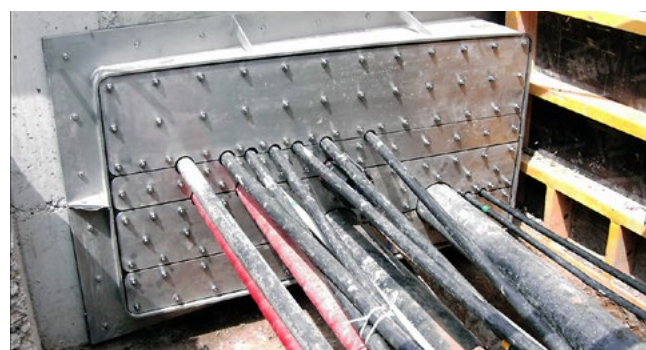
Geteilter Rechteck-Flansch mit Mehrfachbelegung
