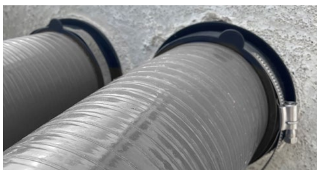
HSI150 KMA, Einfach-Dichtpackung mit klappbarer Gummimanschette, Anschluss Hatreflex
