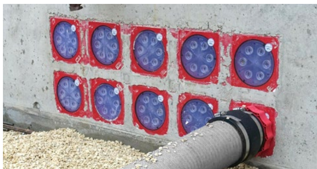
Druckdichter Anschluss an die HSI150-Dichtpackungen
