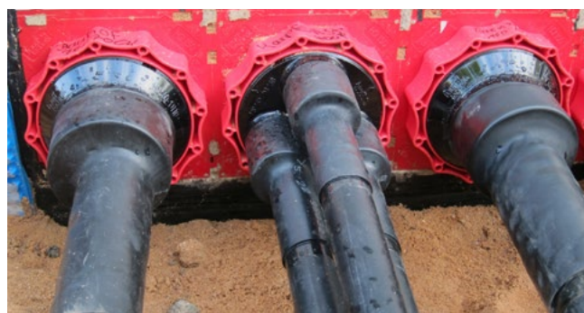
Zentrierband im Systemdeckelstutzen des HSI150 D3x58 WS
