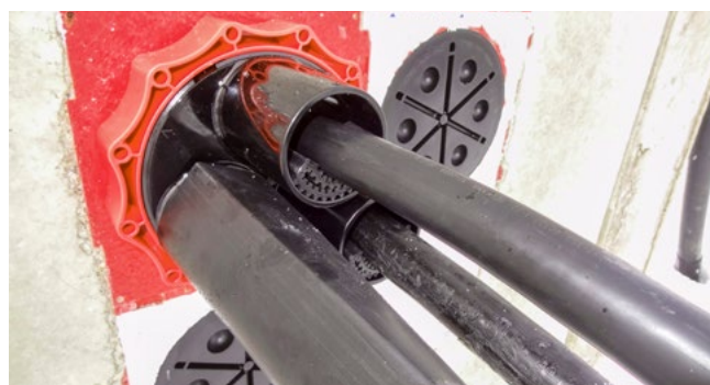
Zentrierband im Systemdeckelstutzen des HSI150 D3x58 WS
