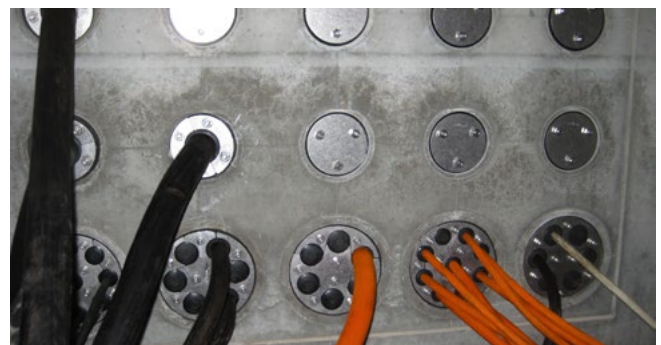
HRD150 SG eingebaut in Faserzementfutterrohre
