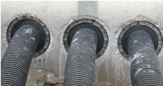
Detailansicht: Clipping/Dichtung
