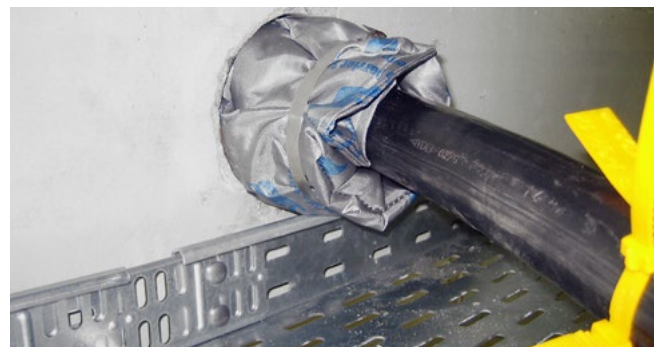
HSS - Einbau in Kernbohrung mit HRD Ringraumdichtungen
