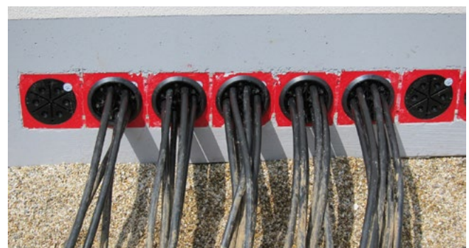
Abdichtung von Niederspannungskabeln mit HSI150 DG 6x10-36
