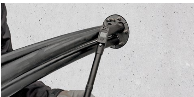
HRD150 PV G in Kernbohrung
