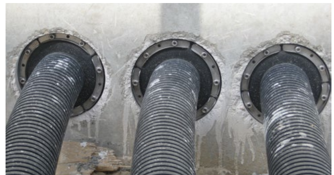
Detailansicht: Clipping/Dichtung
