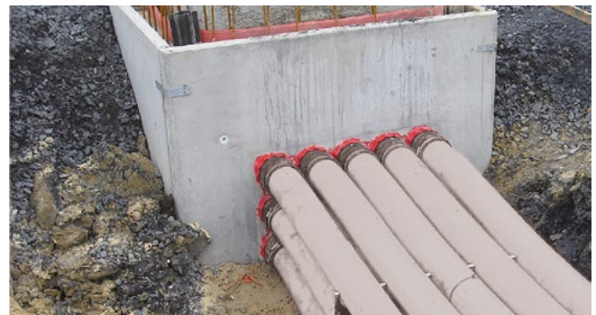
KES MA90 D - Anschluss an Dichtpackung HSI90
