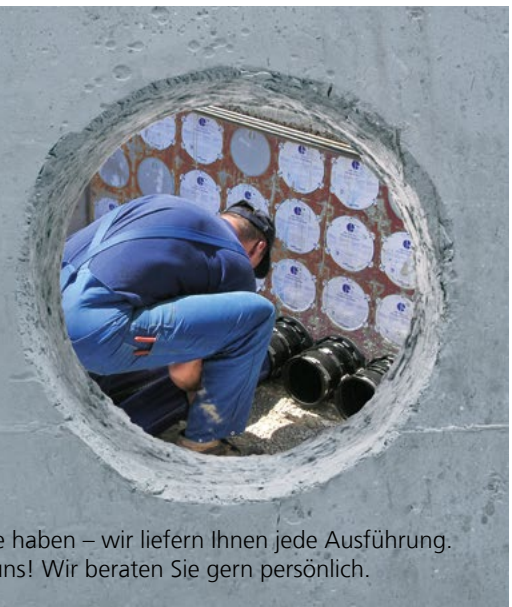
Herstellen von vertikal und horizontal verlaufenden Diamantschrägborungen für die Aufnahme von HRD-Dichteinsätzen
