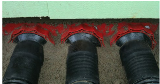
Wellrohranschluss mit Kaltschrumpftechnik HSI150 D1x110 KS WR
