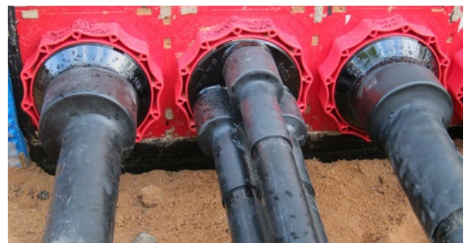
Zentrierband im Systemdeckelstutzen des HSI150 D3x58 WS
