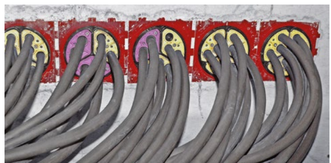
Kabelzug durch HSI-Dichtpackungen mit SEGMENTO-Systemeinsätzen
