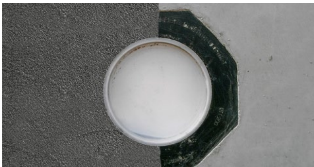
Betoniertes UFR mit PMBC
