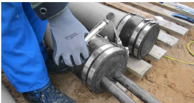
Druckdichter Anschluss des Hateflex14090 an die Dichtpackung HS190 sowie Endabschluss des Kabelschutzrohres
