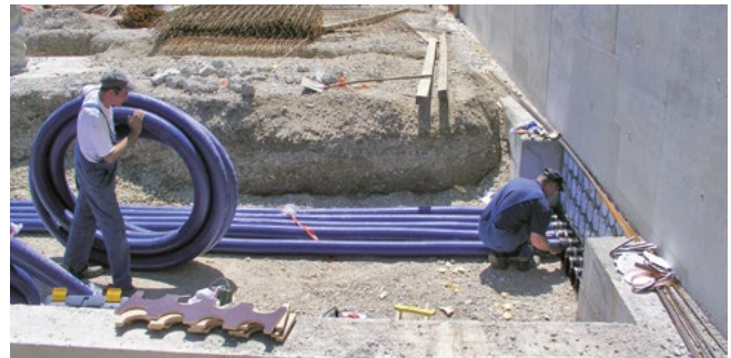
Verlegung Kabeleinführungs-System KES150 MA mit Manschettentechnik
