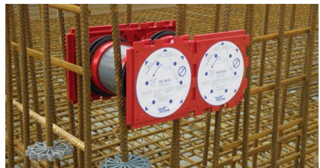
Doppeldichtpackung HSI90 als Paket in Schalung eingesetzt
