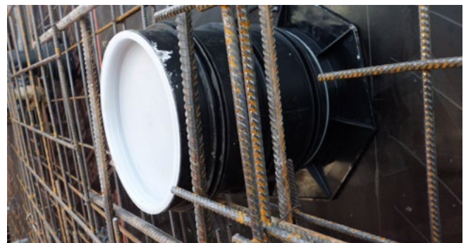
UFR in Schalung
